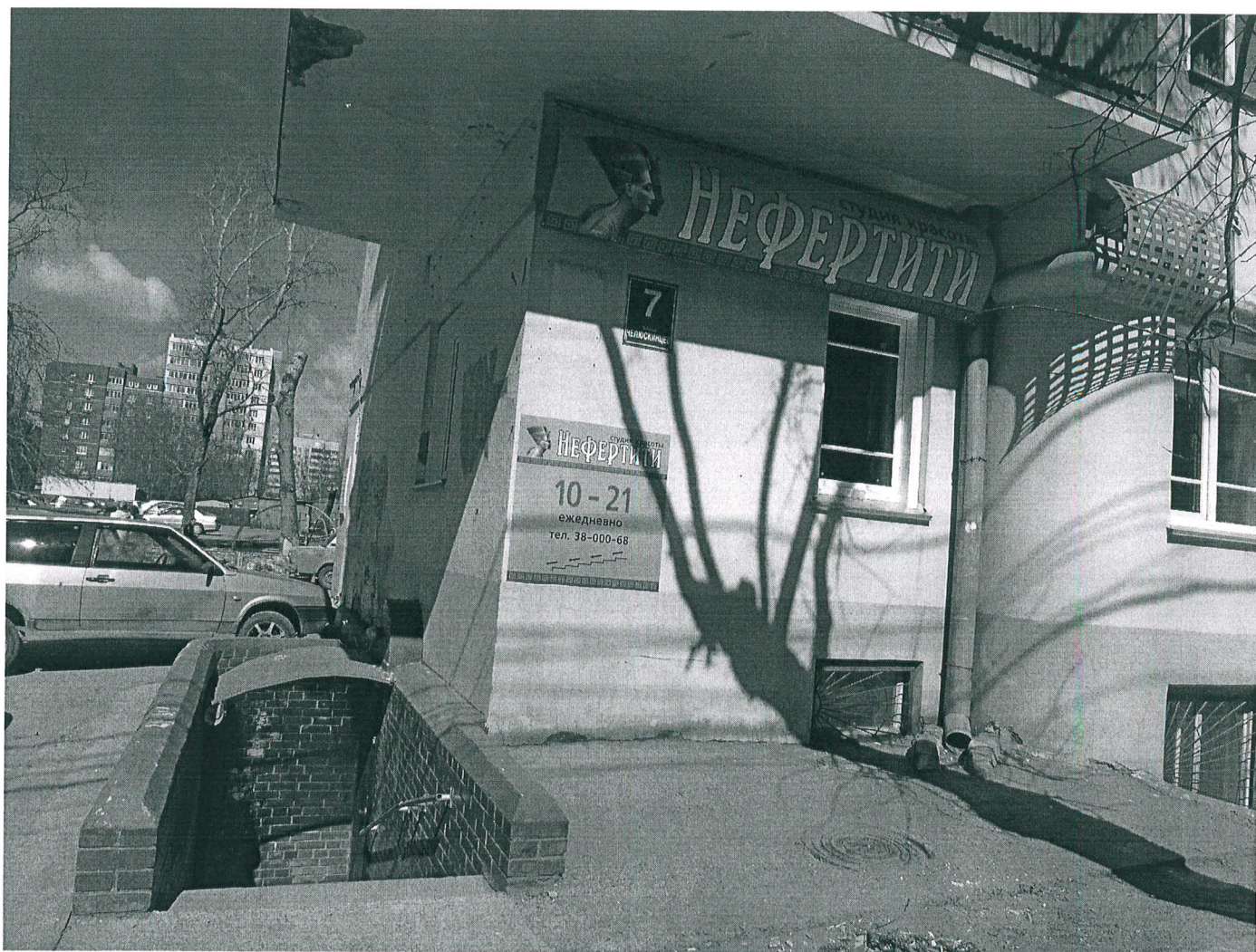
Главный юго-восточный фасад (материалы согласования в архиве НПЦ отсутствуют). Подлежит демонтажу.
