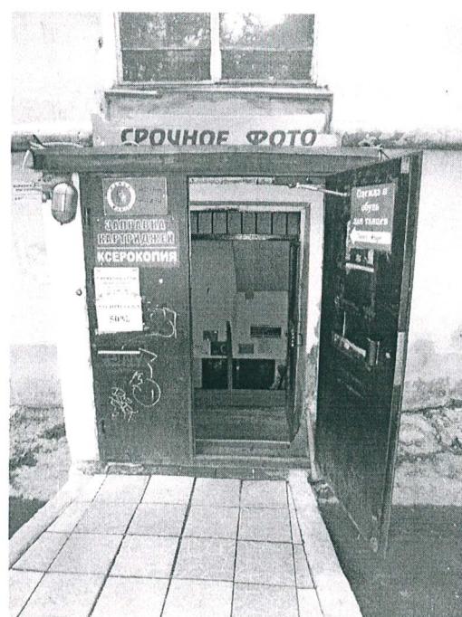
Главный северо-восточный фасад (материалы согласования в архиве НПЦ отсутствуют). Подлежит демонтажу.
