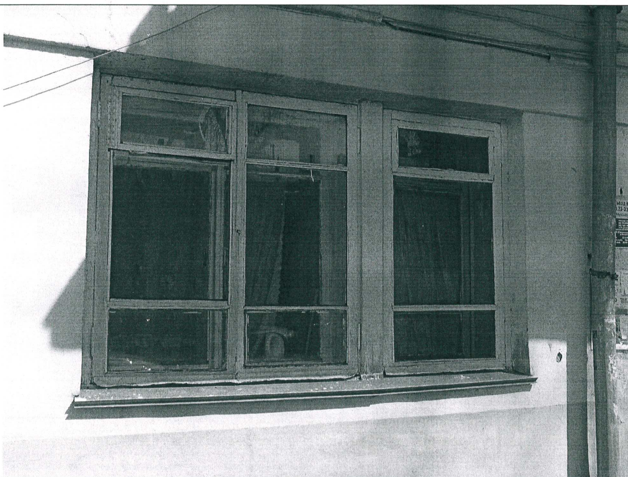
4.19. Фрагмент дворового фасада. Первоначальное окно 1 этажа.
