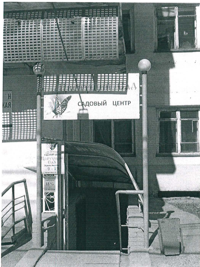
Главный юго-восточный фасад (материалы согласования в архиве НПЦ отсутствуют). Подлежит демонтажу.
