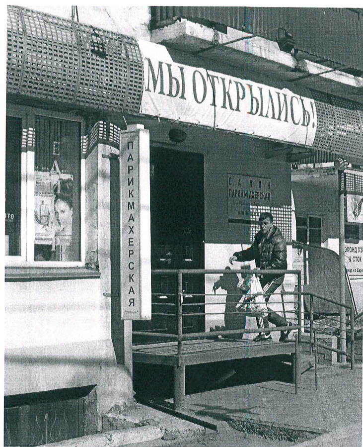
Главный юго-восточный фасад (материалы согласования в архиве НПЦ отсутствуют). Подлежит демонтажу.
