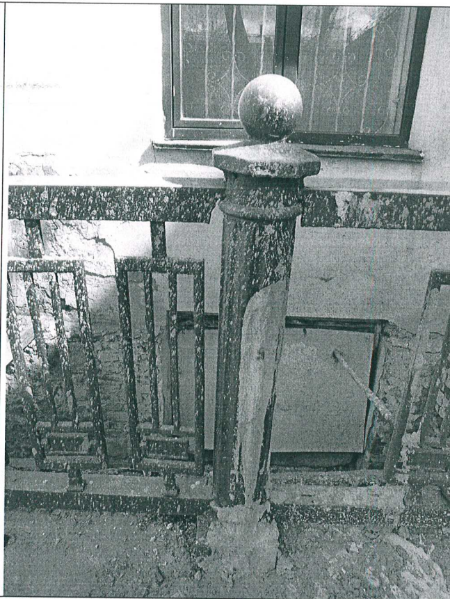
4.10. Фрагмент первоначального ограждения прямка спуска на дворовом фасаде.
