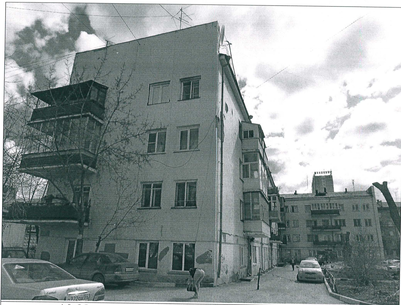
4.5. Общий вид торцевого (северо-западного) и дворовых фасадов.
