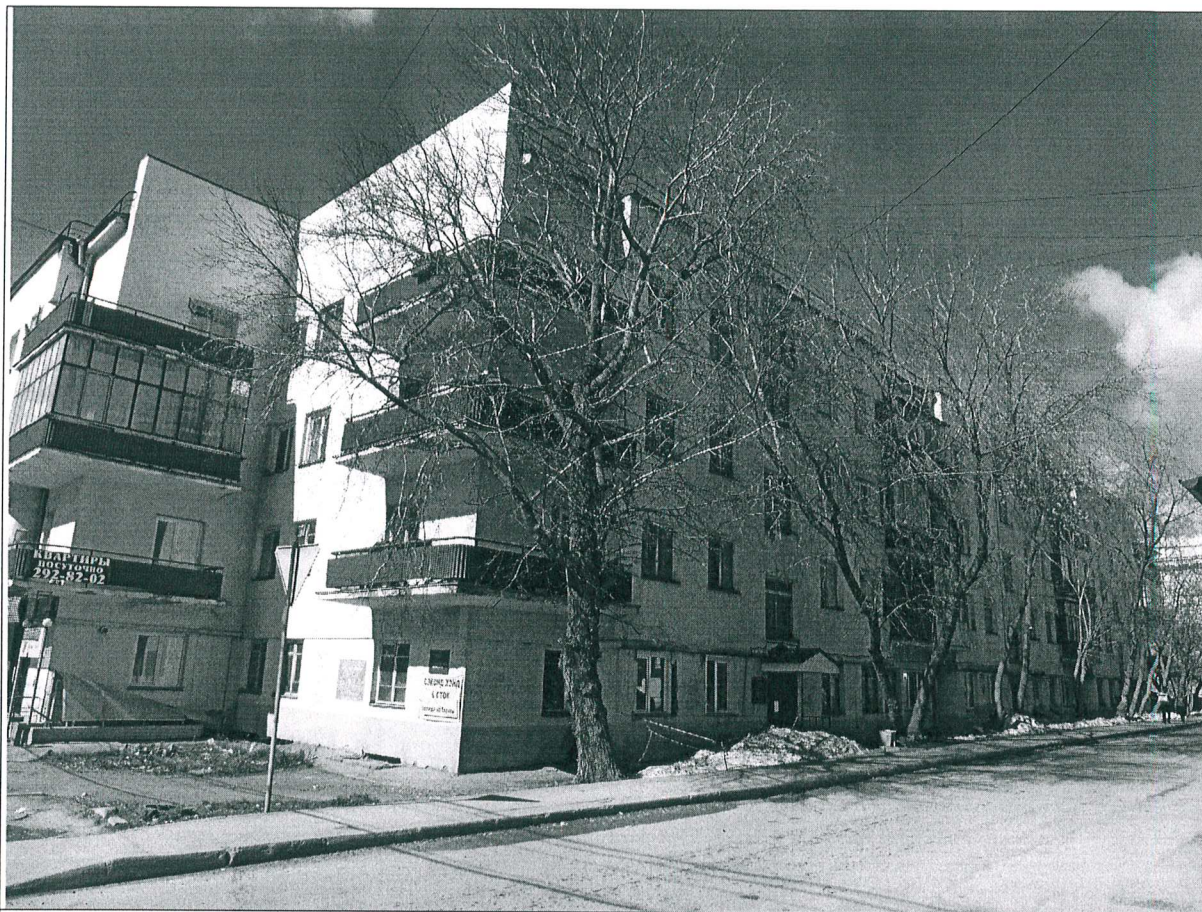
4.3. Общий вид северо-восточных фасадов со стороны ул. Омская.
