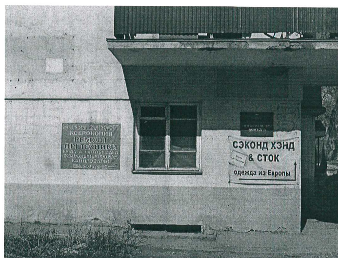
Главный юго-восточный фасад (материалы согласования в архиве НПЦ отсутствуют). Подлежит демонтажу.
