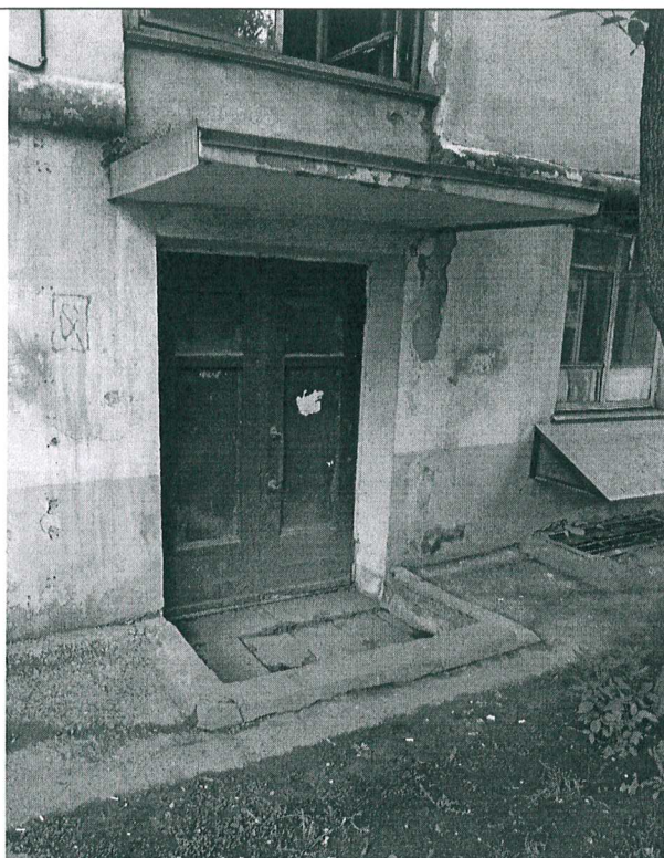
4.17. Первоначальный парадный вход со стороны ул. Омская.
