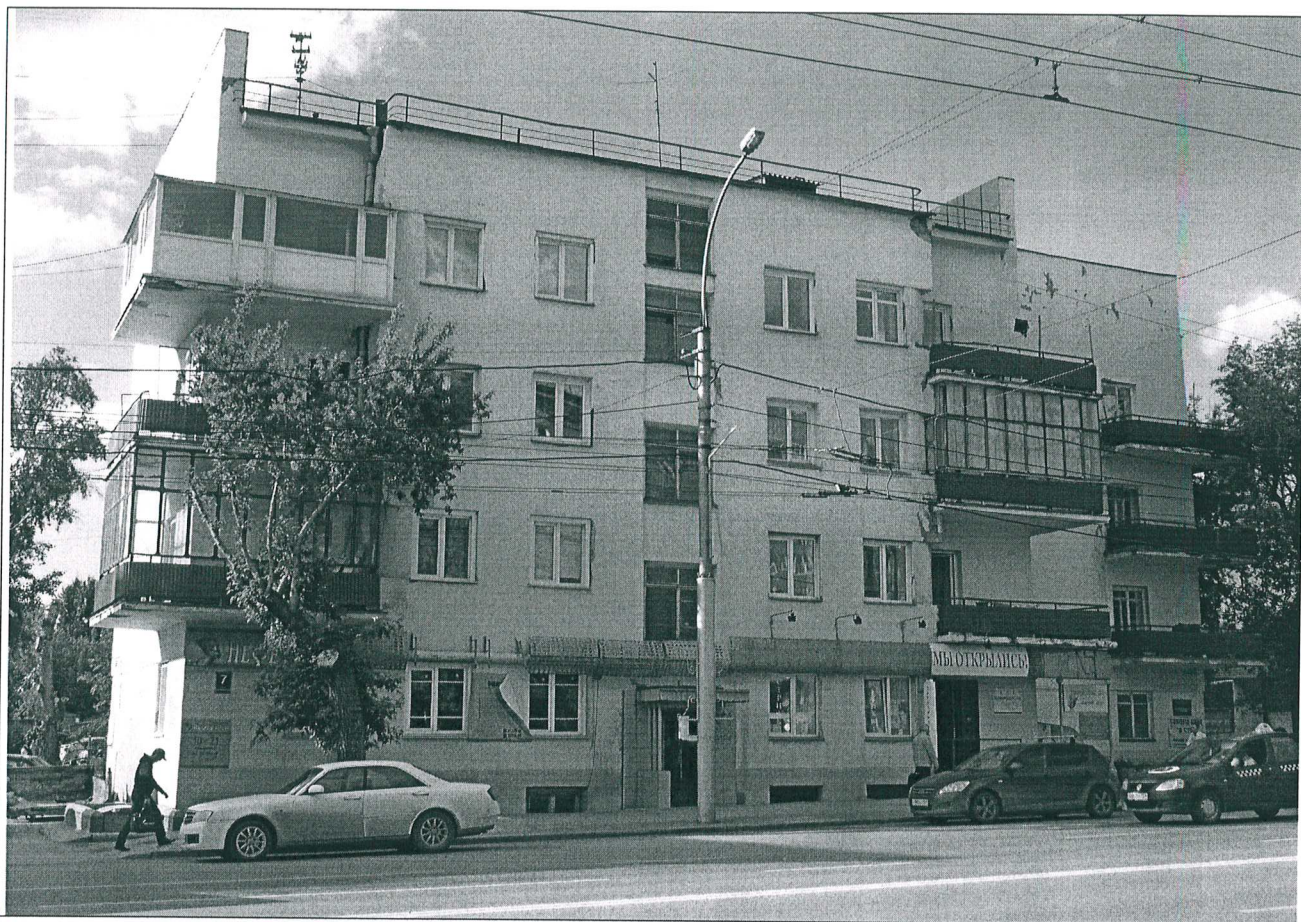
4.1. Общий вид юго-восточного (главного) фасада со стороны ул. Челюскинцев.
