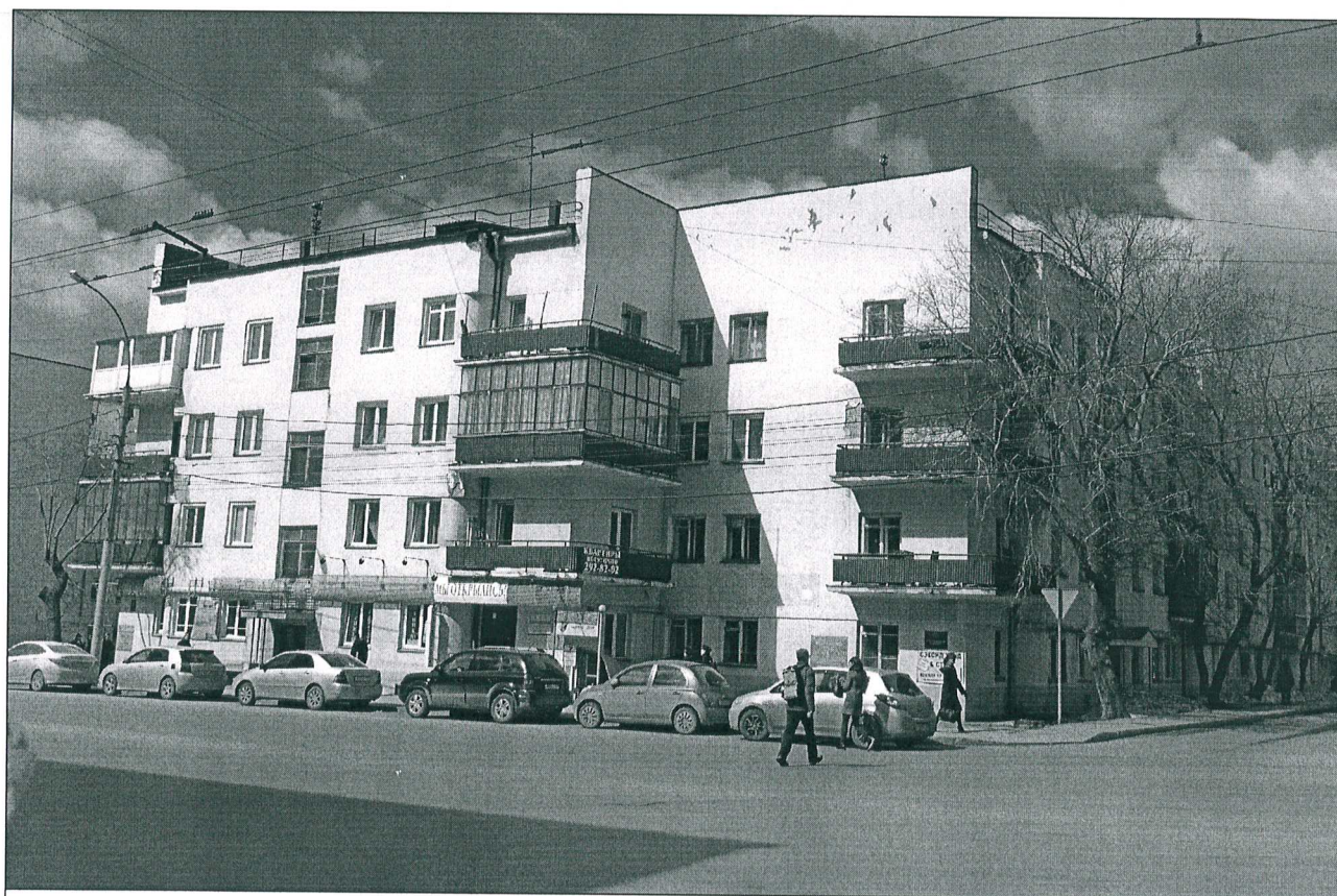
4.2. Общий вид главных фасадов.
