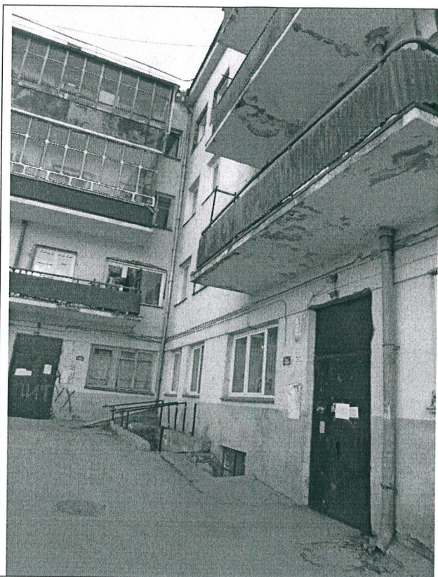
4.11. Фрагмент дворового (северо- западного) фасада.
