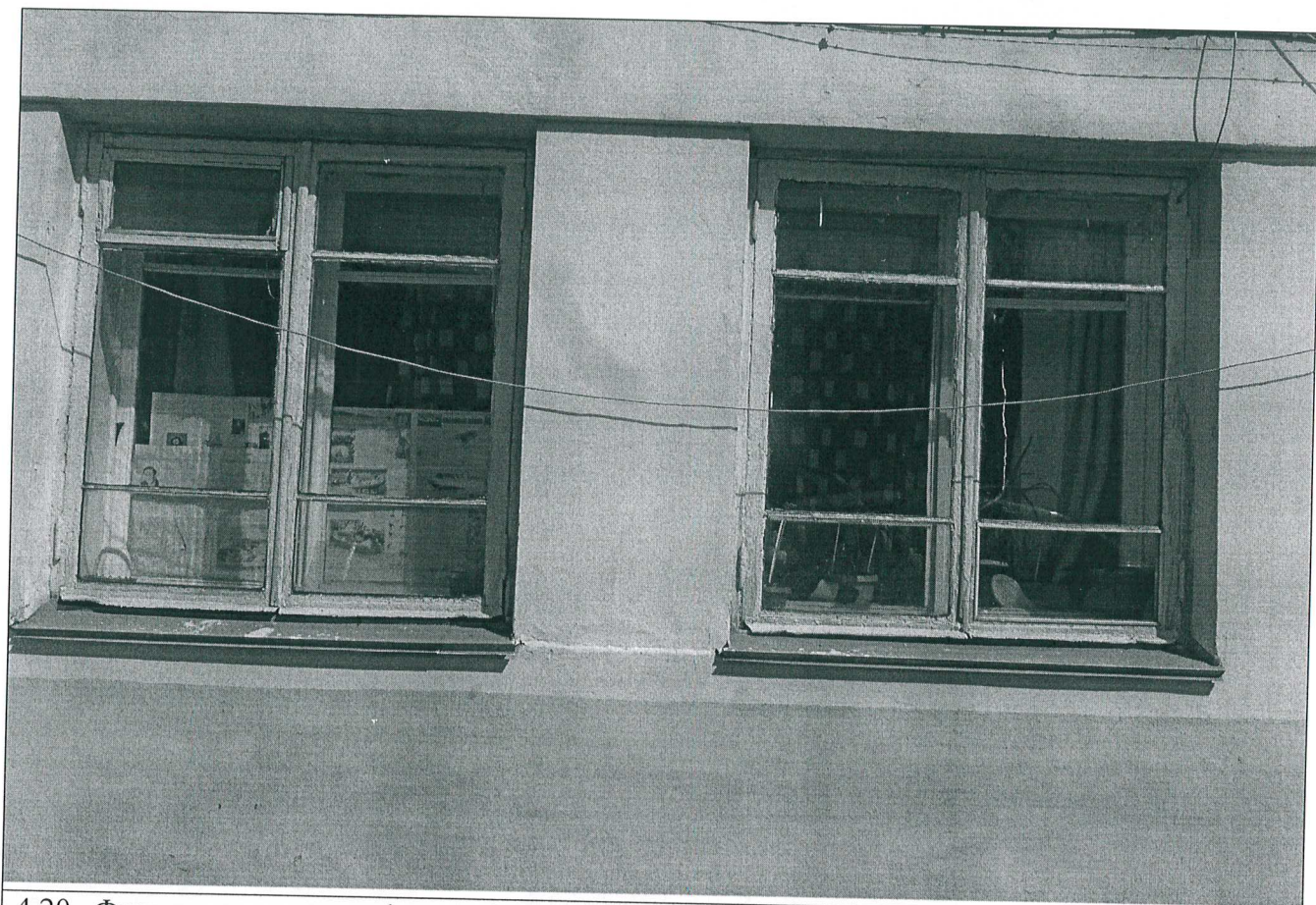
4.20. Фрагмент дворового фасада. Первоначальные окна 1 этажа.
