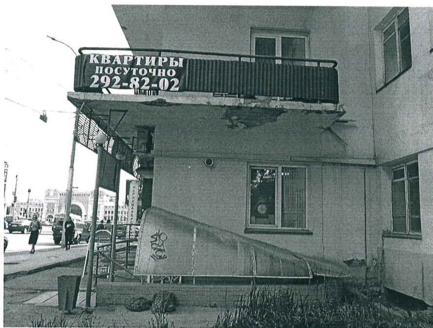
Главный северо-восточный фасад (материалы согласования в архиве НПЦ отсутствуют). Подлежит демонтажу.
