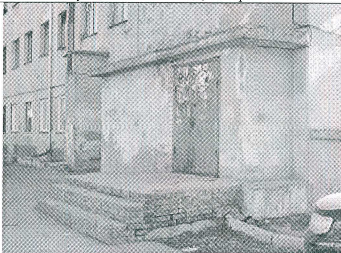
23. Эвакуационный выход, северный объем
