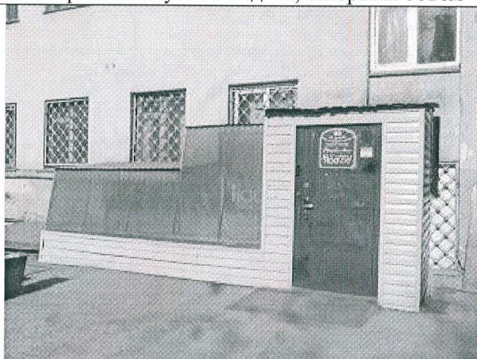
24. Прямок спуска в подвал, северный объем
