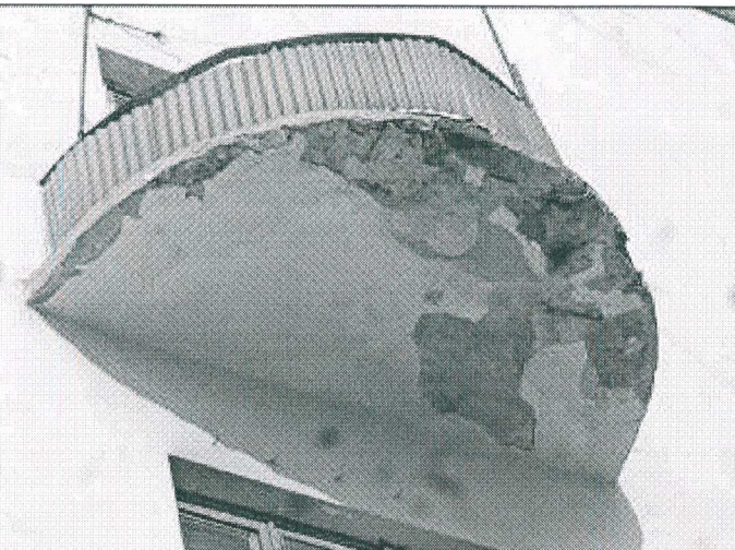
36. Балкон на юго-восточном торцевом фасаде, 4-й этаж
