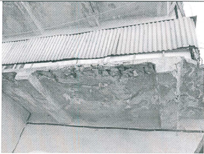
35. Балкон на юго-восточном фасаде северного объема
