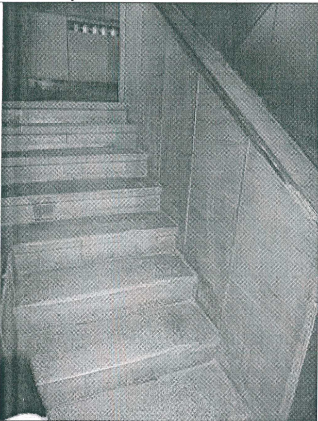
45. Южная лестничная клетка южного объема, спуск в подвальные помещения
