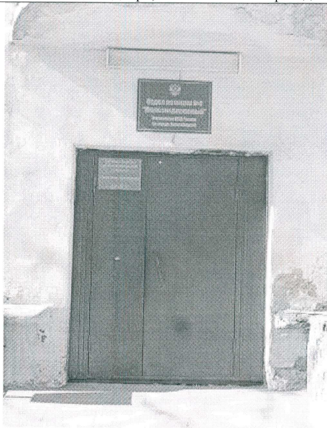
15. Входная дверь, юго-восточный фасад
