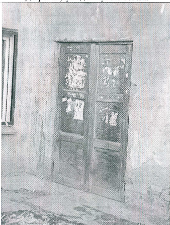
18. Эвакуационный выход, юго-восточный (дворовый) фасад северного объема
