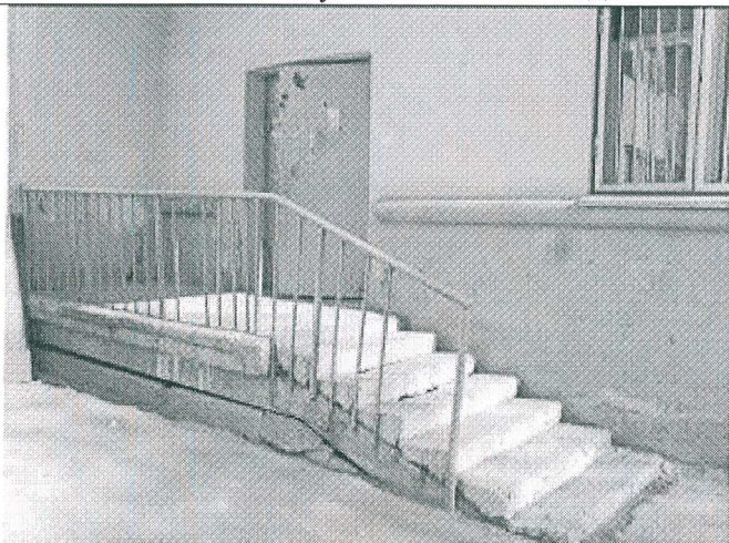
19. Входной узел главного входа
