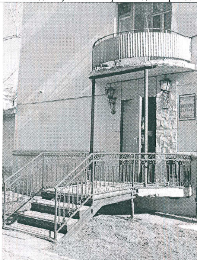
16. Входной узел на северо-западном фасаде
