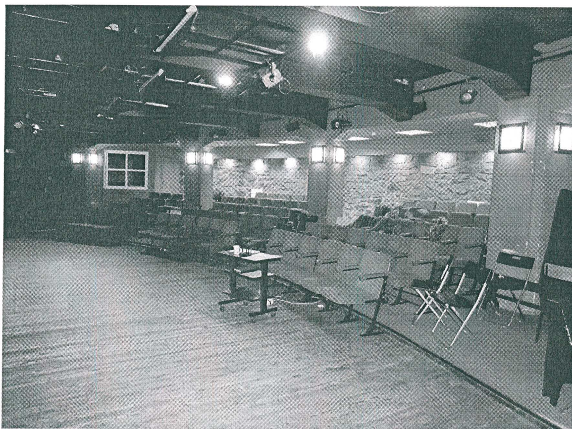
22. Балочная система потолков в подвале. Колонны.
