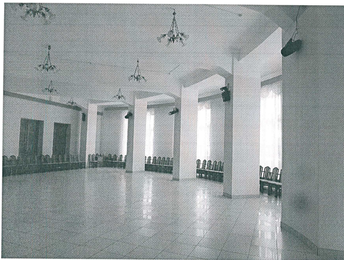
24. Балочная система потолков фойе второго этажа. Колонны.
