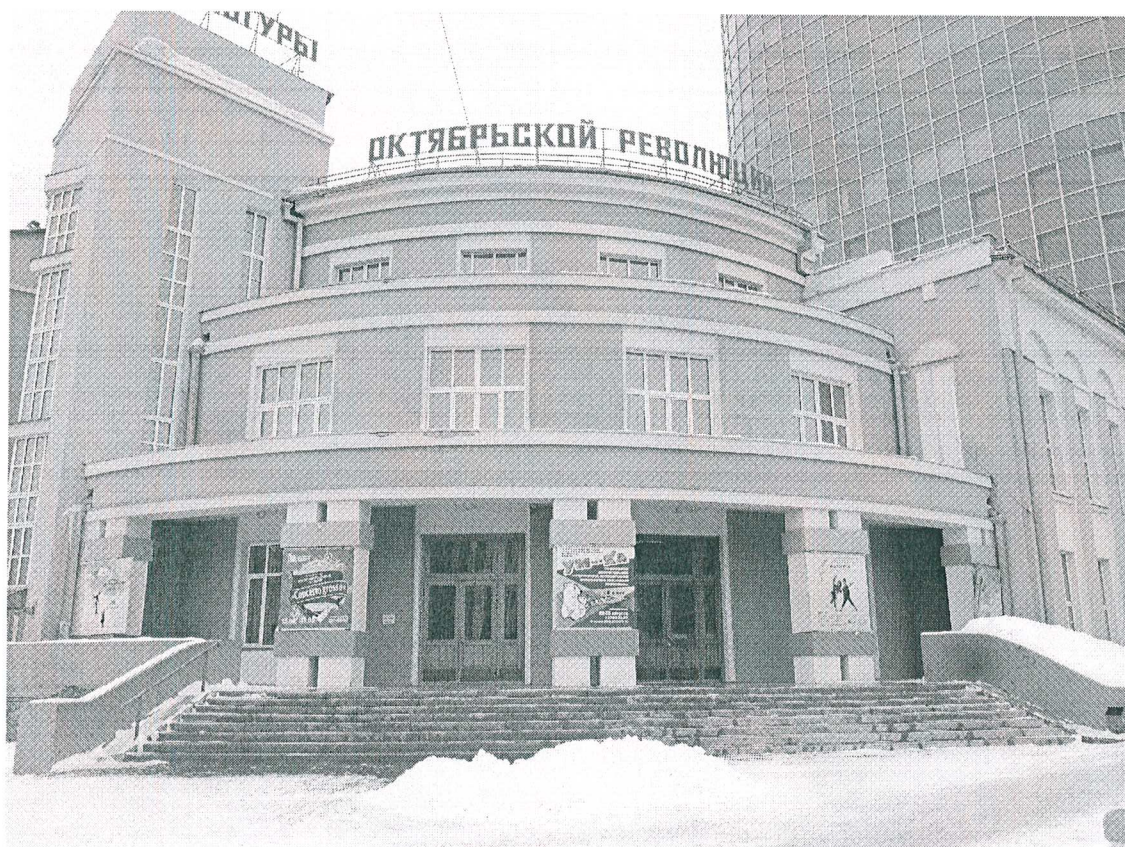
12. Крыльцо главного входа. Балконы.
