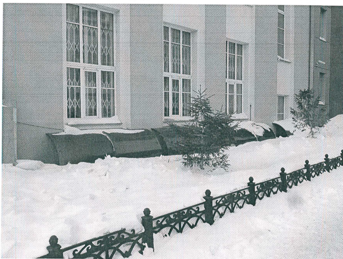
19. Покрывтие приямков со стороны восточного фасада.
