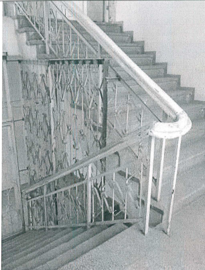
26. Фрагмент западной лестничной клетки
