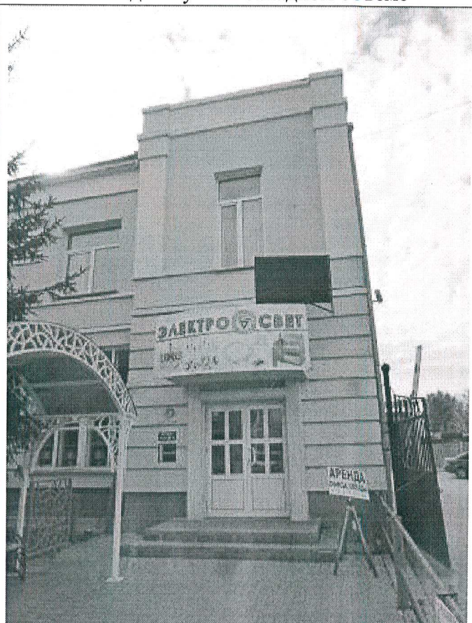
7. Входной узел в западном объеме
