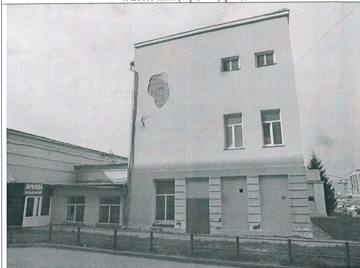
4. Восточный (торцевой) фасад
