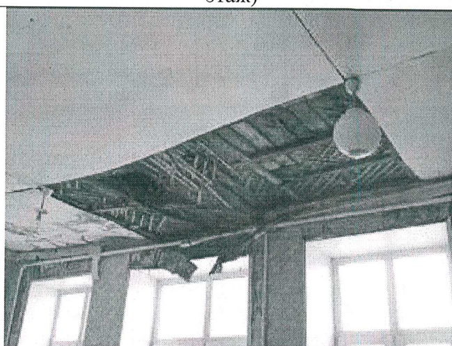
35. Отпадение элементов отделки потолка в местах протечки (восточный объем, третий этаж)
