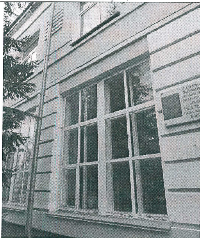
12. Первоначальные оконные переплеты, главный фасад
