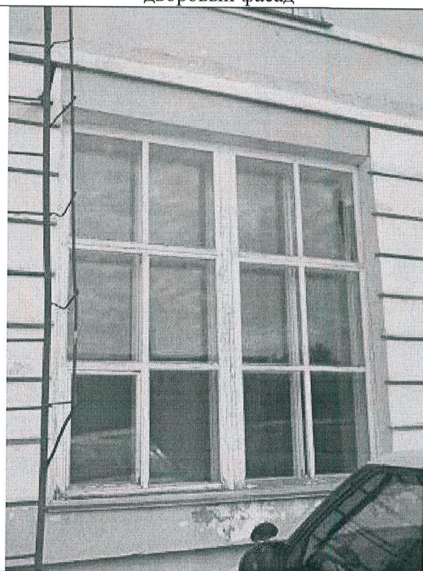
13. Первоначальные оконные переплеты, дворовый фасад
