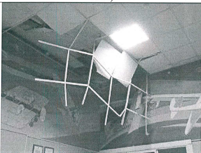
34. Отпадение элементов отделки потолка в местах протечки (помещение музея, первый этаж)
