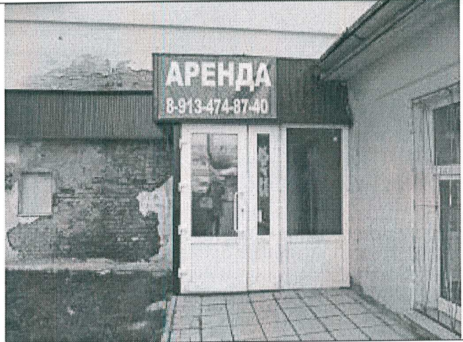
16. Входной узел в восточном объеме
