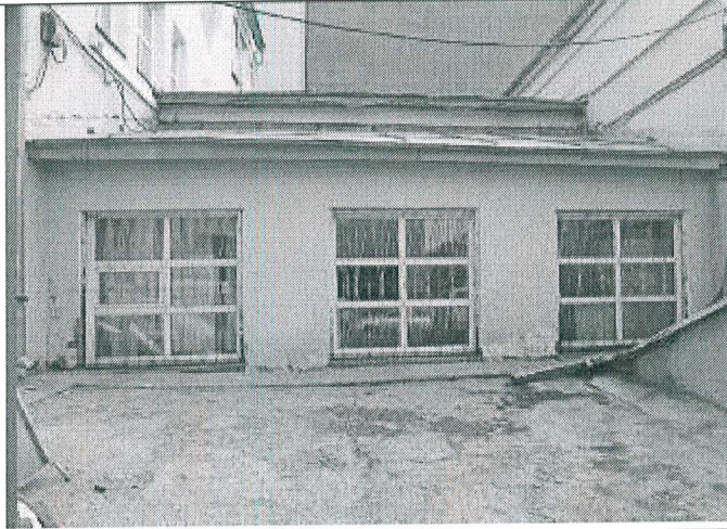
14. Фрагмент дворового фасада
