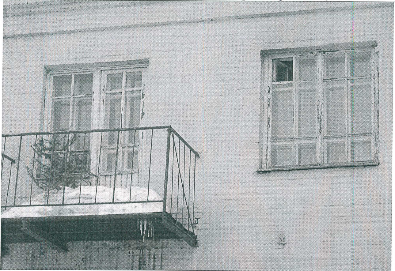
7. Первоначальные балконный и оконный блоки, фото из архива НПЦ, 2013 год
