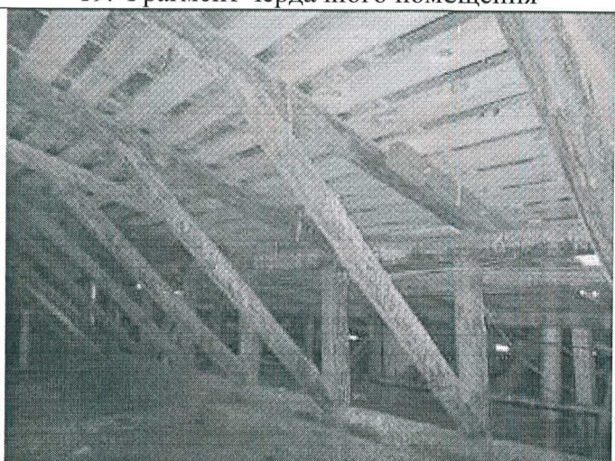
19. Фрагмент чердачного помещения
