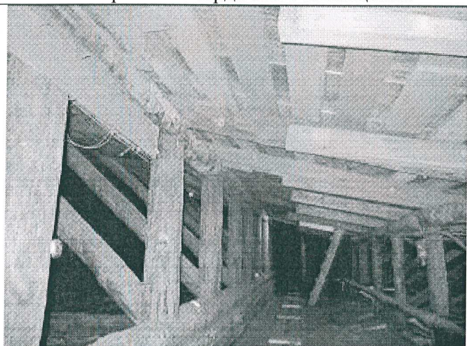
18. Фрагмент чердачного помещения
