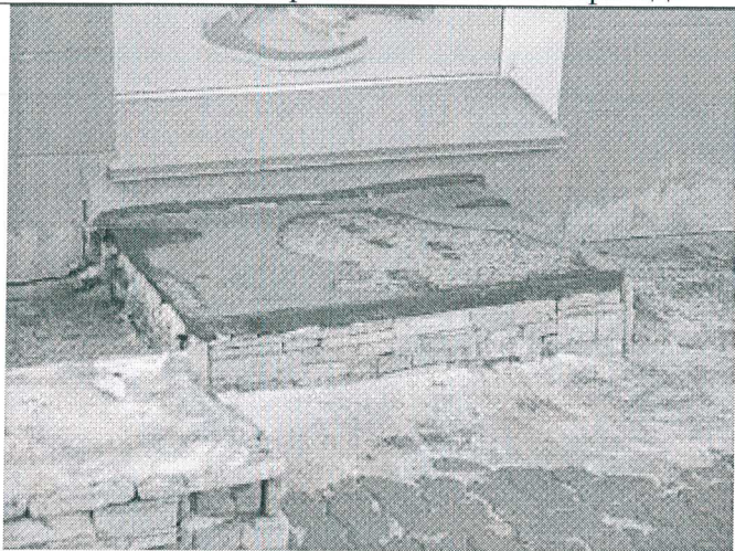
10. Световой приямок на главном фасаде
