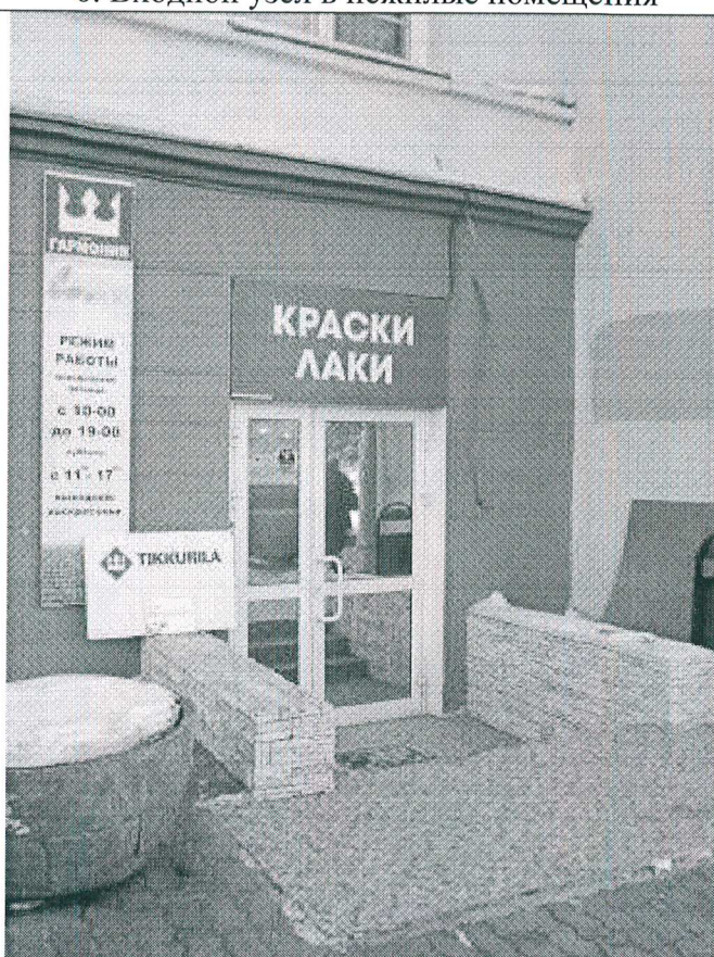
6. Входной узел в нежилые помещения
