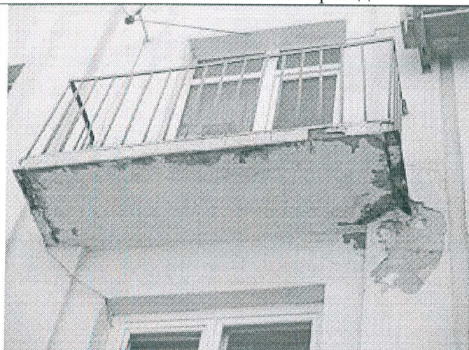
16. Балкон на главном фасаде
