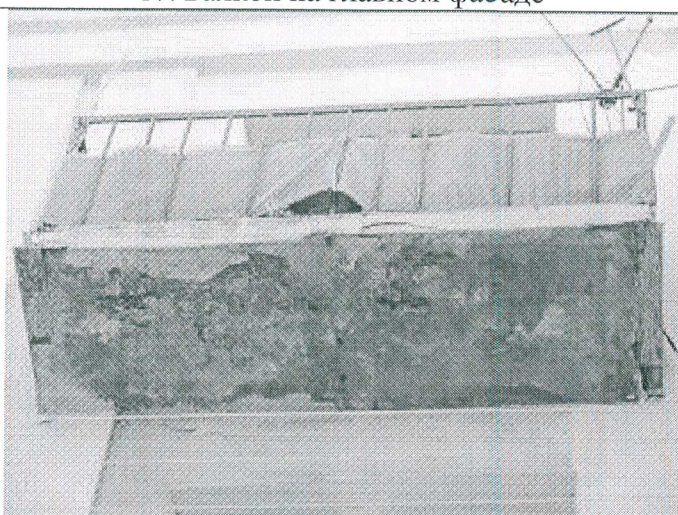
17. Балкон на главном фасаде
