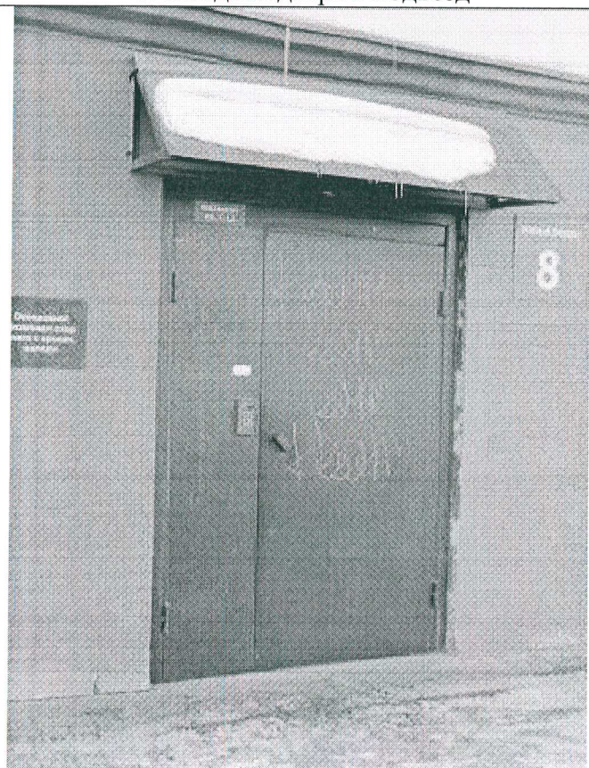
5. Входная дверь в подъезд
