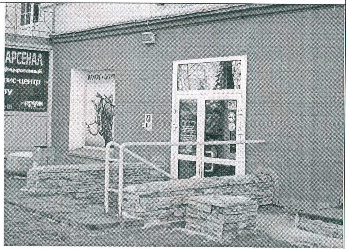
9. Входной узел в нежилые помещения
