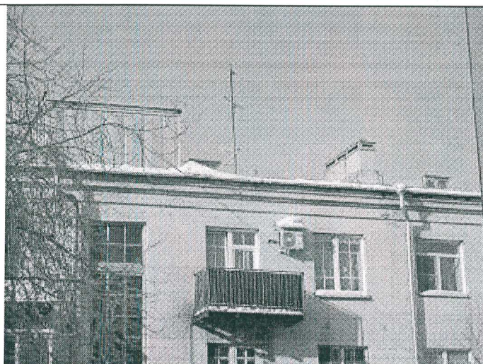
20. Фрагмент крыши, вид со стороны двора
