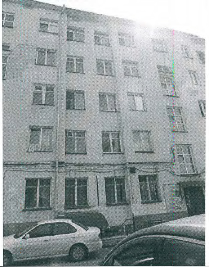
6. Фрагмент дворового фасада (южный объем)
