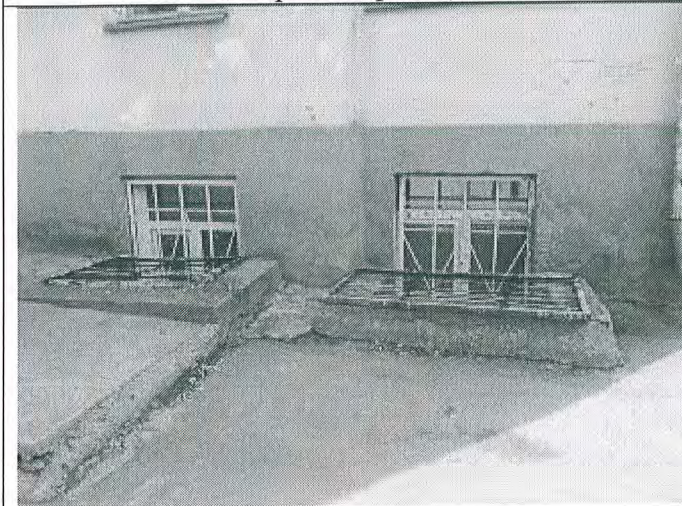
23. Световые приемки (южный объем, дворовый фасад)
