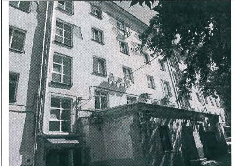
49. Воздуховоды на дворовом фасаде
