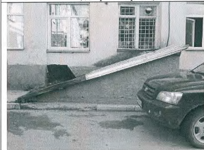
25. Приемок спуска в подвал (центральный объем, дворовый фасад)
