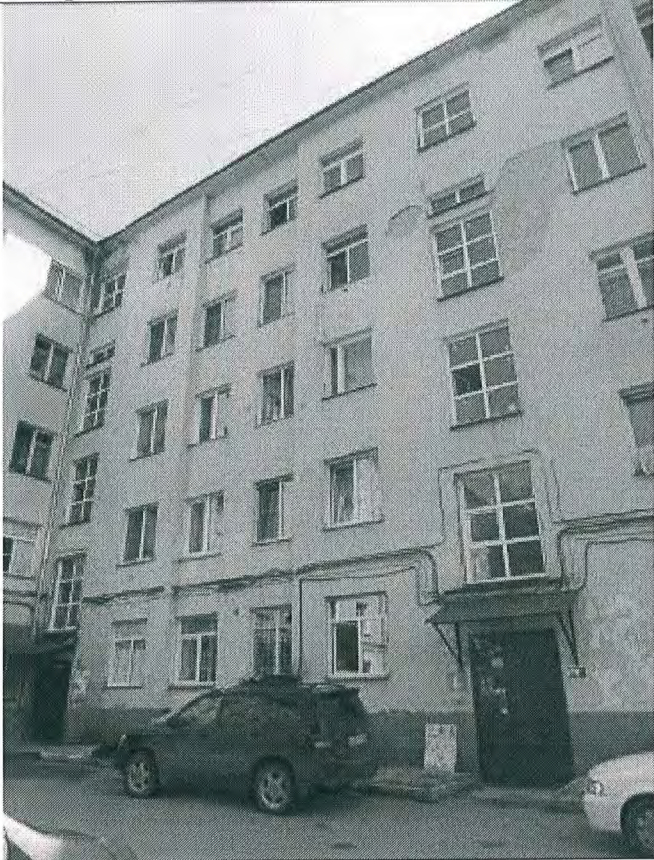
5. Фрагмент дворового фасада (южный объем)
