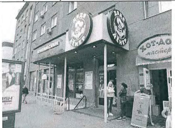
32. Прямо́к спуска в подвал (главный фасад)
