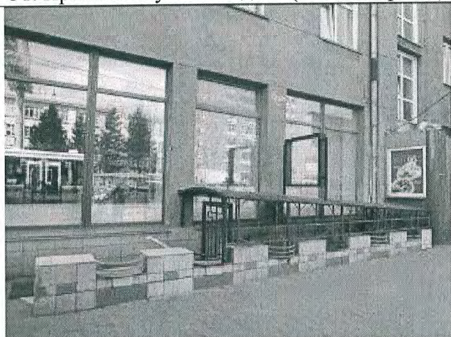
31. Прямо́к спуска в подвал (главный фасад)
