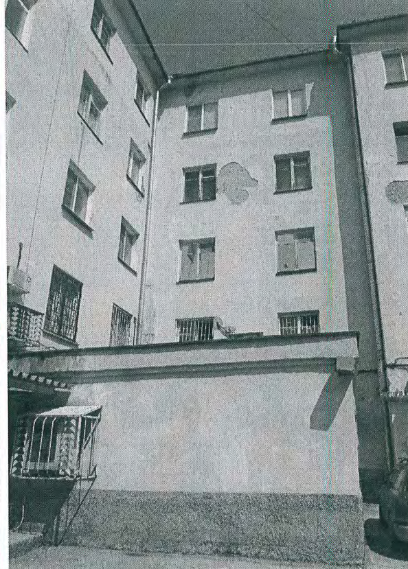
12. Северо-восточный дворовый угол
