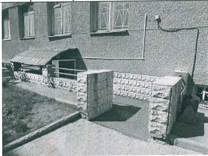
29. Прямо́к спуска в подвал (южный фасад)
