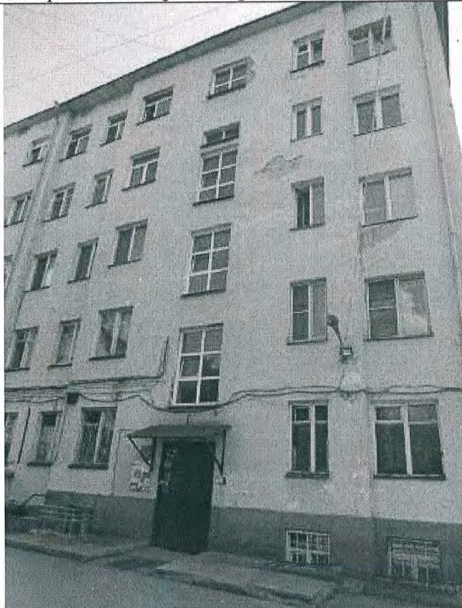
7. Фрагмент дворового фасада (южный объем)
