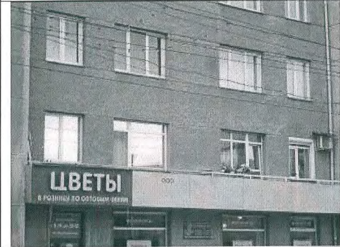
47. Балкон на главном фасаде
