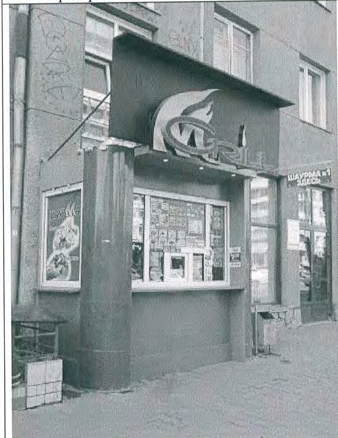
15. Пристроенный киоск на главном фасаде
