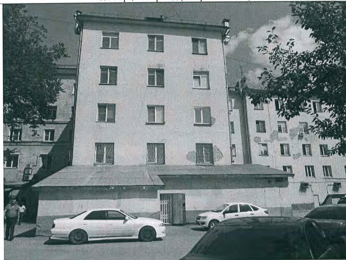
13. Торцевой фасад (северный объем)
