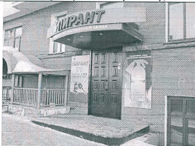
13. Входной узел на главном фасаде (в центральную лестничную клетку)
