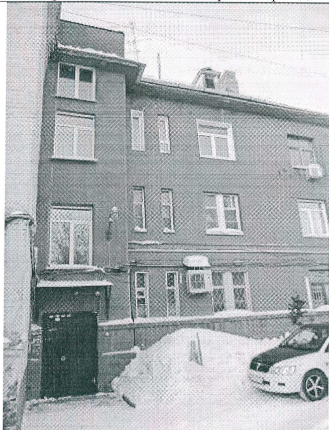
6. Фрагмент восточного дворового фасада
