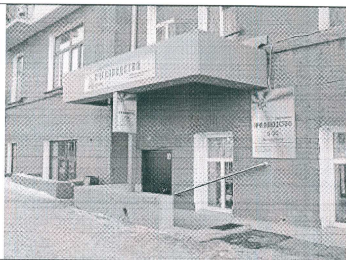
14. Прямо́к спуска в подвал на главном фасаде
