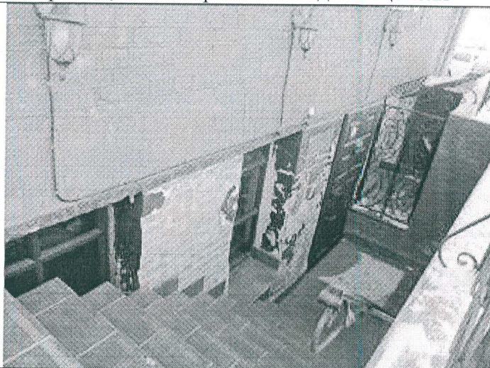
12. Прямо́к спуска в подвал на северном фасаде, демонтированная отделка цоколя
