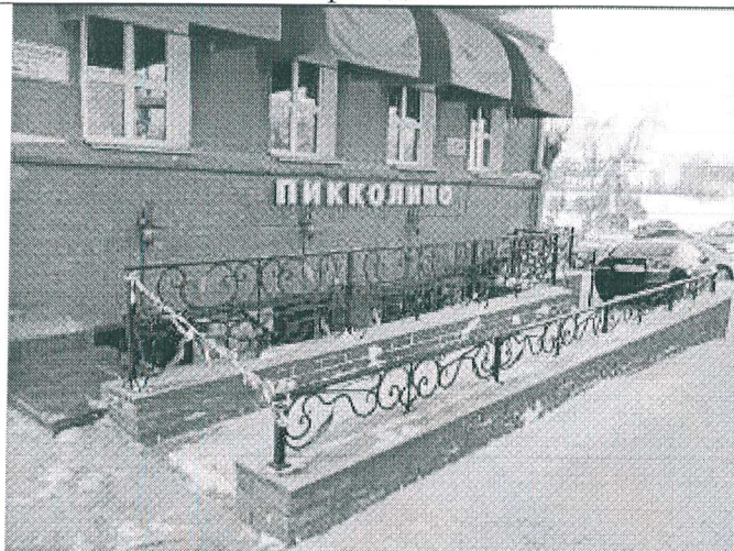
11. Прямо́к спуска в подвал на северном фасаде
