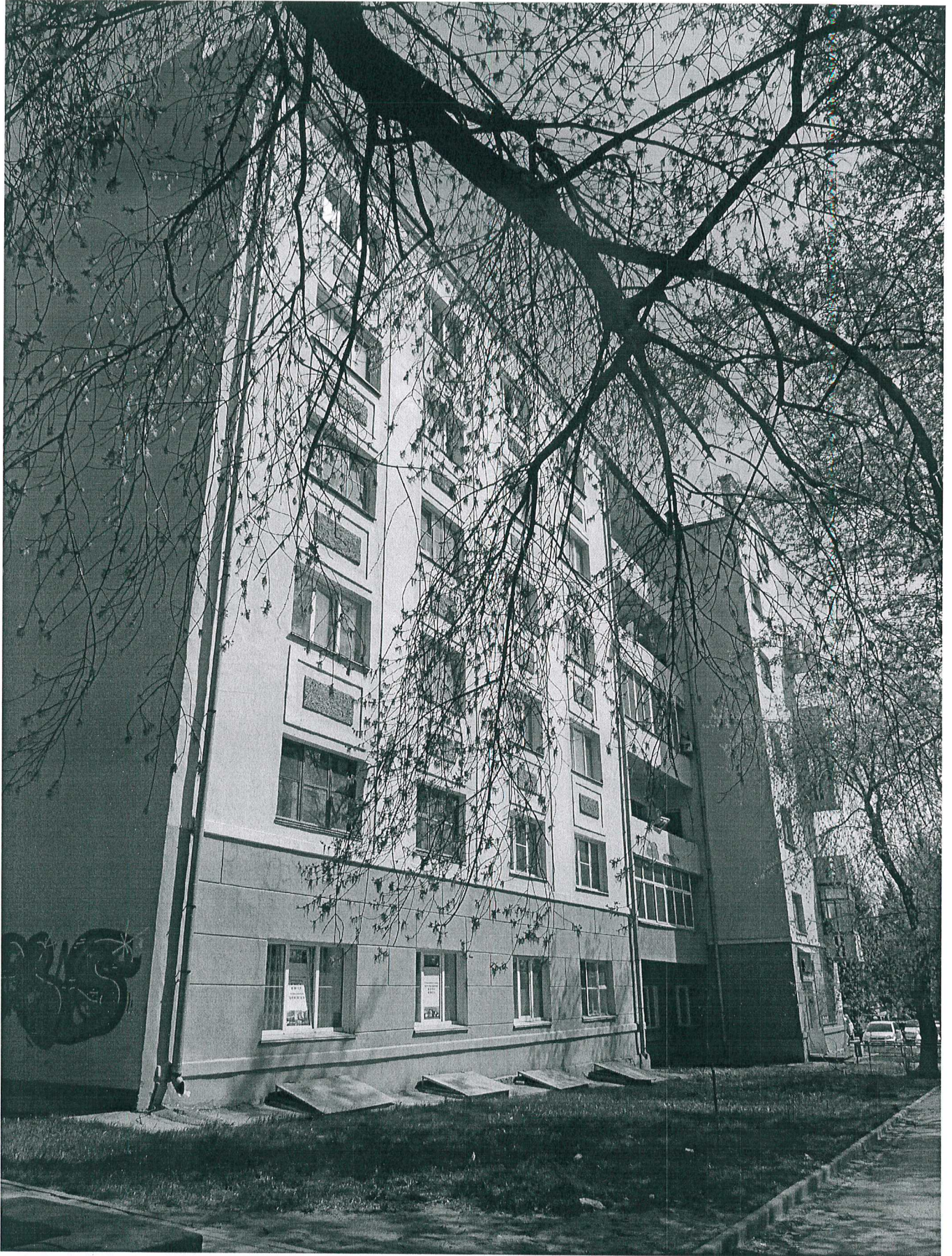
5.3. Вид западного фасада со стороны ул. Каменская.
