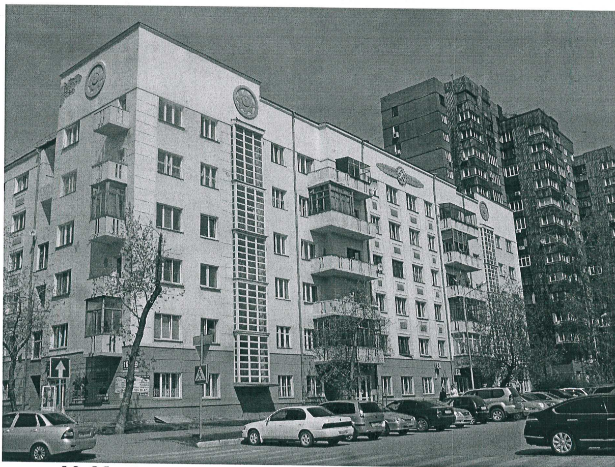
5.2. Общий вид южного (главного) фасада со стороны ул. Октябрьская.
