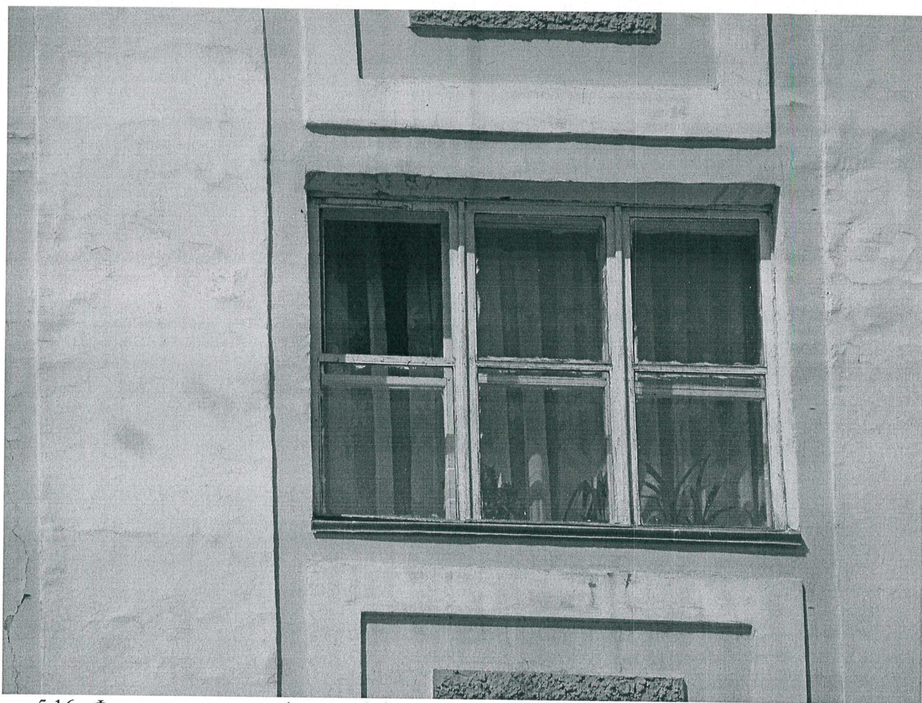
5.16. Фрагмент главного (южного) фасада. Предмет охраны - первоначальное окно.
