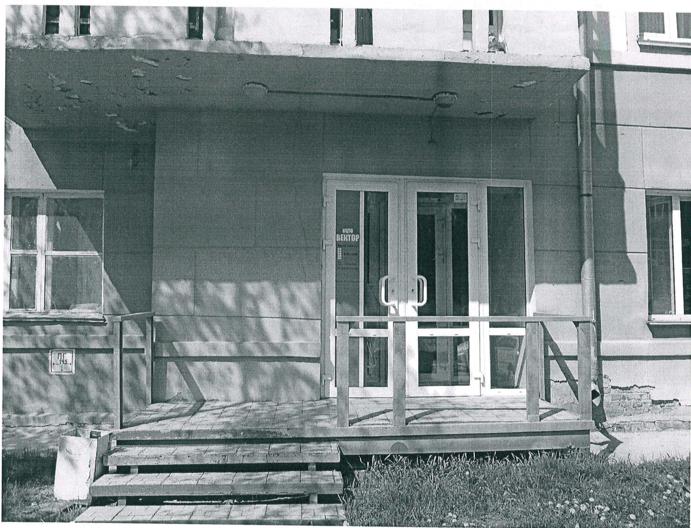
5.11. Фрагмент главного (южного) фасада. Вход в нежилые помещения.
