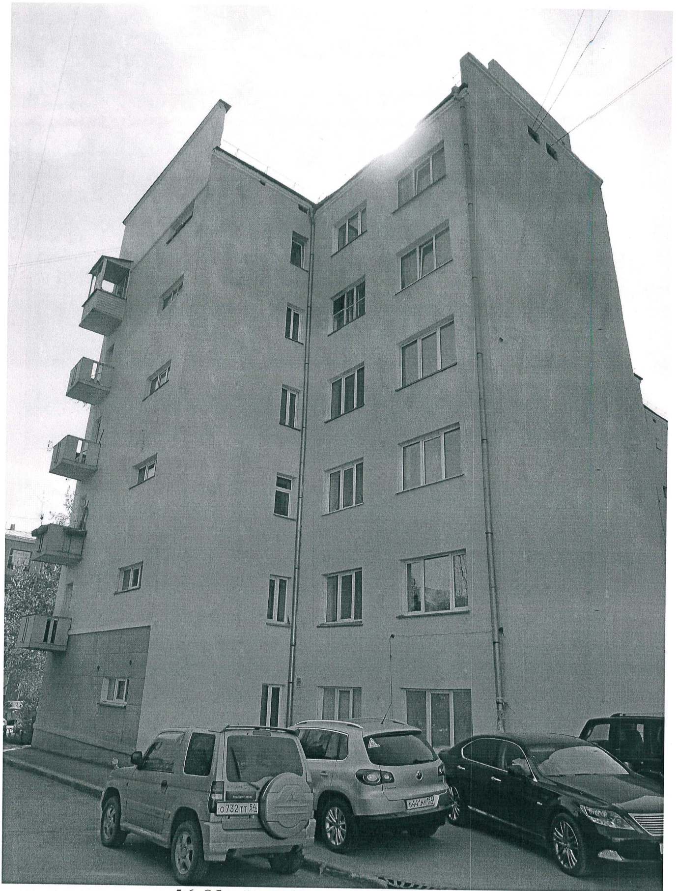
5.6. Общий вид бокового (восточного) фасада.
