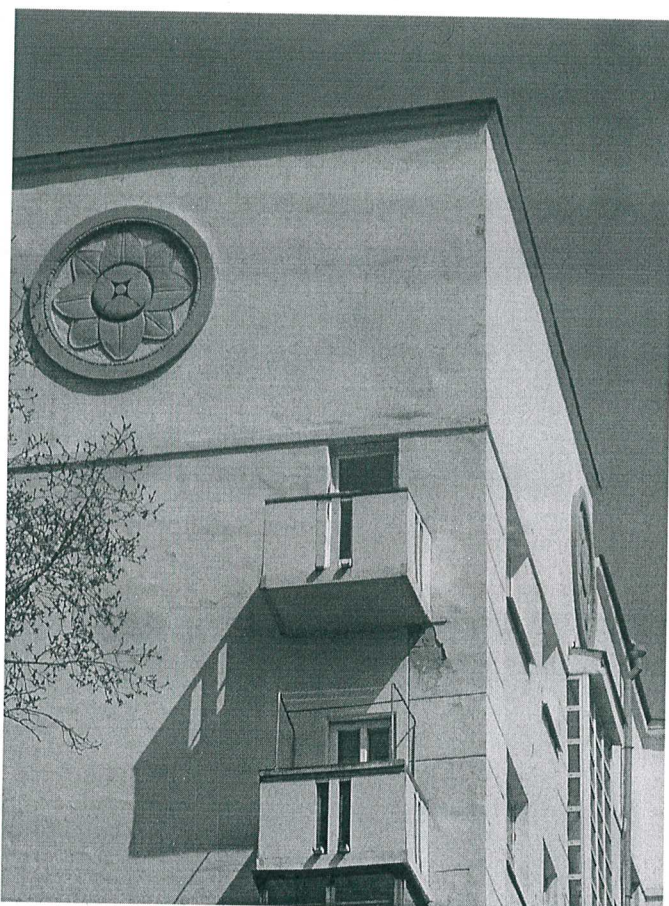
5.17. Фрагмент главного (западного) фасада. Предметы охраны – ограждения балконов.
