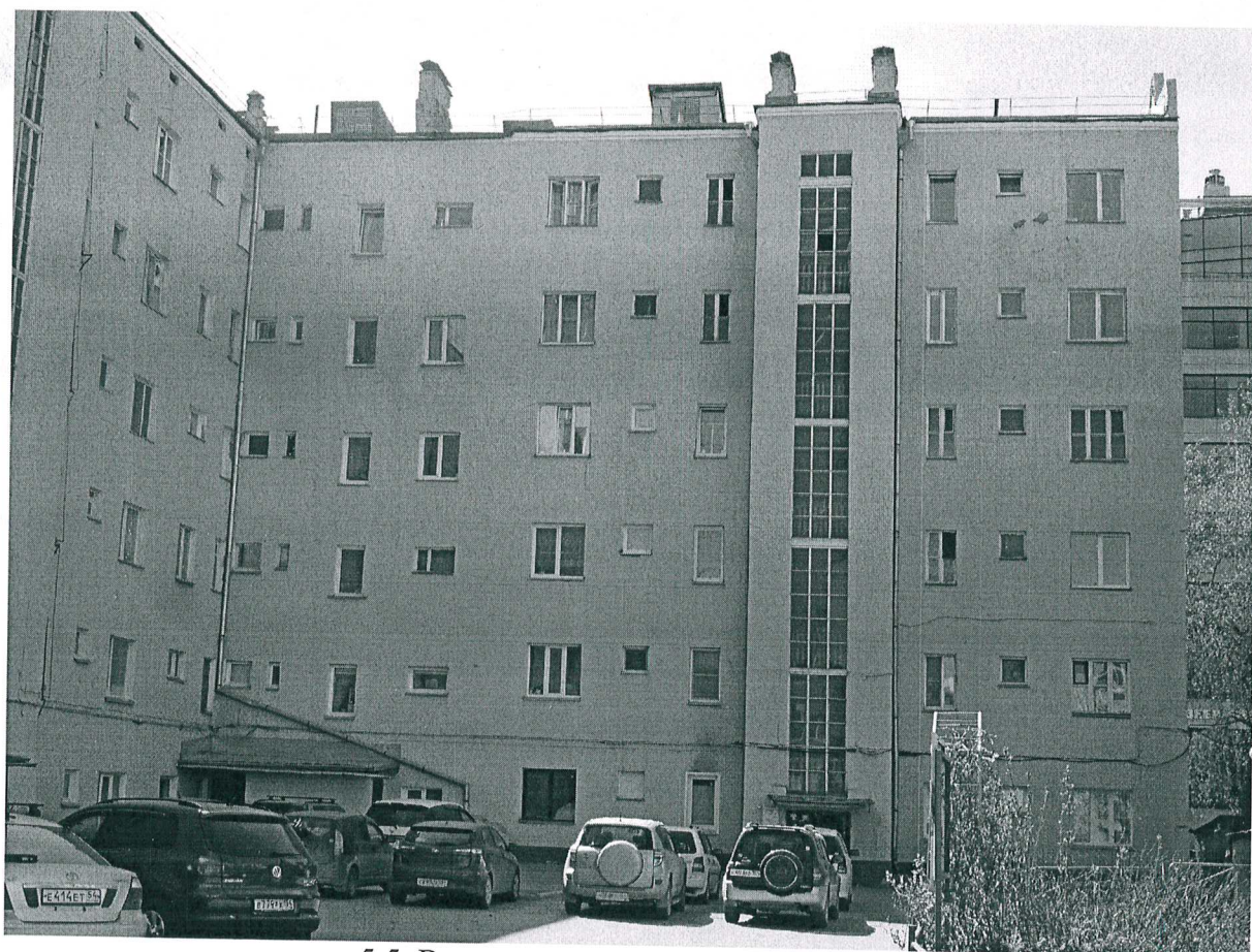
5.5. Вид восточного дворового фасада
