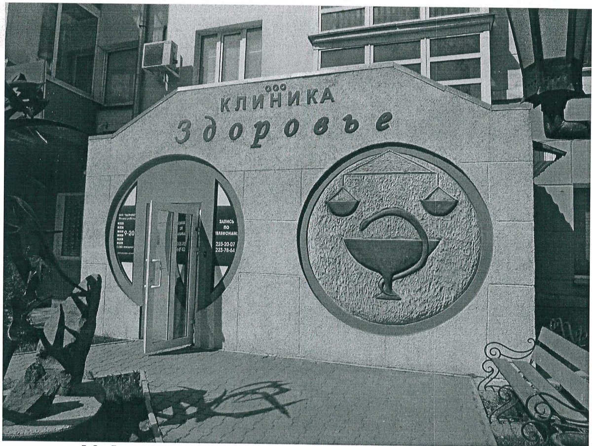
5.8. Фрагмент главного (южного) фасада. Вход в нежилые помещения по месту парадного входа в подъезд № 1.
