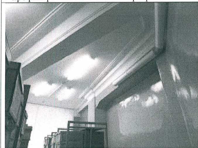
5.15. Кессонированные потолки и потолочные профилированные тяги в интерьерах 1 этажа
