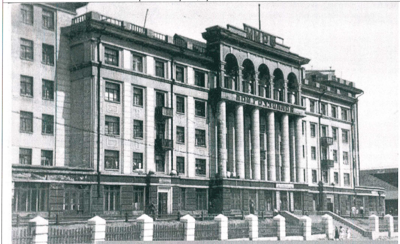
5.42. Историческое фото, предположительно, 50-е гг
