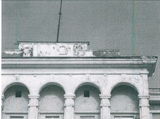
5.19. Центральный аттик и колоннада
