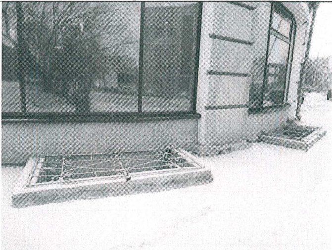
5.23. Световые приямки на главном фасаде
