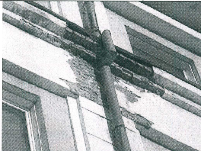
5.33. Фрагмент главного фасада
