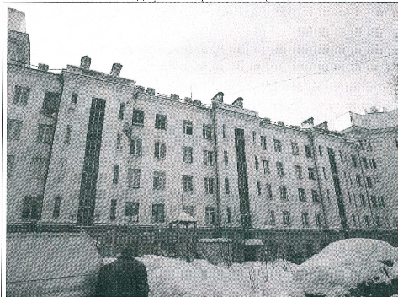
5.2. Дворовый северо-восточный фасад
