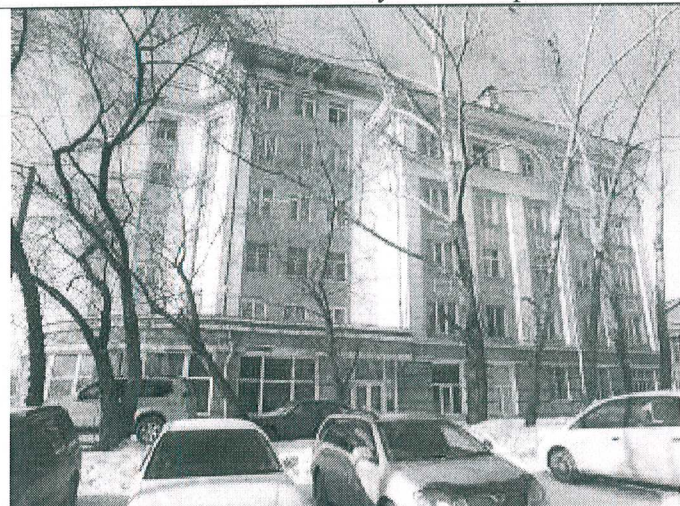
5.3. Юго-восточный уличный фасад
