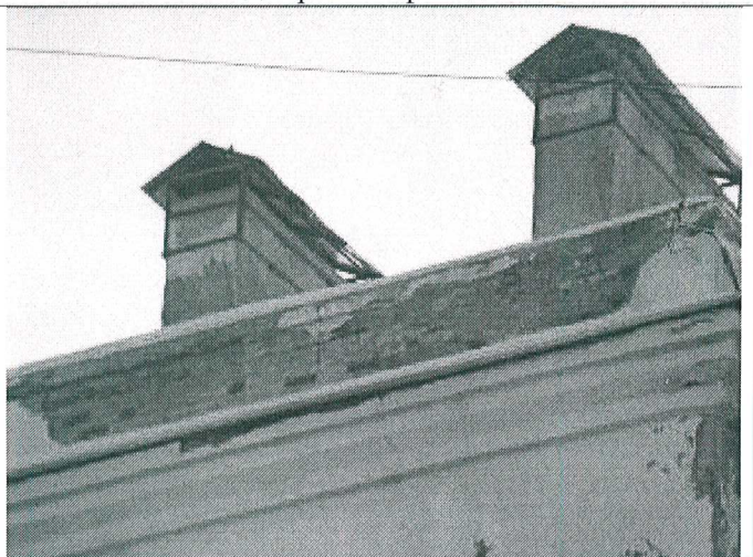
5.8. Вентиляционные шахты и парапет на дворовом фасаде
