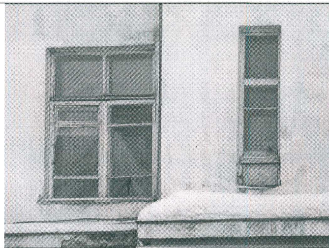
5.16. Первоначальные окна на дворовом фасаде
