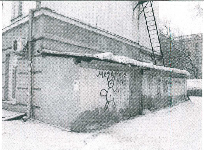
5.21. Пристрой на торцевом фасаде
