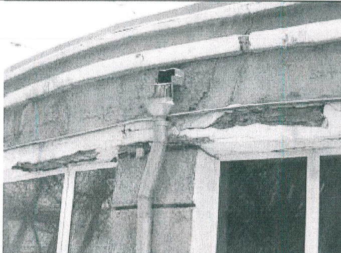
5.29. Фрагмент главного фасада, 1 этаж
