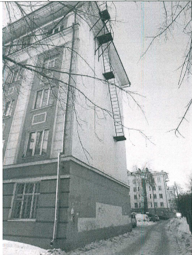
5.35. Пожарная лестница на торцевых фасадах
