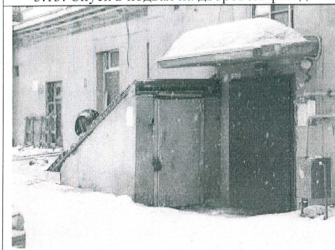
5.13. Спуск в подвал на дворовом фасаде
