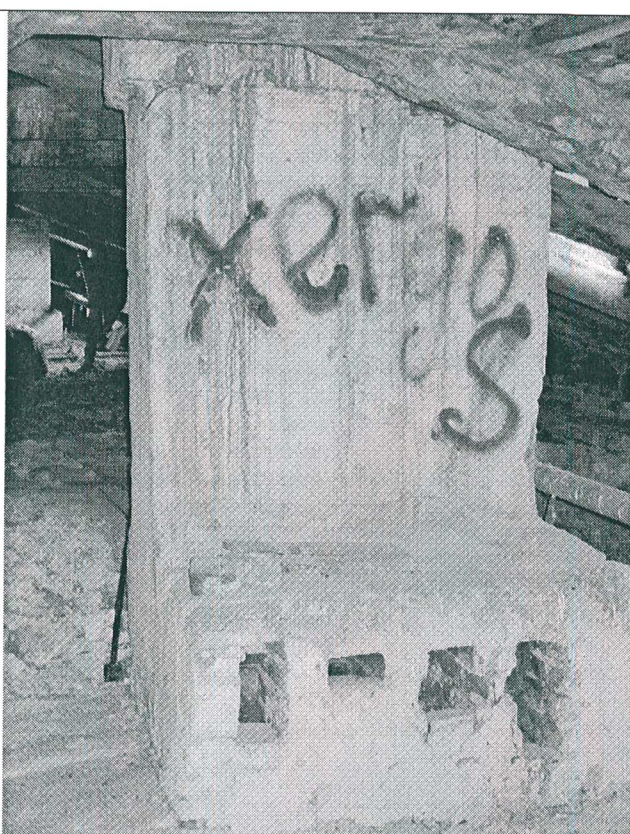
17. Одна из сохранившихся вентиляционных шахт в помещении чердака.
