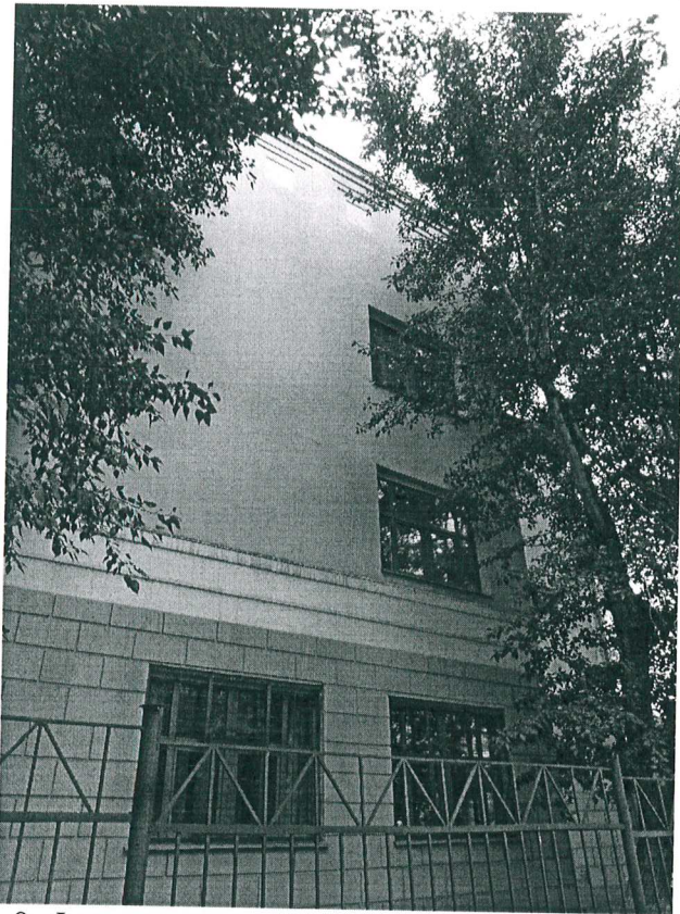
9. Фрагмент северного фасада (восточный объем). Предмет охраны – декор фасада.
