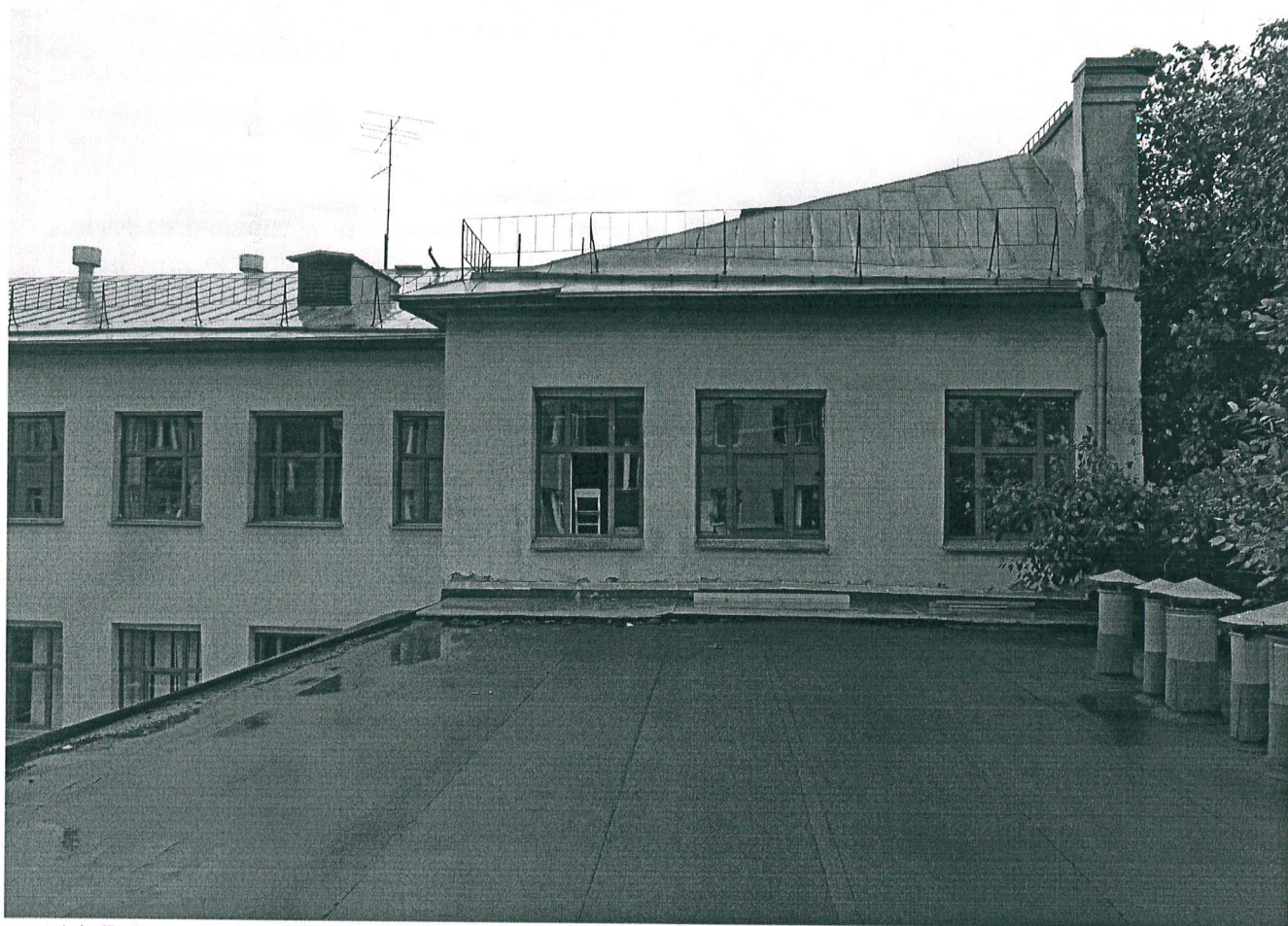
14. Восточный (торцевой) фасад трехэтажного исторического объема. Вид с кровли.
