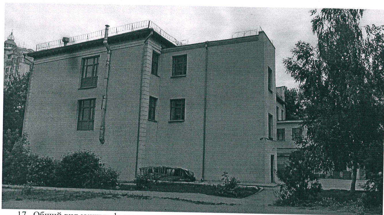
17. Общий вид южных фасадов.
