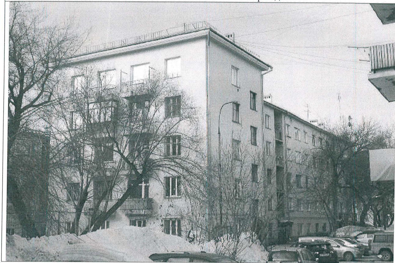
5.1. Вид на южный и восточный фасады
