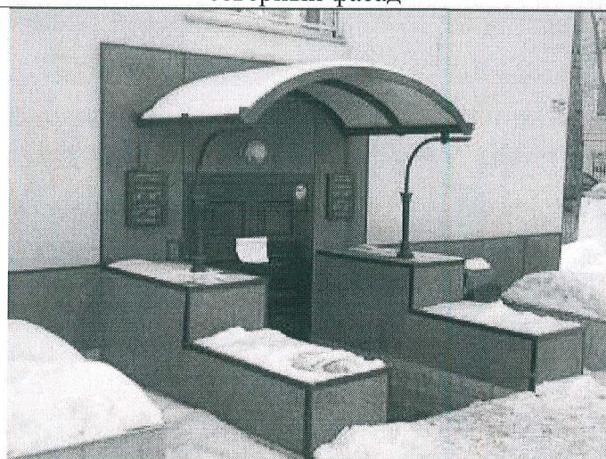
5.7. Входной узел в нежилые помещения, северный фасад
