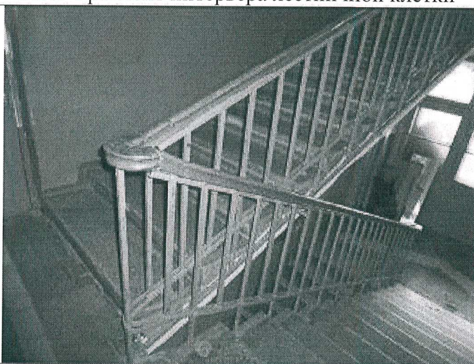
5.21. Фрагмент интерьера лестничной клетки
