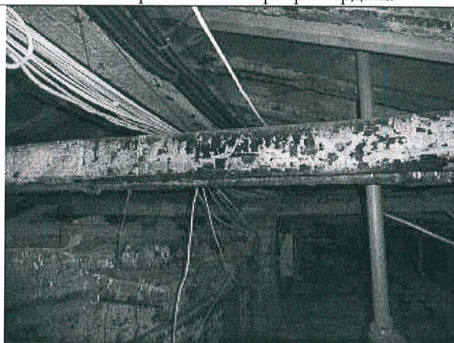
5.15. Фрагмент интерьера чердака
