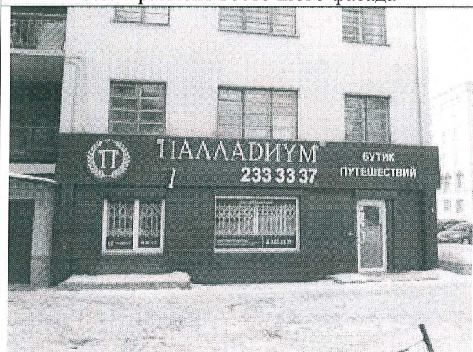
5.8. Фрагмент восточного фасада
