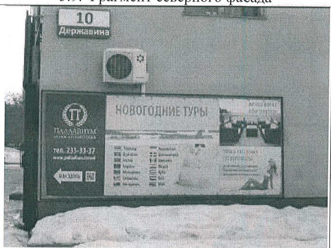
5.9. Фрагмент северного фасада
