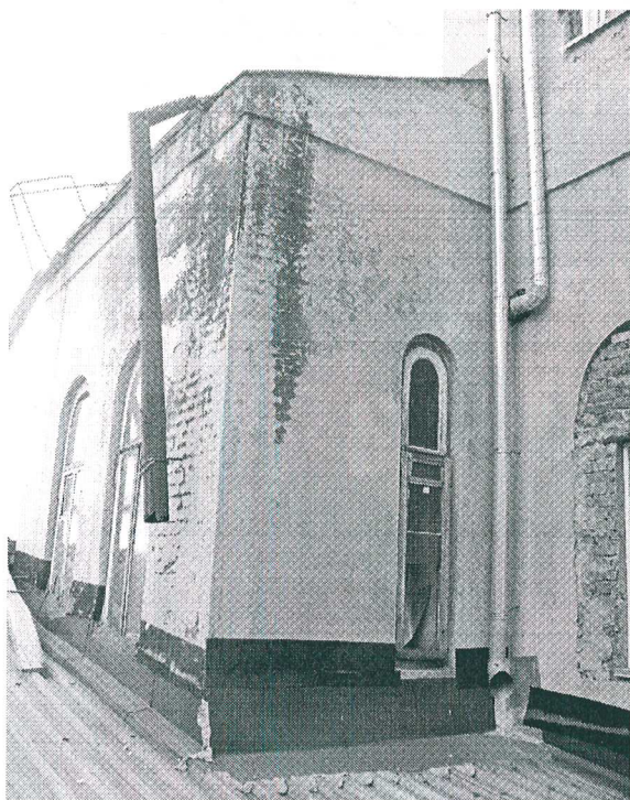
8. Фрагмент внутреннего (северо-западного) угла в уровне 2-го этажа.
