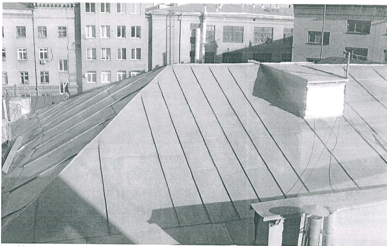
33. Фото 2009 года: вид крыши с западной стороны.
