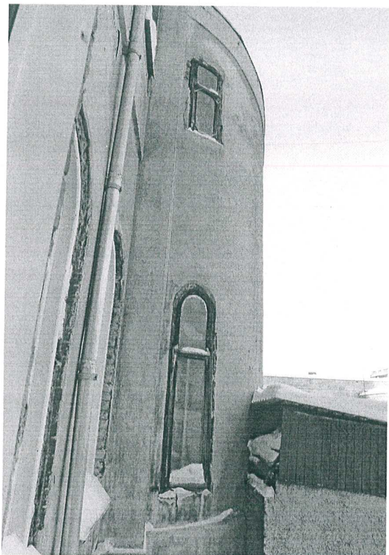
24. Примыкание северного лестничного объема на восточном фасаде (верх).
