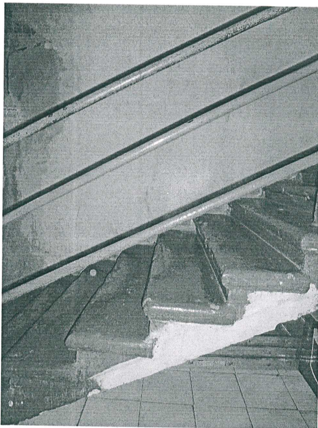
49. Ограждение северной лестницы.
