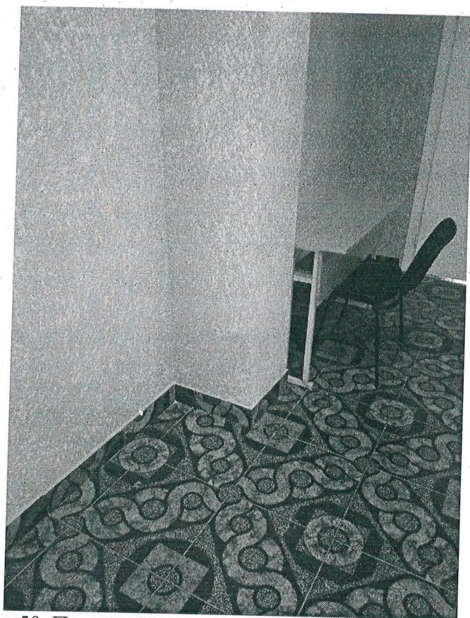
50. Предмет охраны: колонна в интерьере 2 этажа (нижний фрагмент).
