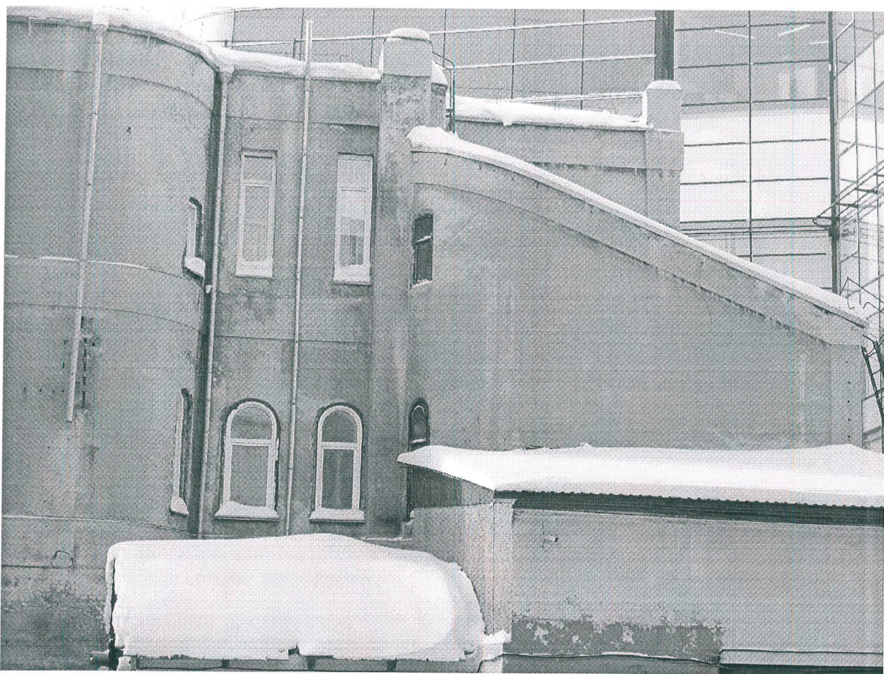
22. Фрагмент восточного фасада в уровне 2 и 3 этажей.
