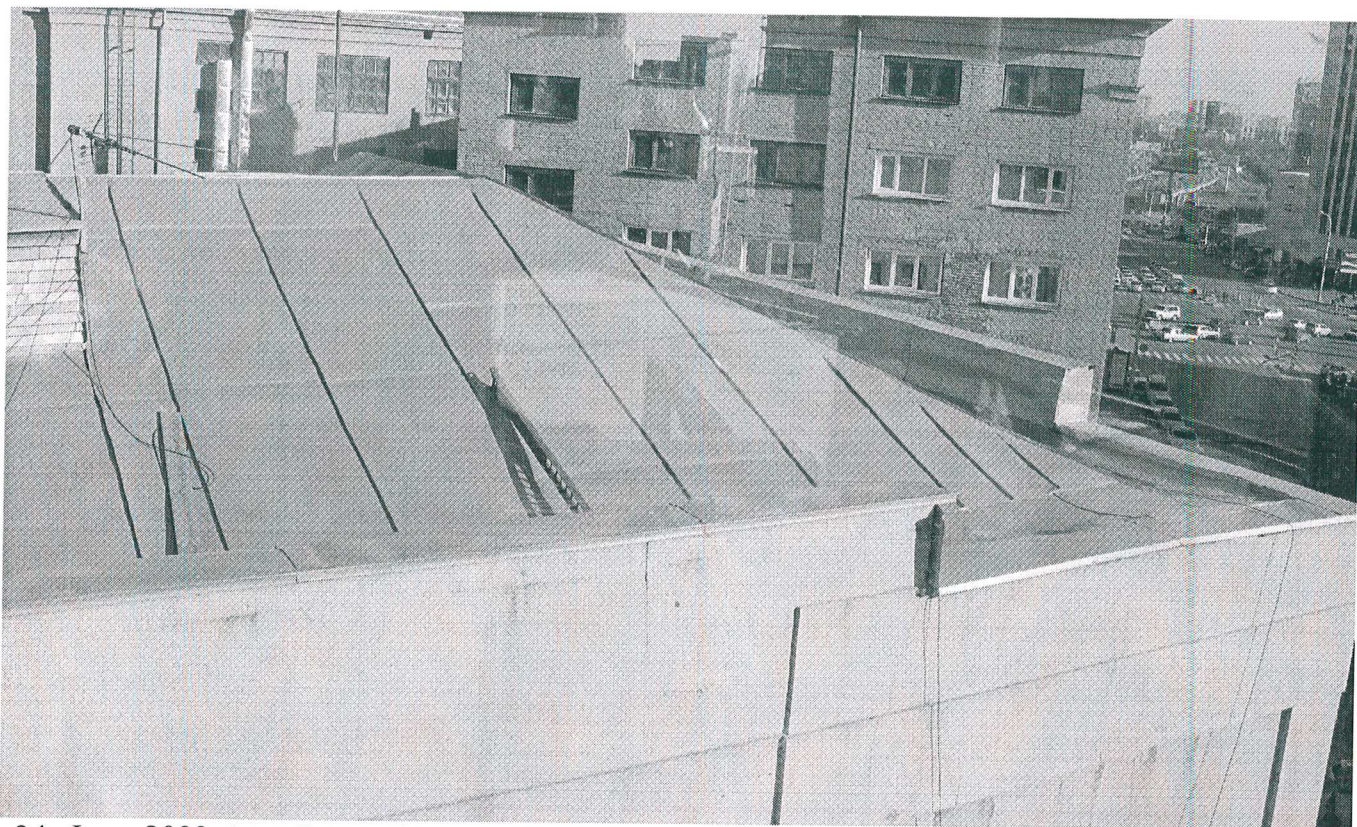
34. Фото 2009 года. Фрагмент западного ската крыши.
