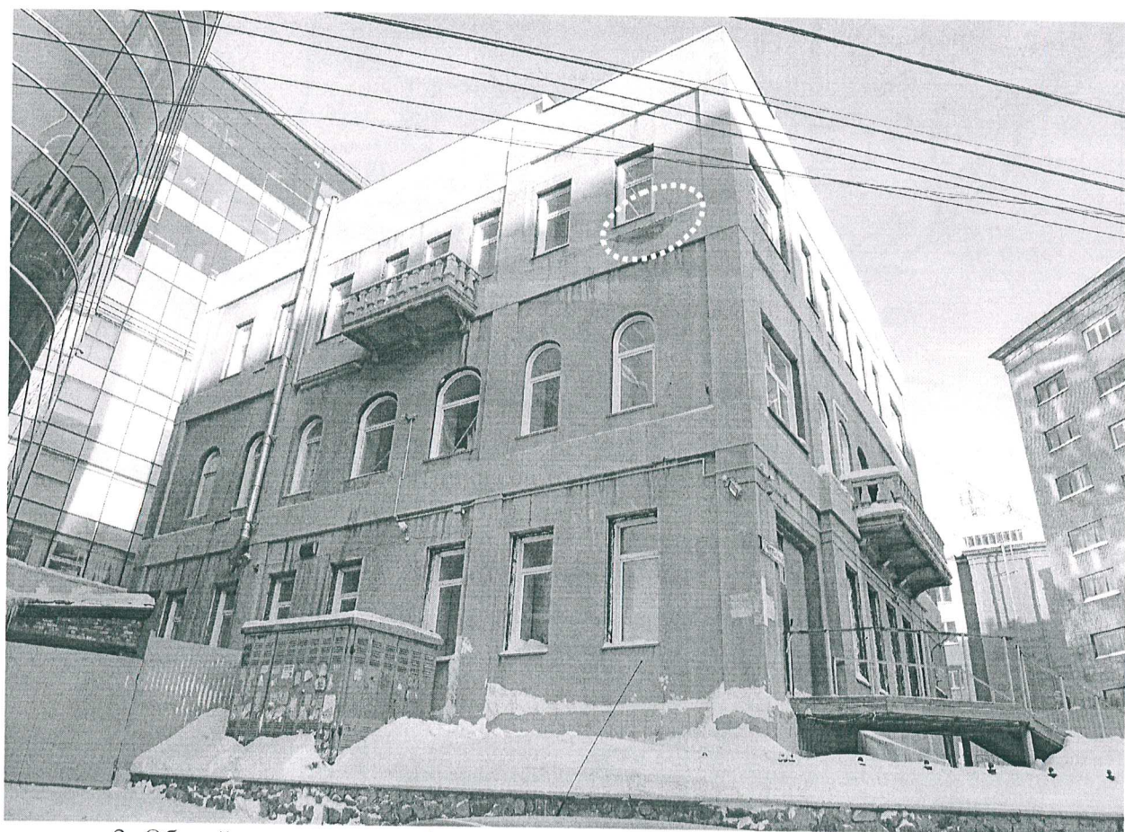
2. Общий вид западного фасада
