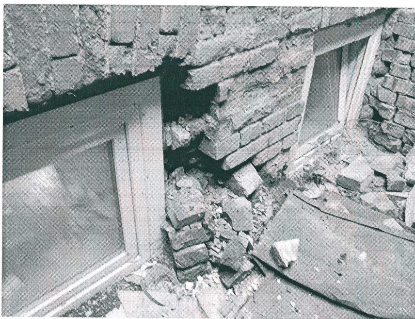
31. Фрагмент восточной стены светового приямка.
