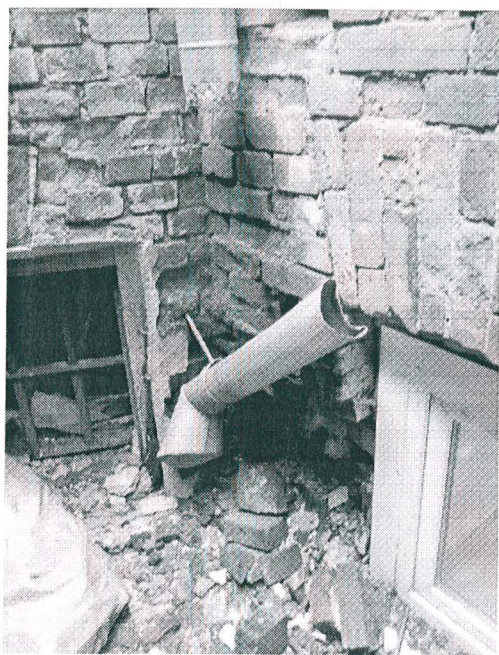
30. Отвод осадков в приямок.
