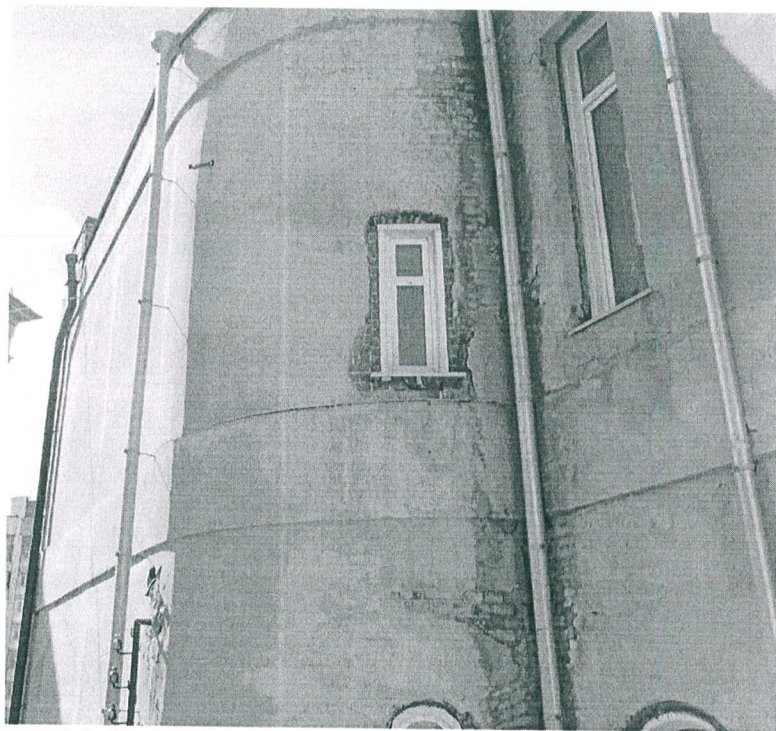
26. Примыкание южного лестничного объема на восточном фасаде (верх).
