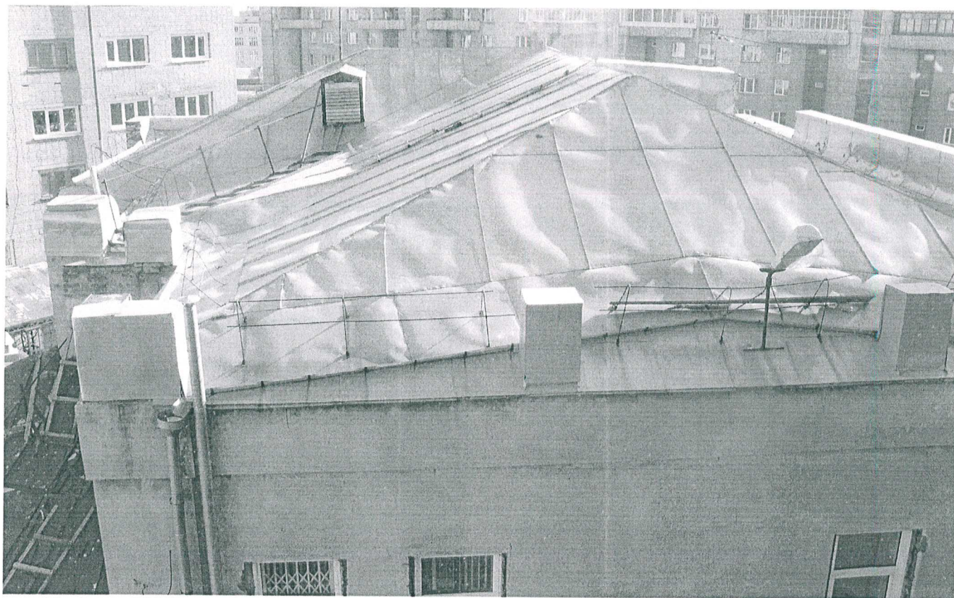
32. Фото 2009 года: вид крыши с северной стороны.
