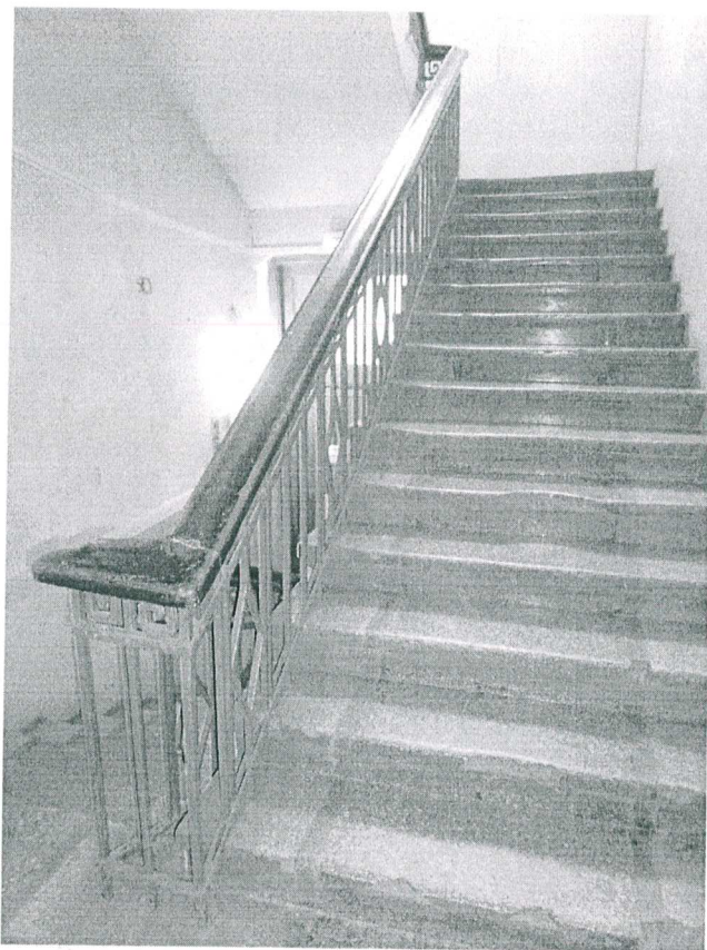
46. Предмет охраны: лестница южной лестничной клетки.
