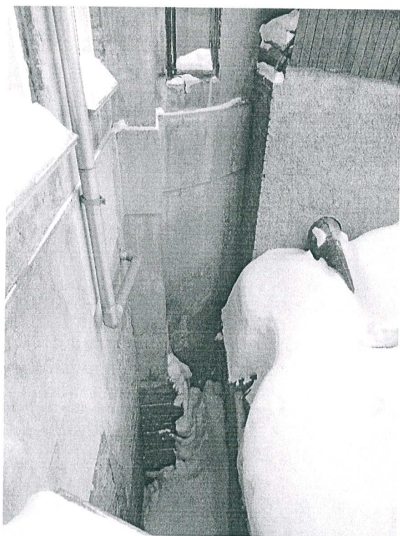
25. Примыкание северного лестничного объема на восточном фасаде (низ).
