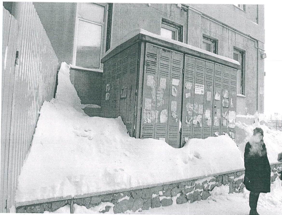
10. Фрагмент западного фасада.
