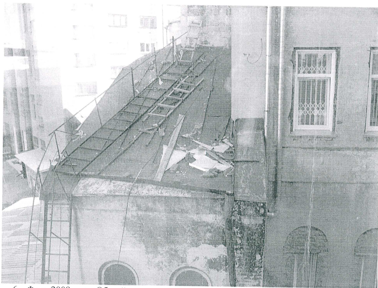
6. Фото 2009 года. Общий вид покрытия северного лестничного объема.
