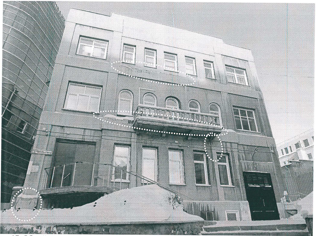
17. Общий вид главного (южного) фасада. Дефекты кладки и отделки.
