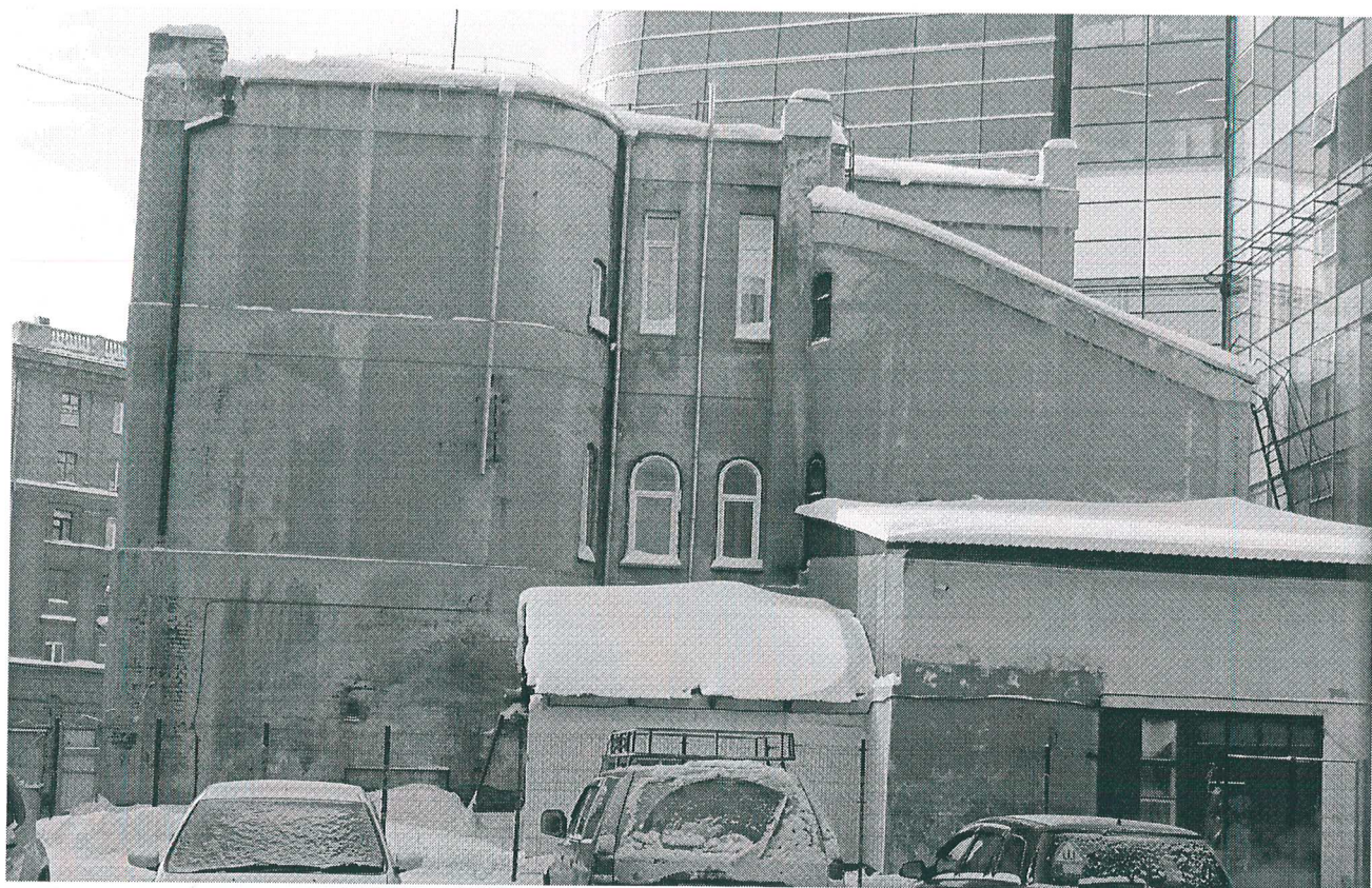
3. Общий вид восточного фасада
