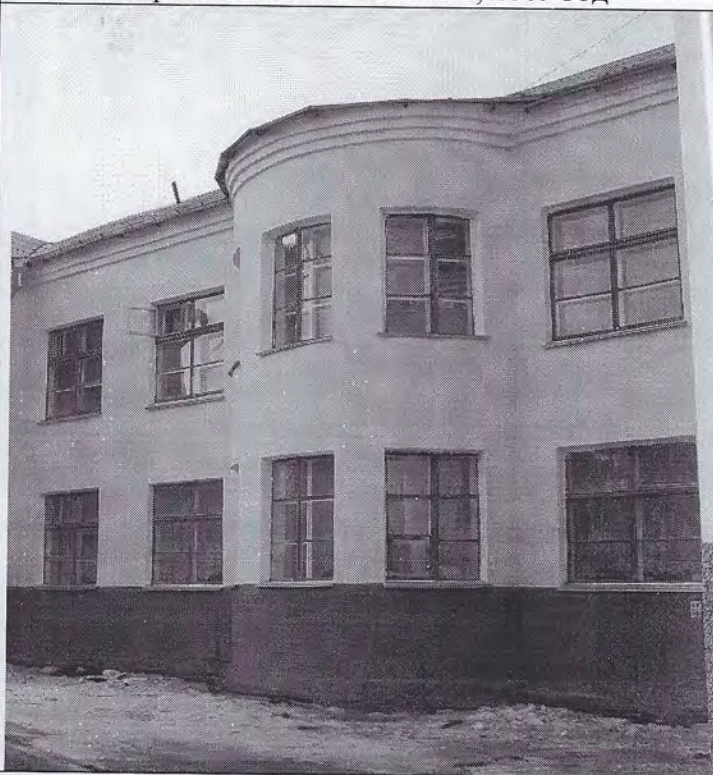
56. Фрагмент северо-восточного фасада с первоначальными окнами, 2009 год
