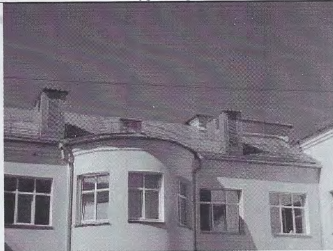
41. Фрагмент крыши со стороны северного курдонера
