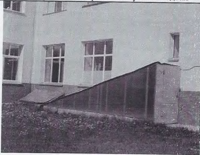
26. Современный приямок спуска в подвал
