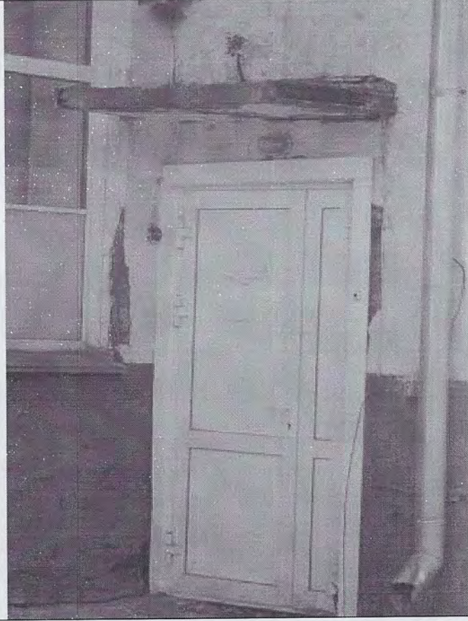
21. Входной узел в южную лестничную клетку
