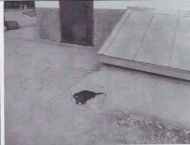
33. Провал в отмостке
