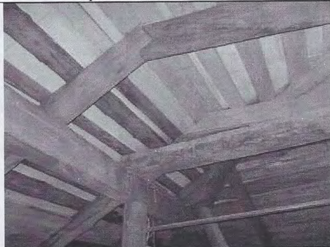
43. Фрагмент помещения чердака
