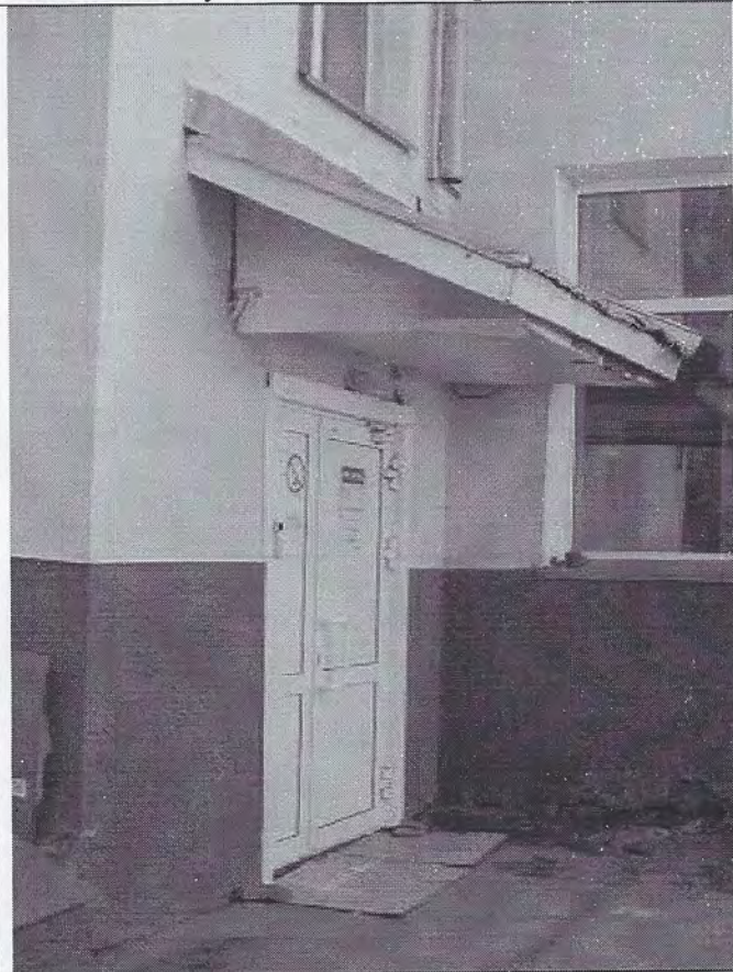
20. Входной узел в южный операционный блок
