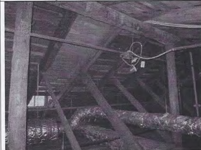
42. Фрагмент помещения чердака
