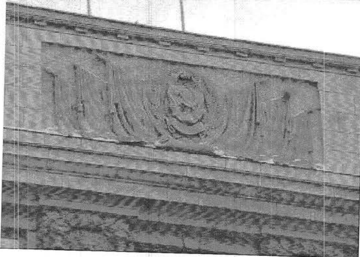
9. Барельеф на аттике главного фасада
