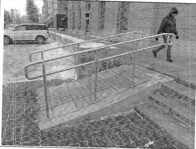
11. Пандус и подпорная стенка с северной стороны
