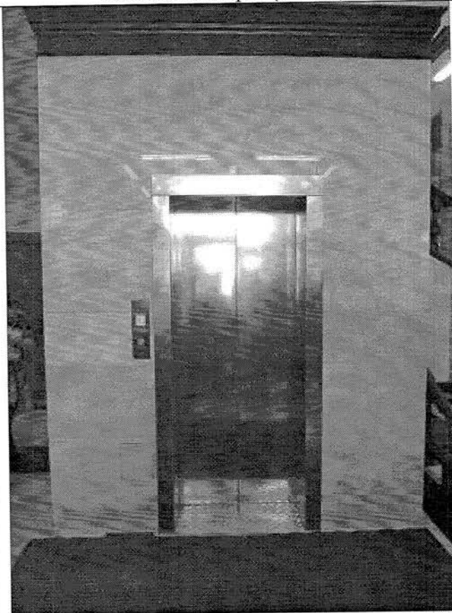
58. Шахта лифта (1 этаж)
