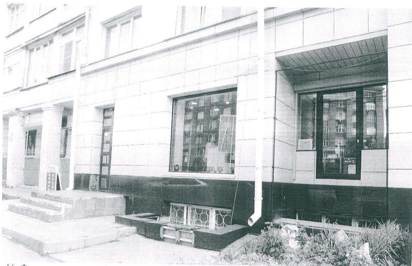
16. Фрагмент главного (северо- западного) фасада.
