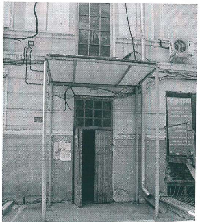
42. Вход на дворовом фасаде
