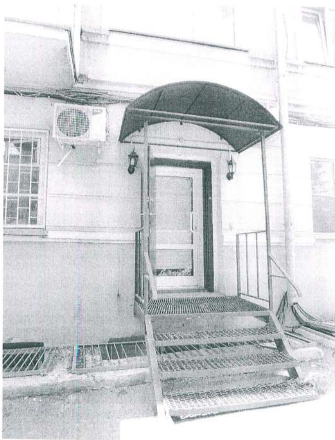
37. Вход на дворовом фасаде.
