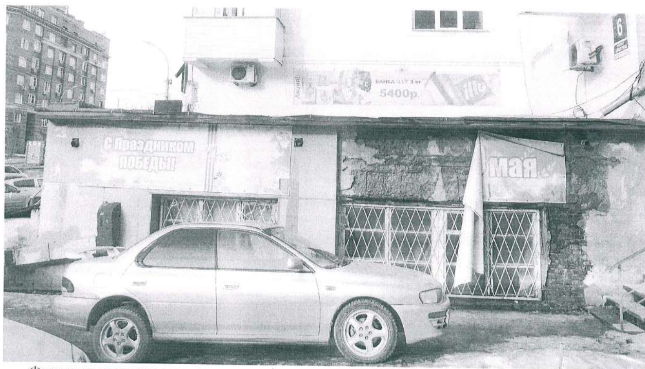
Фрагмент главного юго- западного фасада.
