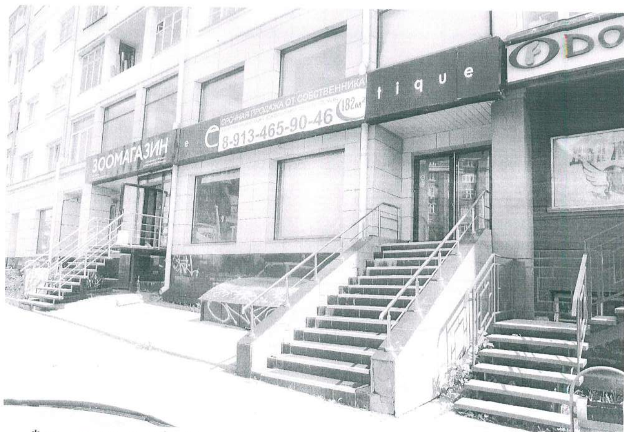
Фрагмент главного (северо-западного) фасада.
