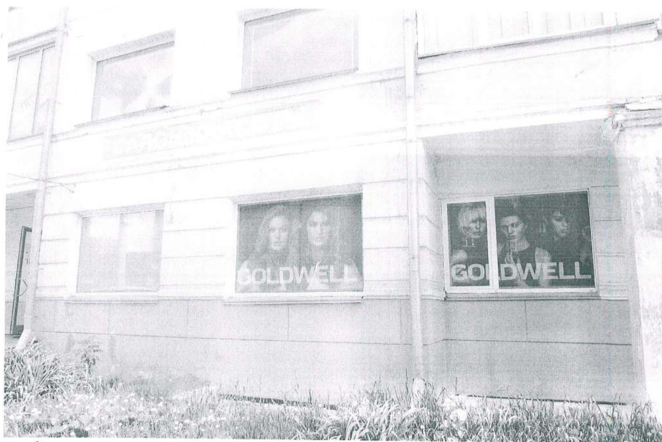
Фрагмент главного (северо-западного) фасада.
