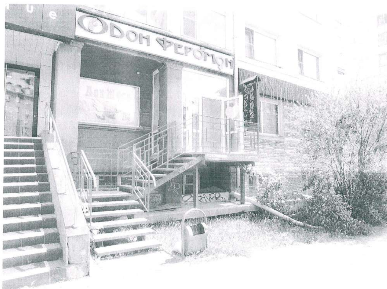
Фрагмент главного (северо-западного) фасада.
