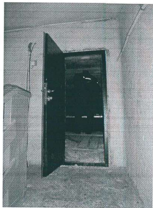
55. Вход на чердак.
