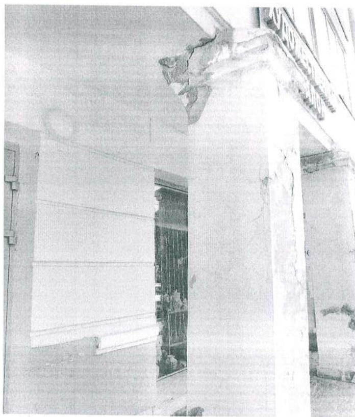
12. Верхний фрагмент колонны.
