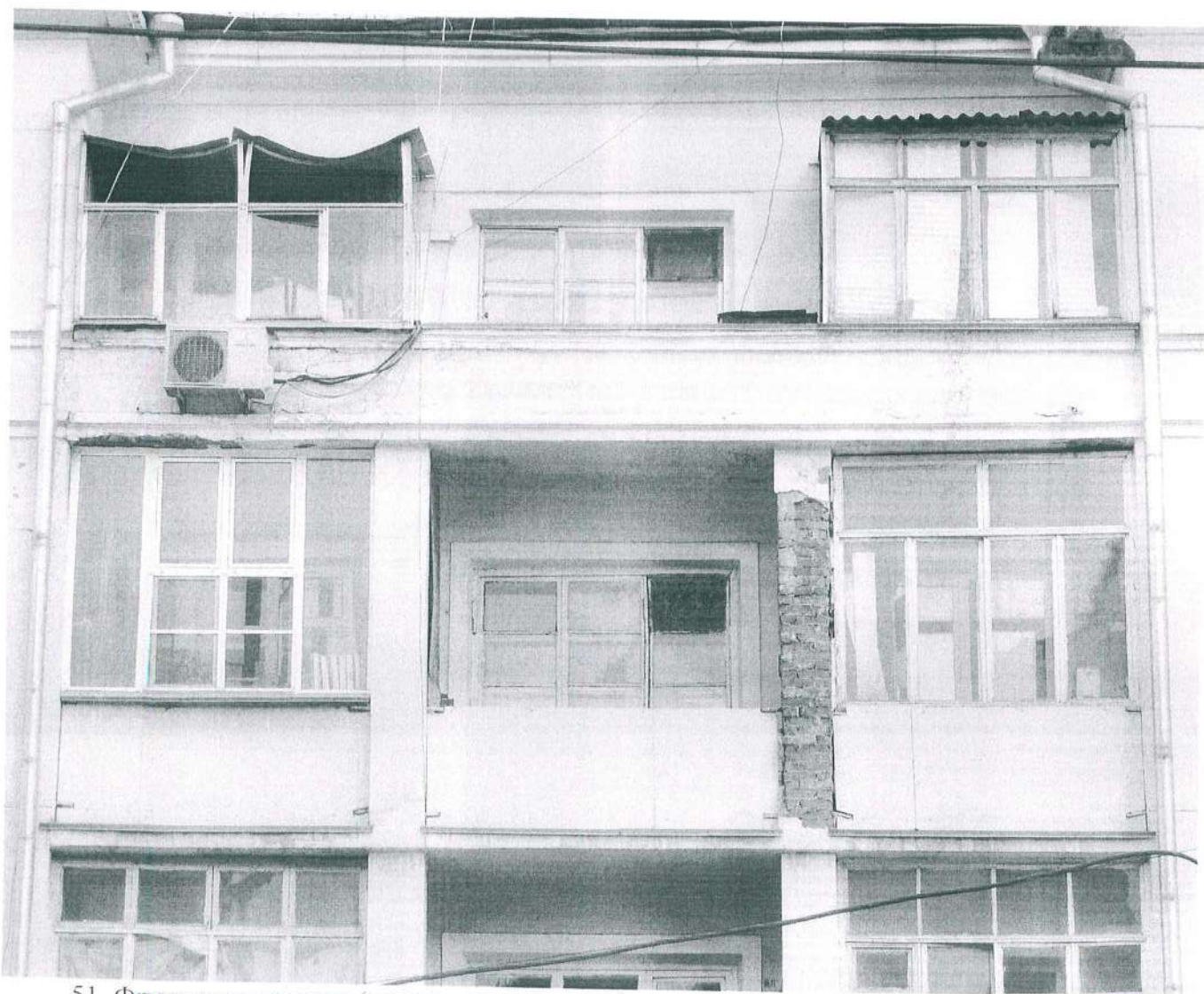
51. Фрагмент главного (северо-западного) фасада в уровне верхних этажей.
