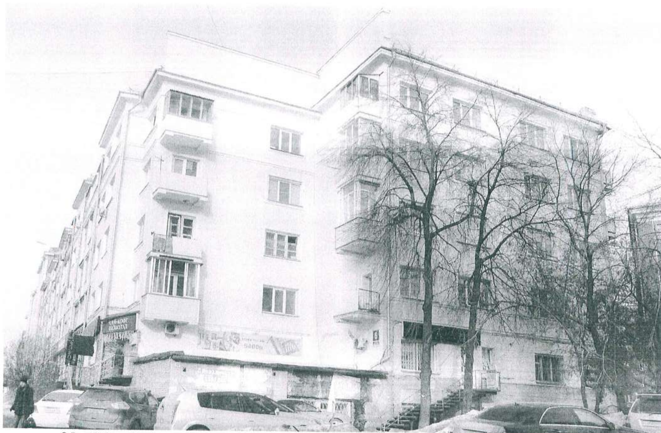
25. Общий вид главного (юго-западного) фасада.
