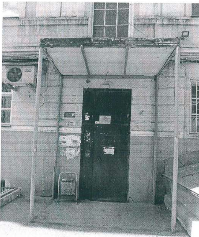
41. Вход на дворовом фасаде
