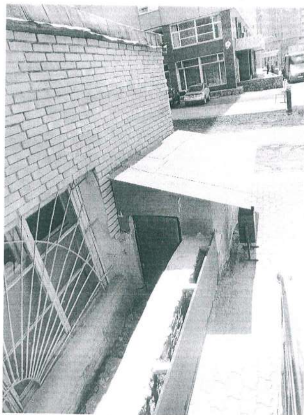
22. Фрагмент (северо- западного) фасада.
