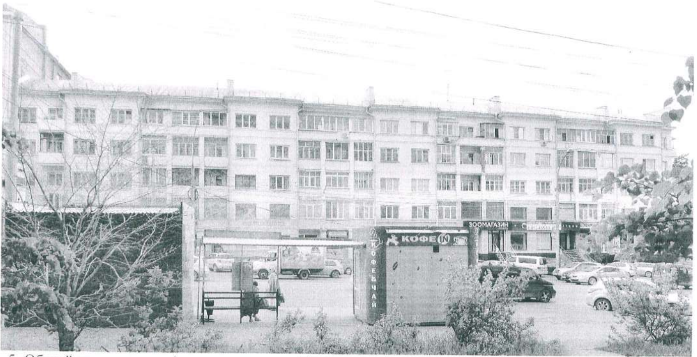
5. Общий вид главного (северо-западного) фасада.
