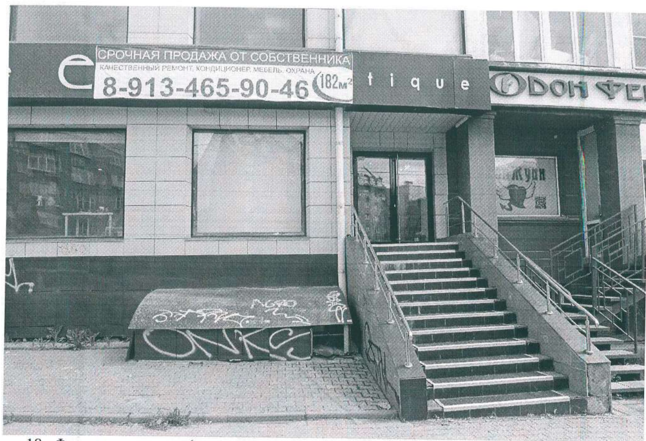
18. Фрагмент главного (северо- западного) фасада.
