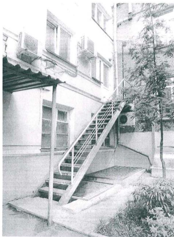
36. Вход на дворовом фасаде.
