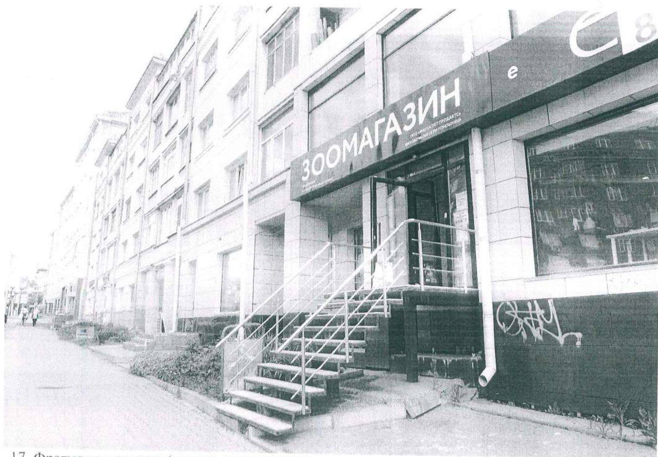
17. Фрагмент главного (северо- западного) фасада.
