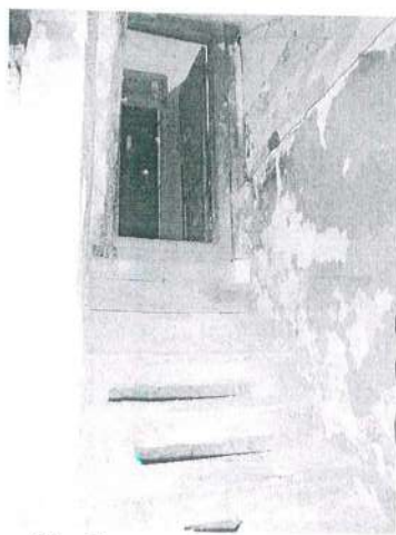
60. Лестница в подвале.
