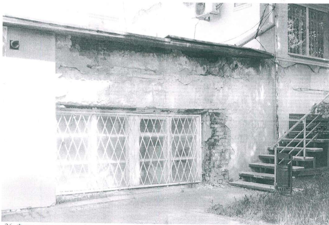
26. Фрагмент главного (юго-западного) фасада.
