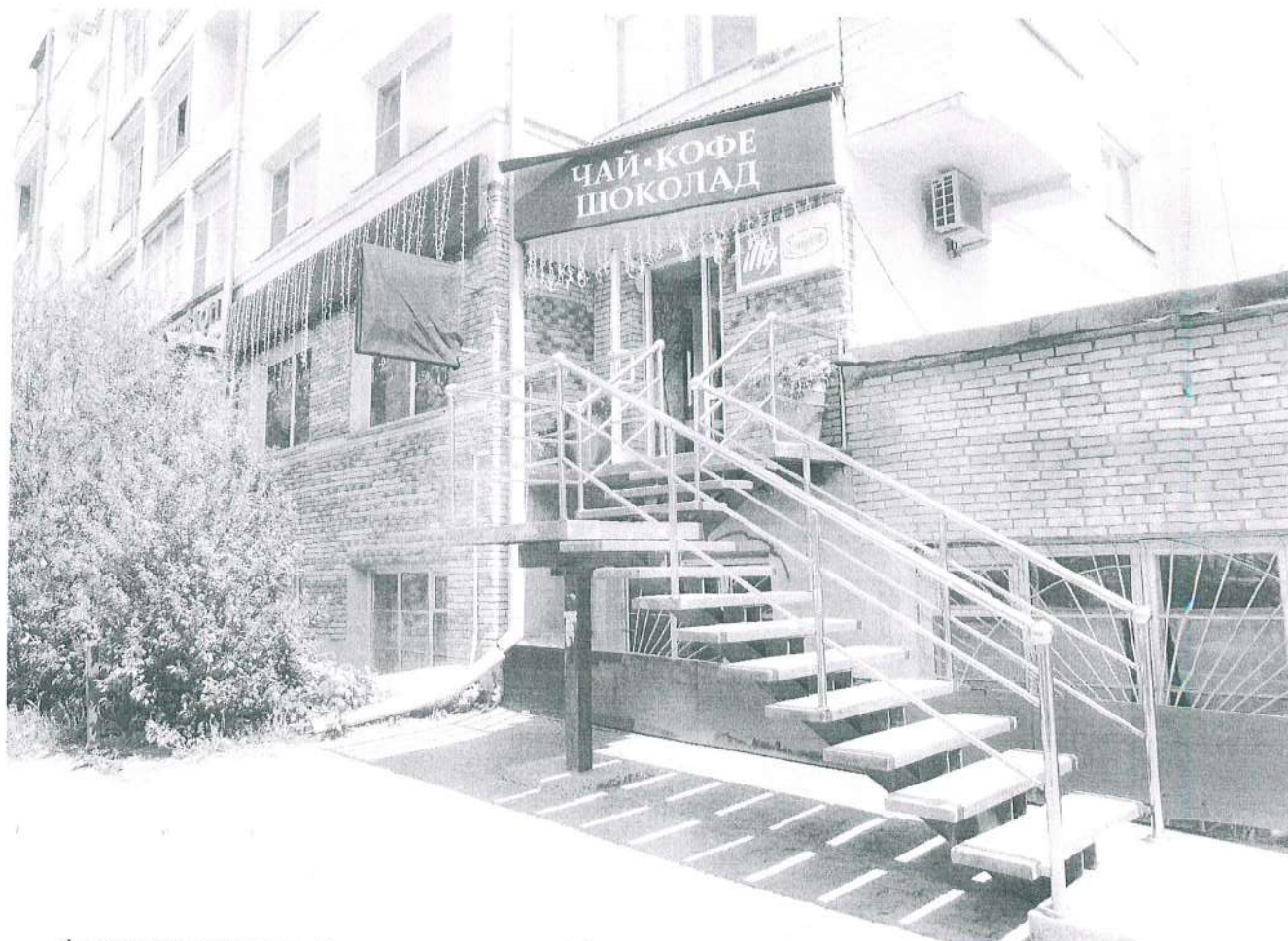
Фрагмент главного (северо-западного) фасада.
