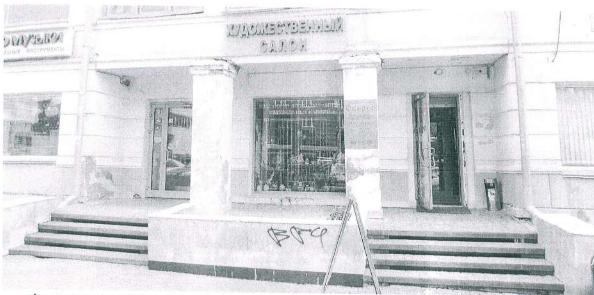
Фрагмент главного (северо-западного) фасада.
