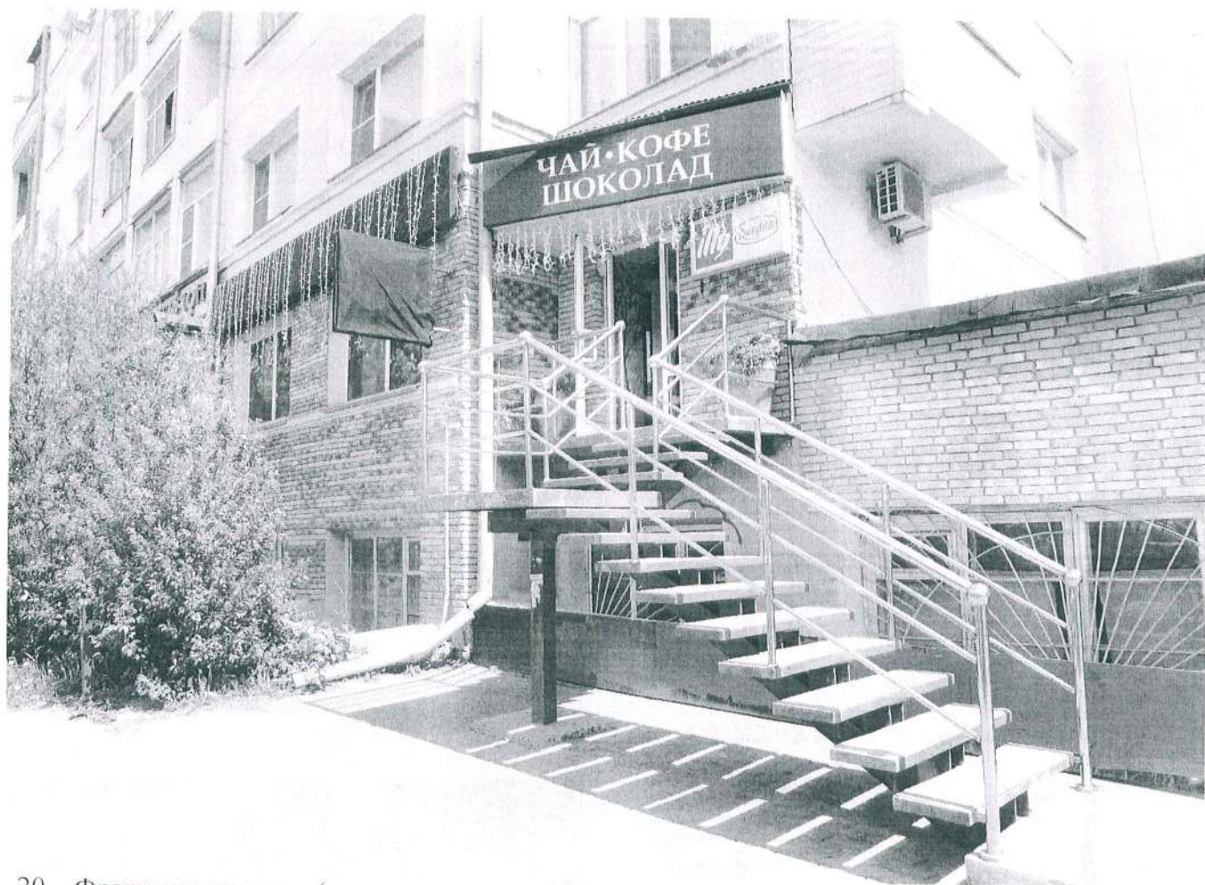
20. Фрагмент главного (северо- западного) фасада.
