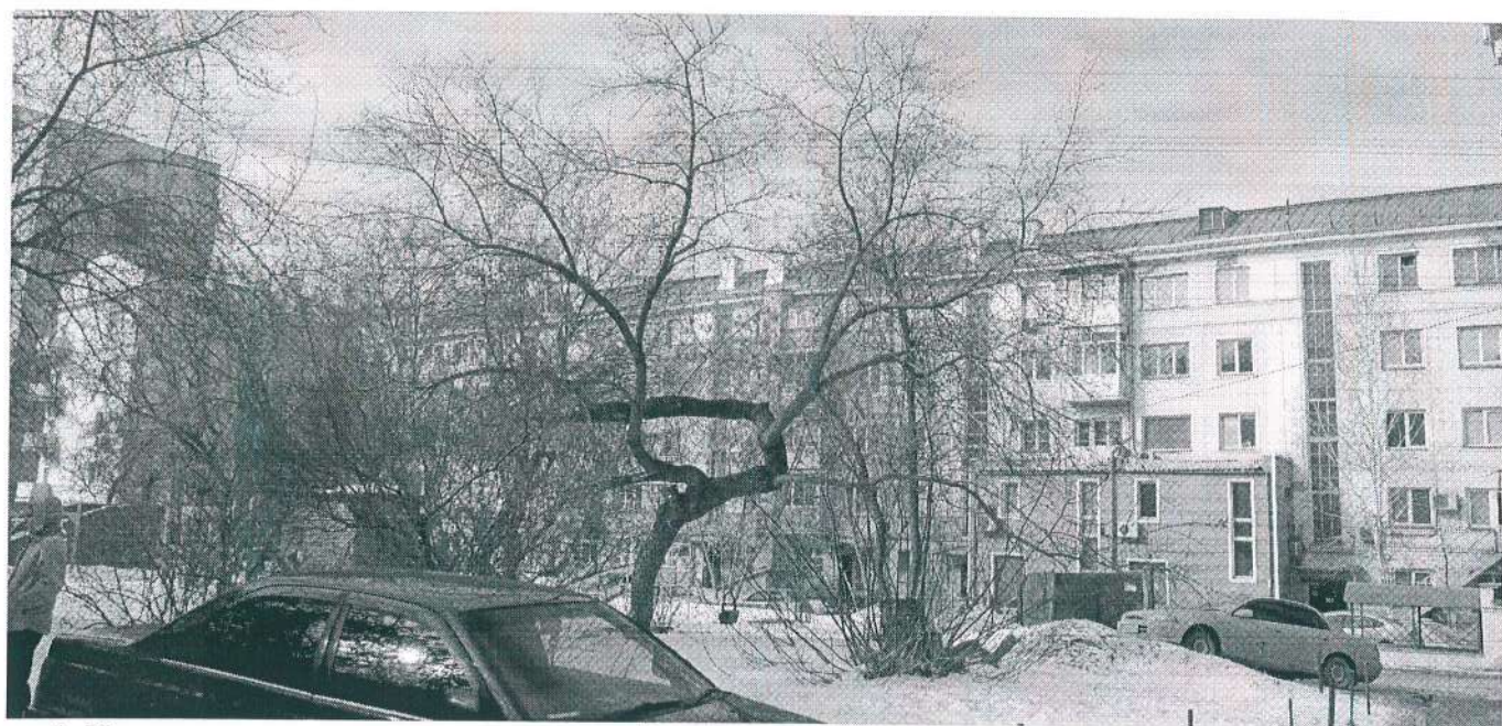
4. Центральная часть юго-восточного фасада.
