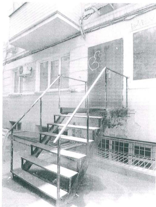
44. Вход на дворовом фасаде.
