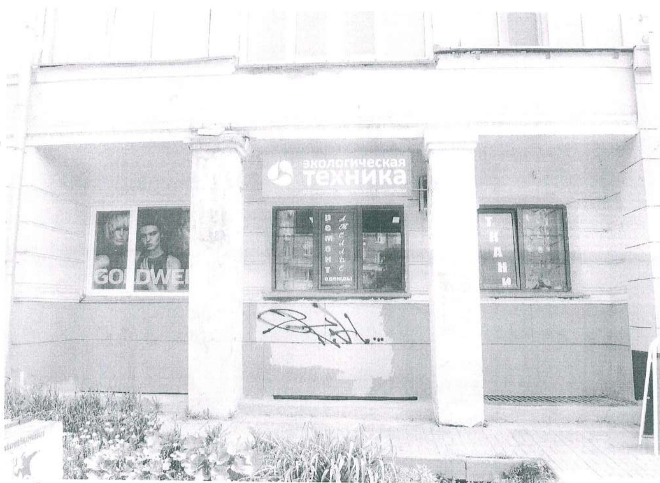
Фрагмент главного (северо-западного) фасада.
