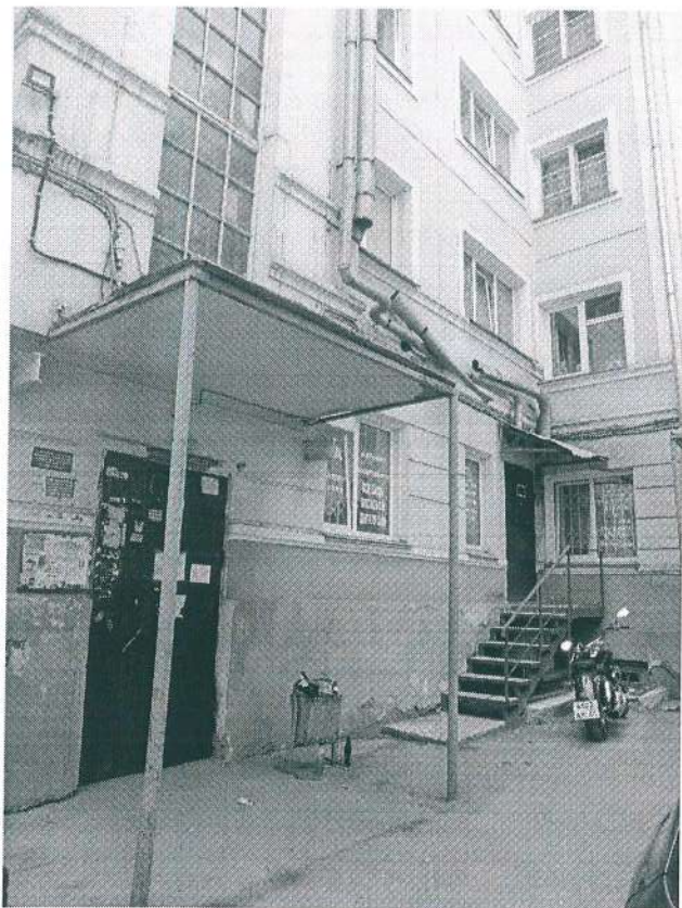
46. Фрагмент северо-восточного фасада.
