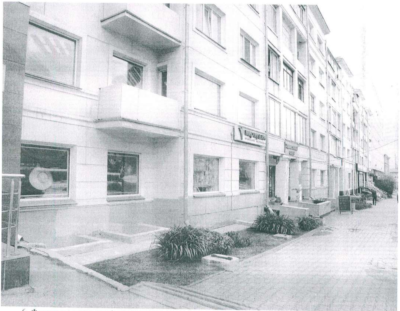
6. Фрагмент главного (северо-западного) фасада.
