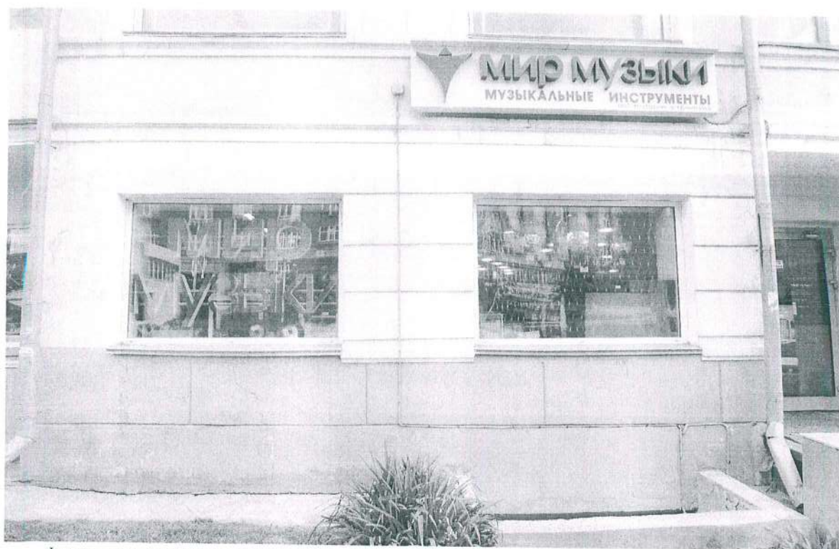
Фрагмент главного (северо-западного) фасада.
