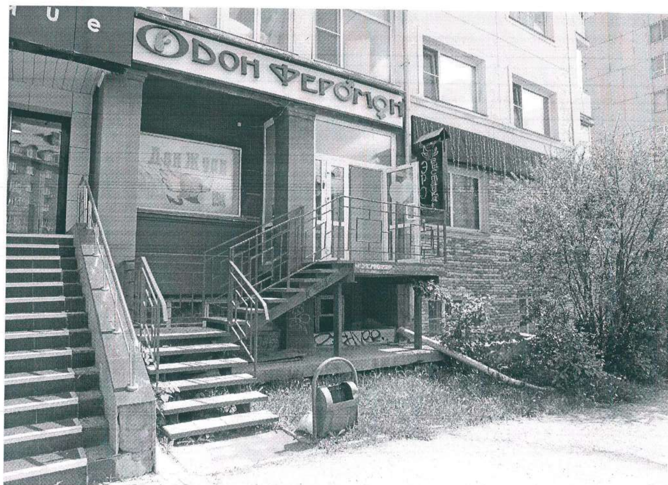
19. Фрагмент главного (северо- западного) фасада.
