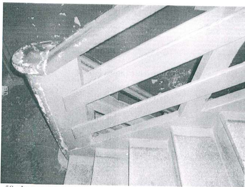
58. Фрагмент ограждения лестницы.
