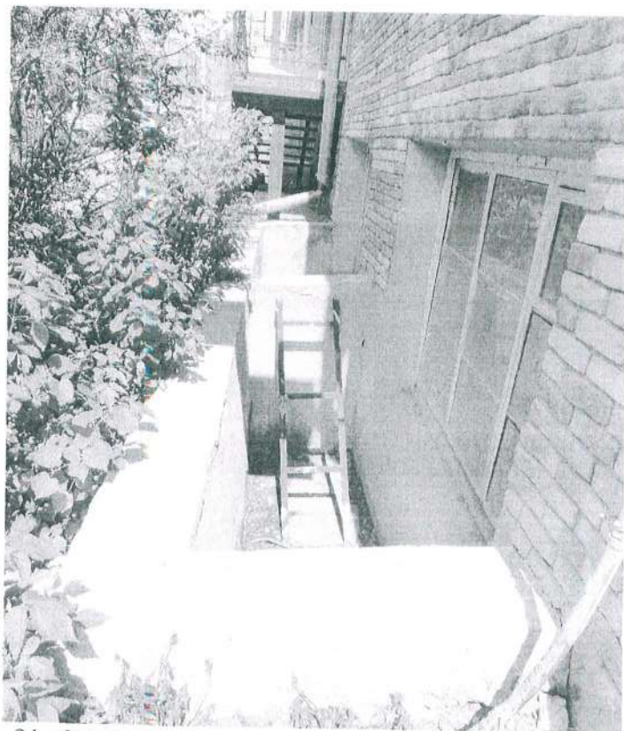
21. Фрагмент (северо- западного) фасада.
