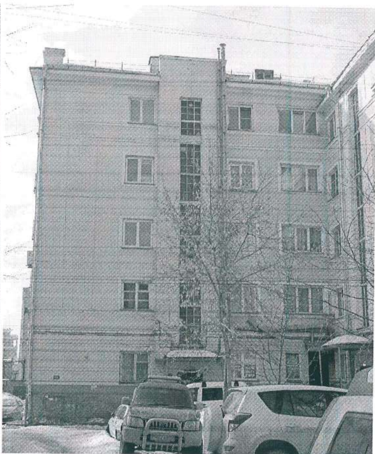
30. Южный объем: (северо-восточный) фасад.
