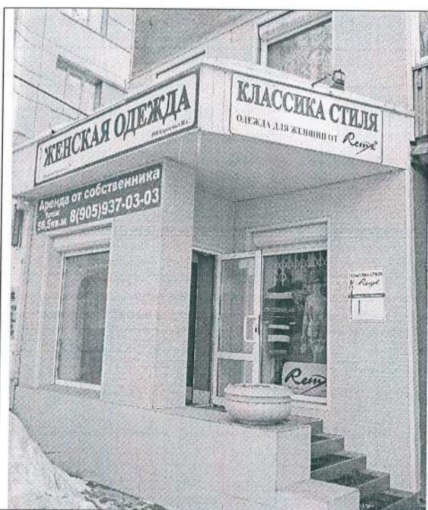
26. Современный вход на 1-ый и 2-ой этажи через современный выносной тамбур (фрагмент фото 1).
