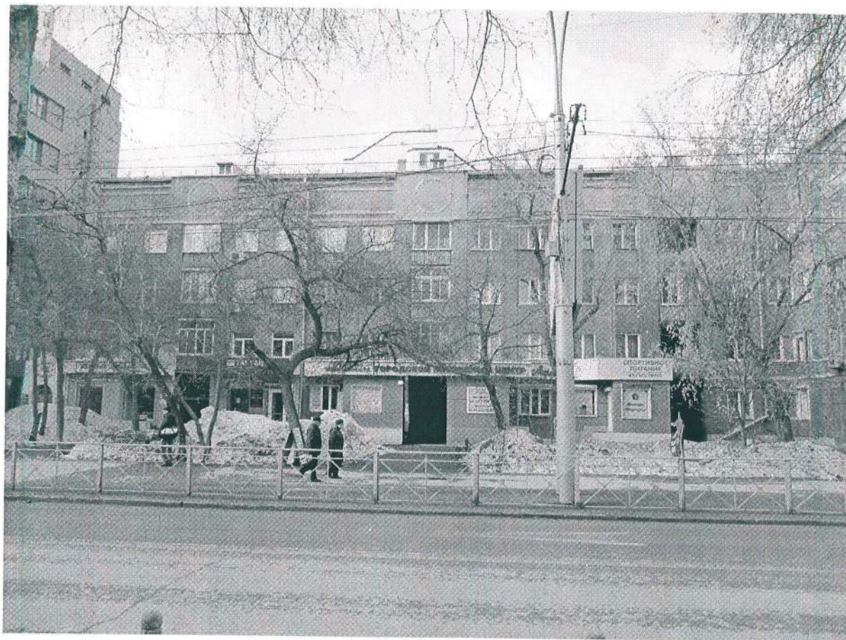
Фото 1. Восточный фасад основного объёма здания.
