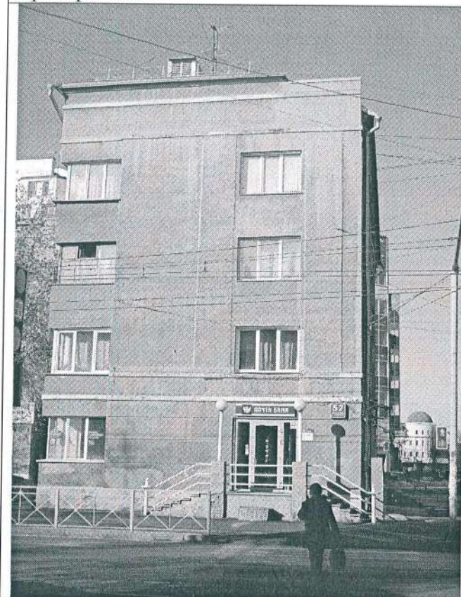
Фото 12. Восточный фасад крыла-пристройки.
