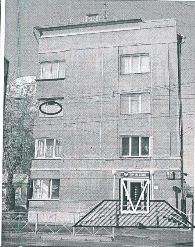
2. Восточный фасад крыла-пристройки.
