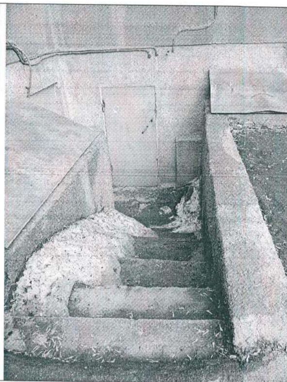
16. Открытый приямок спуска в подвал (фрагмент фото 15).
