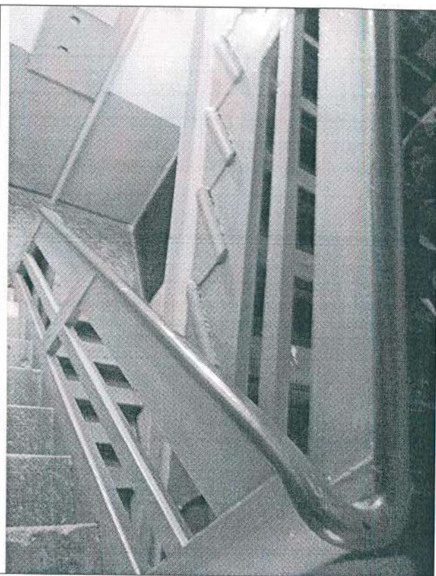
20. Вид лестничной клетки
