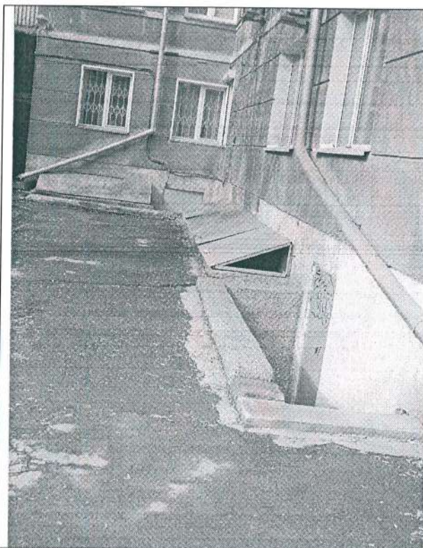
15. Оформление приямков восточного и южного фасадов (со стороны Красного проспекта).
