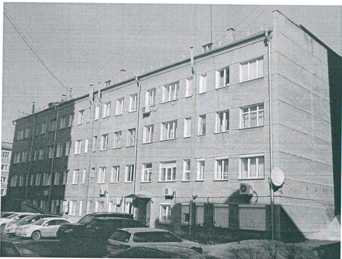
4. Западный фасад и глухая стена южного фасада основного объёма здания.
