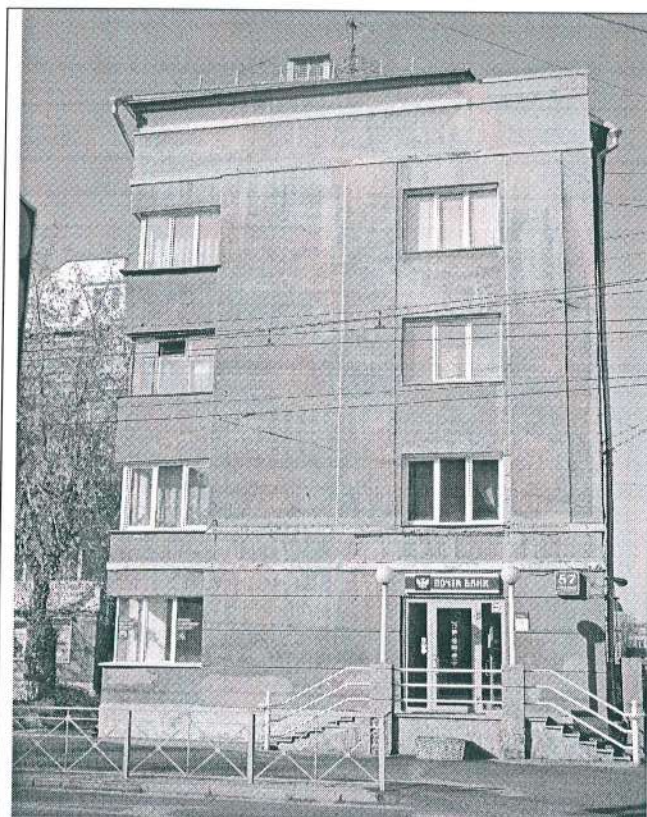
2. Восточный фасад крыла-пристройки.
