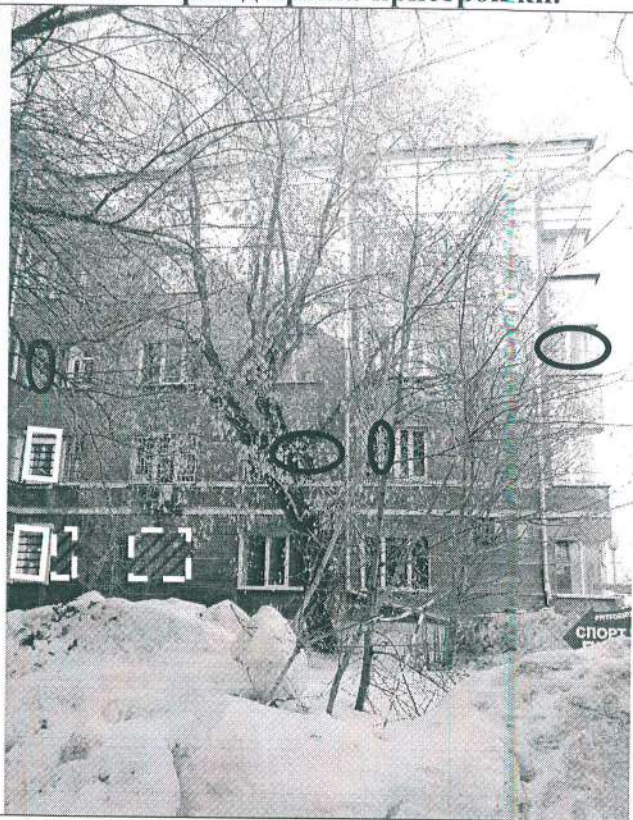
3. Южный фасад крыла-пристройки.
