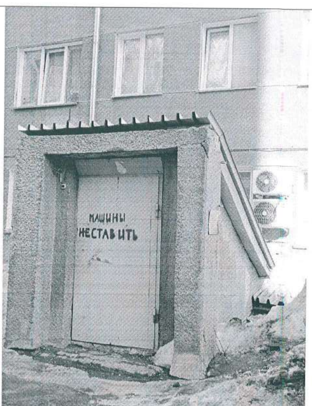
29. Спуск в подвал со стороны западного фасада (фрагмент фото 4).
