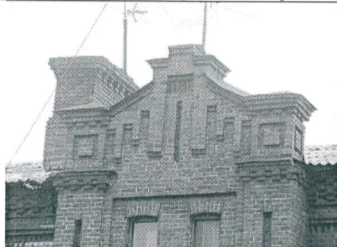
18. Аттик ризалита северо-западного фасада
