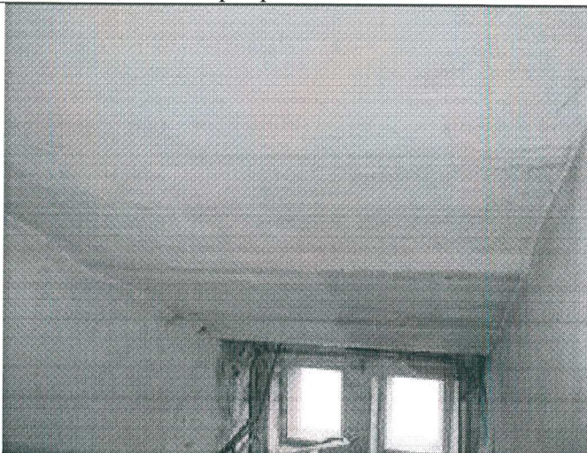
17. Сводчатое перекрытие лестничной клетки
