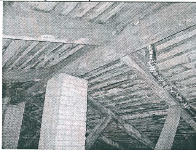
16. Фрагмент чердачного помещения
