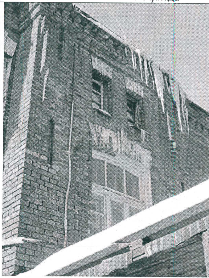
8. Ризалит юго-восточного фасада
