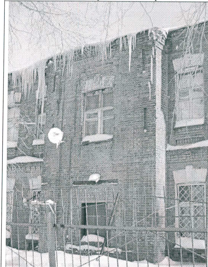
7. Ризалит северо-западного фасада
