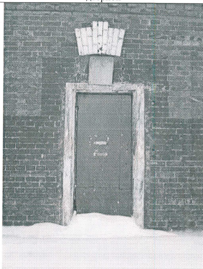
12. Оконный проем, преобразованный в дверной
