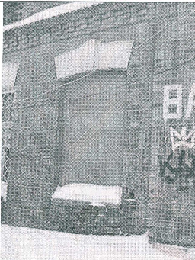
11. Дверной проем, преобразованный в оконный и позднее заложенный
