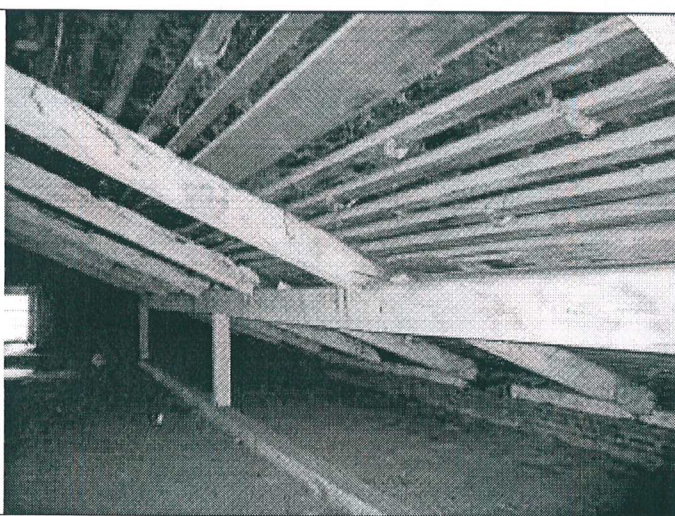
27. Фрагмент чердачного помещения
