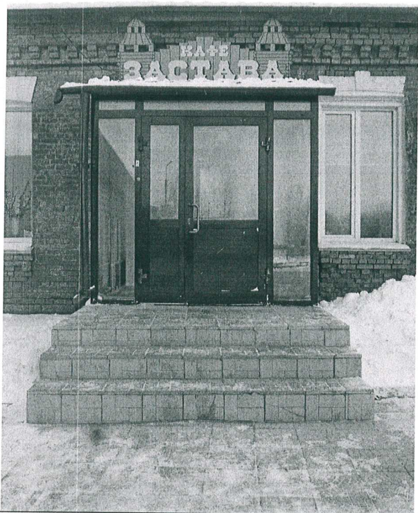
10. Входной узел на главном фасаде.
