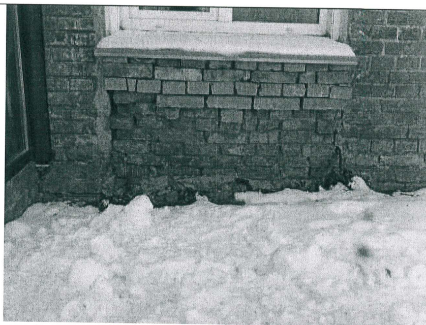
9. Фрагмент главного фасада. Утраты элементов декора.
