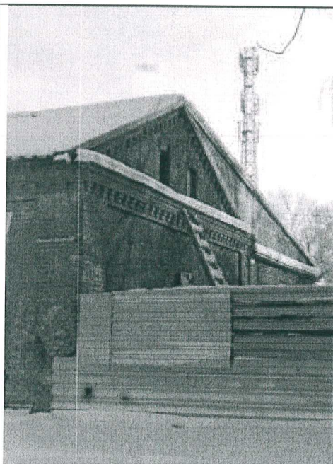
15. Примыкание ограждения к памятнику на главном фасаде.
