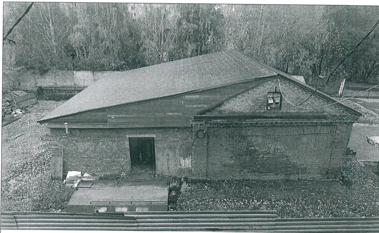
4. Общий вид северо-восточного фасада.
