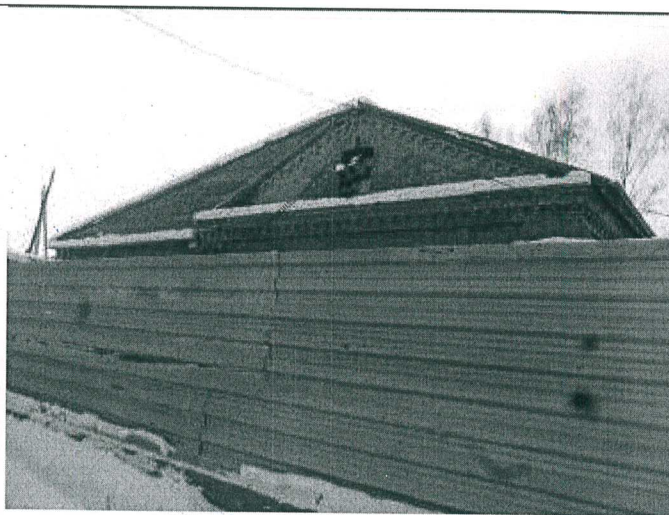
18. Ограждение территории вдоль северо-восточного фасада.
