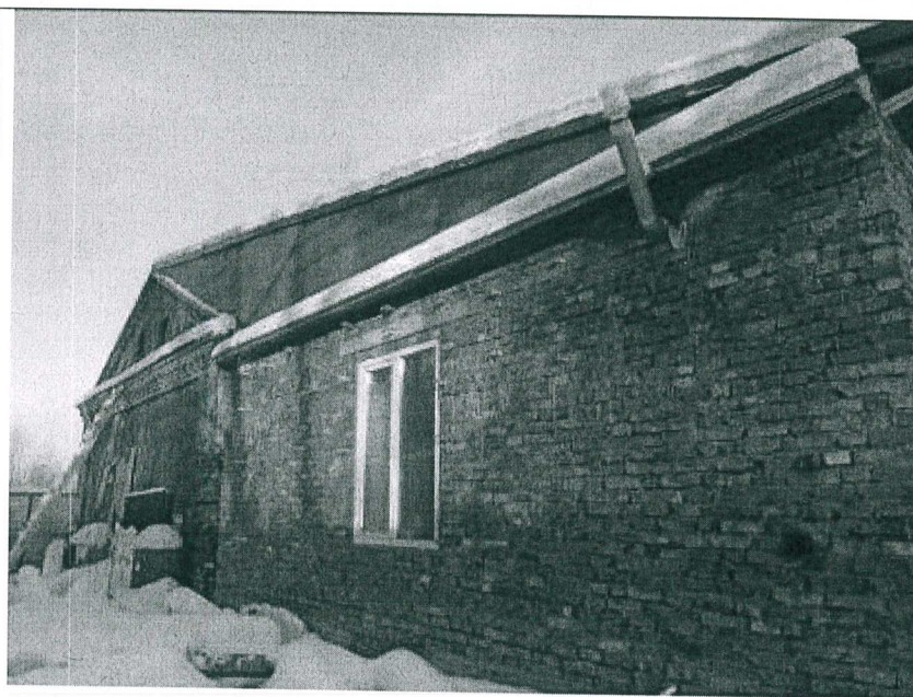
2. Общий вид юго-западного фасада.
