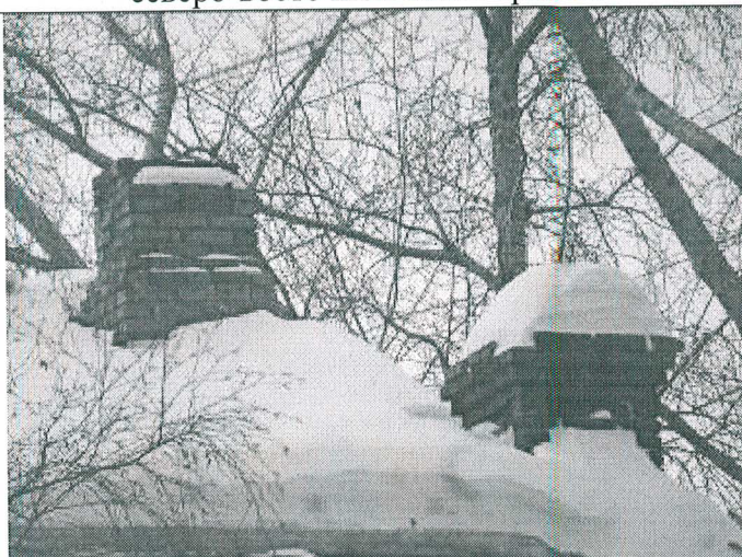
11. Дымовая труба и парапетный столбик на северо-восточном скате крыши
