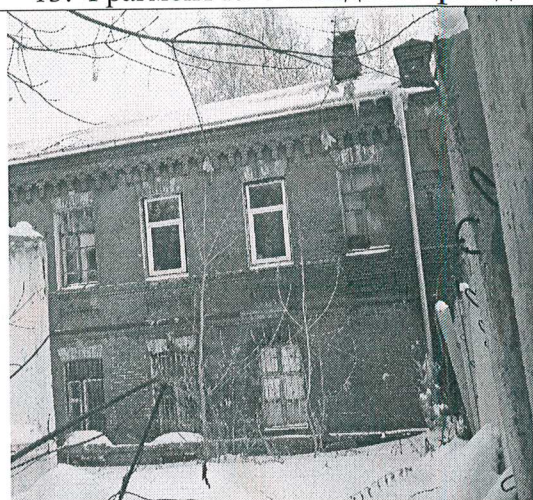
13. Фрагмент юго-западного фасада
