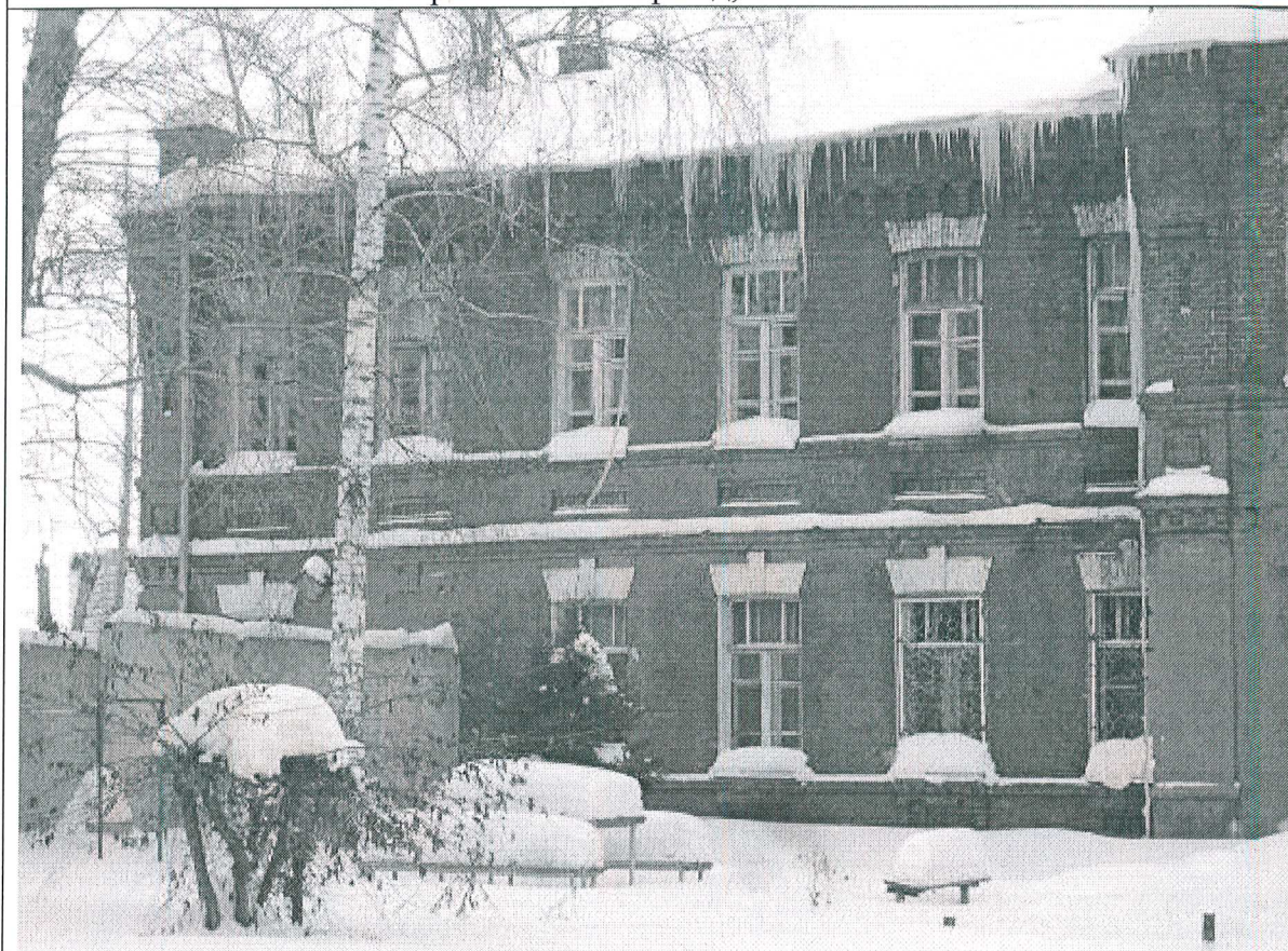
3. Северо-восточный фасад, восточная часть
