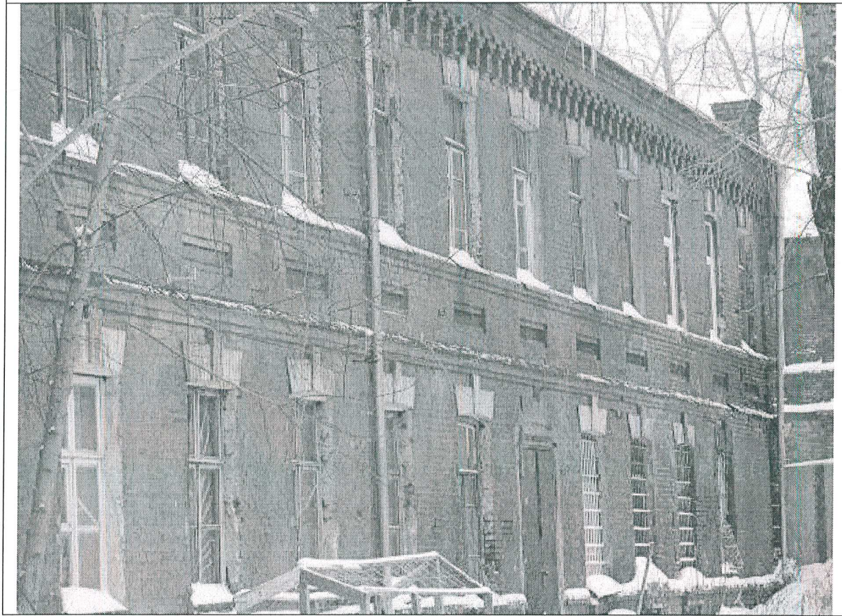
7. Юго-западный фасад, восточная часть
