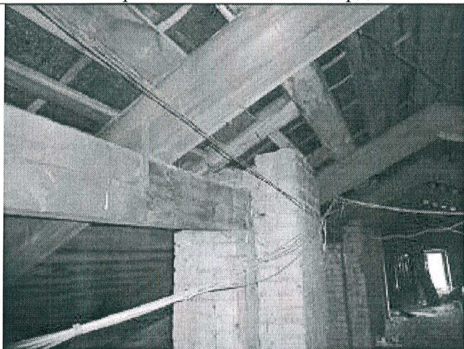
20. Фрагмент помещения чердака
