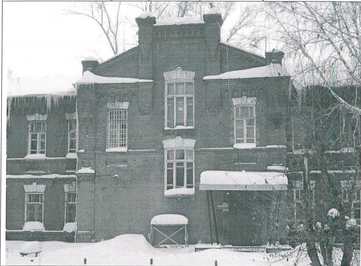
1. Центральный ризалит северо-восточного фасада
