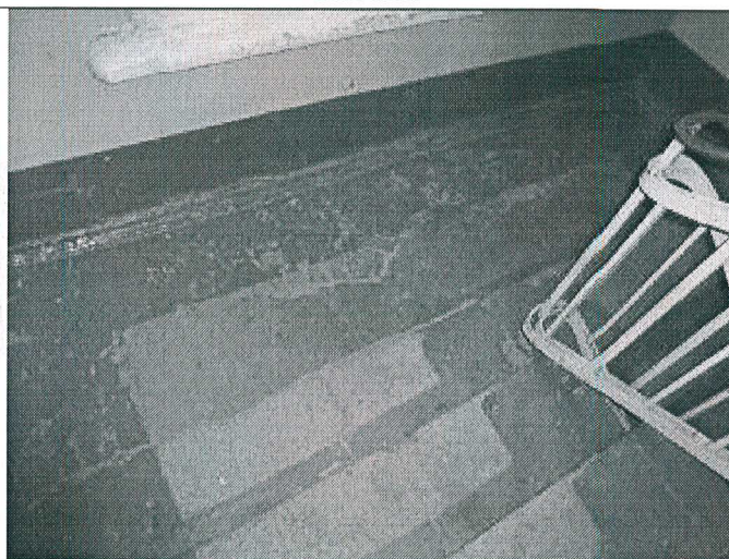
19. Междуэтажная площадка лестничной клетки
