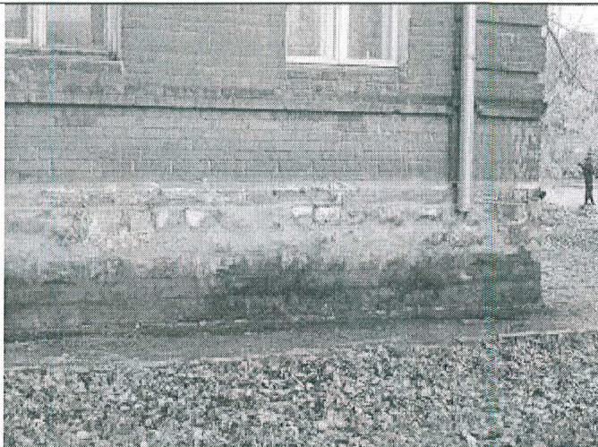
17. Фрагмент северо-восточного фасада
