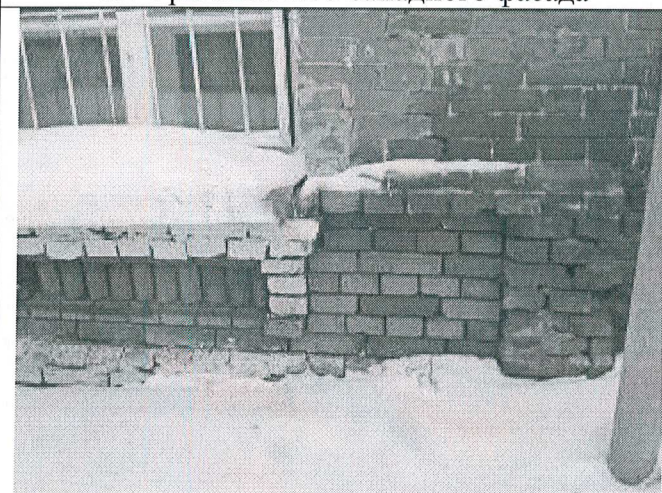
19. Фрагмент юго-западного фасада
