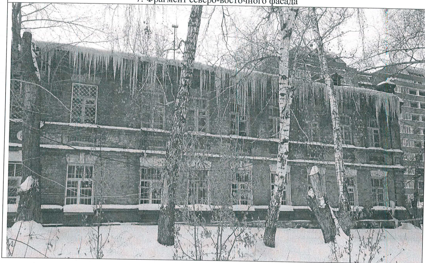
7. Фрагмент северо-восточного фасада
