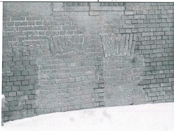
21. Заложенные оконные проемы на юго-восточном фасаде
