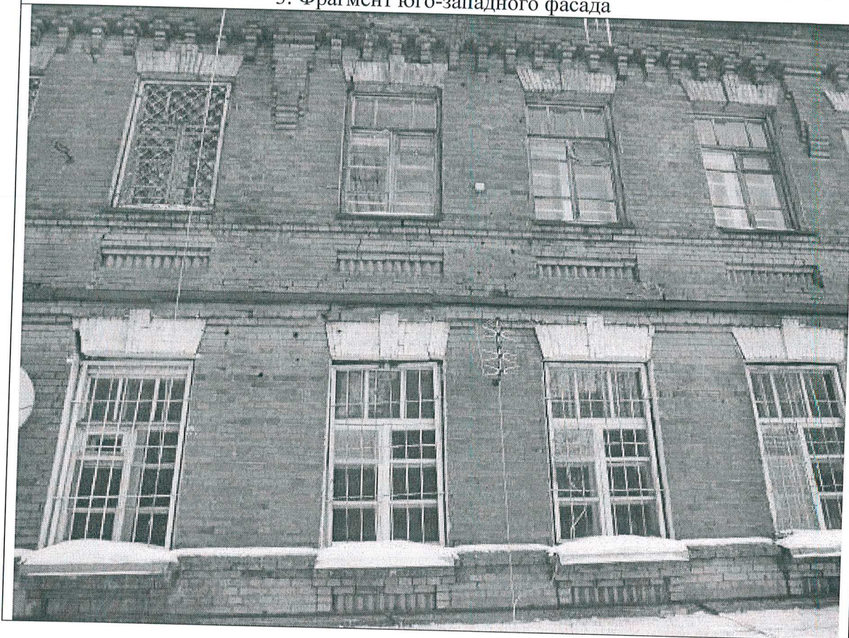
3. Фрагмент юго-западного фасада
