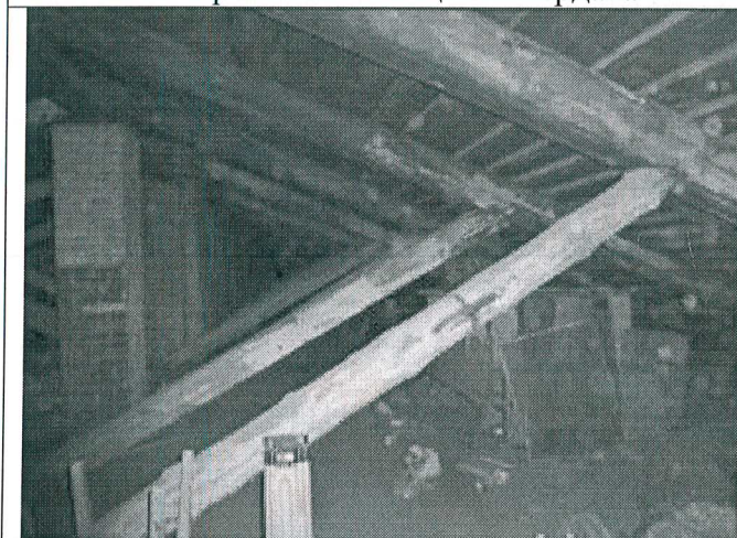
17. Фрагмент помещения чердака
