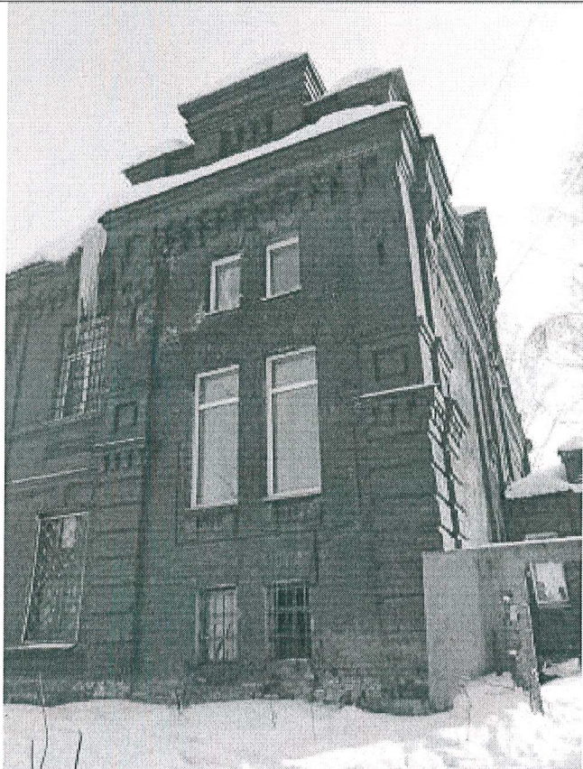
5.7. Южный ризалит. Северо-западный фасад
