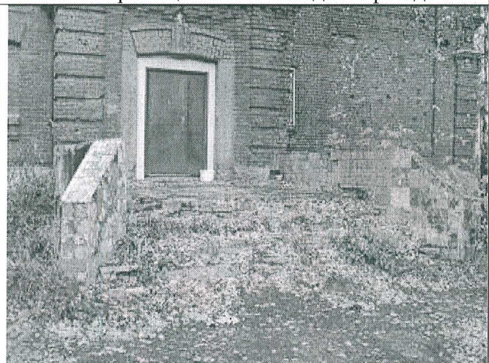
5.16. Крыльцо на юго-западном фасаде
