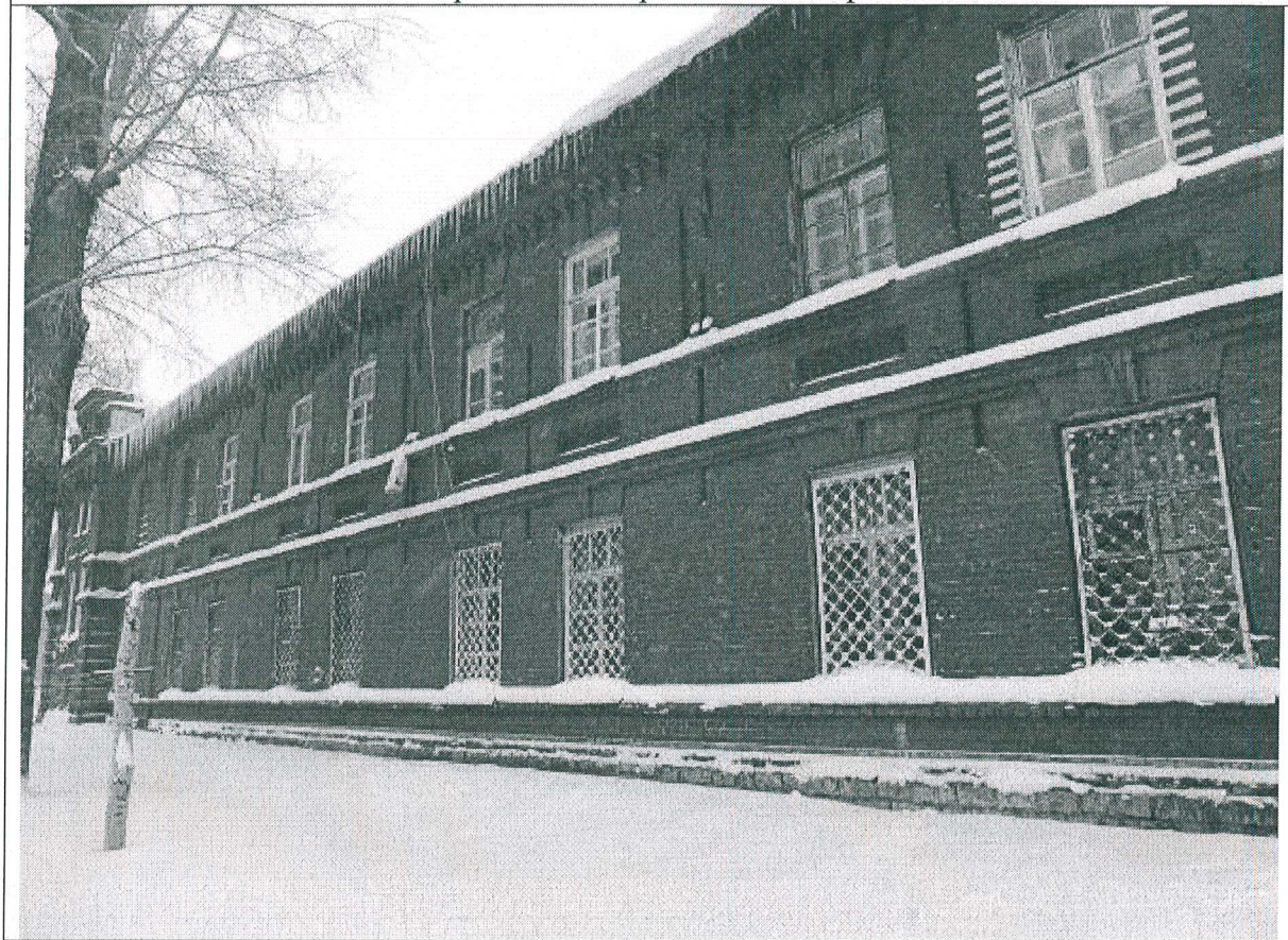
5.3. Фрагмент северо-западного фасада
