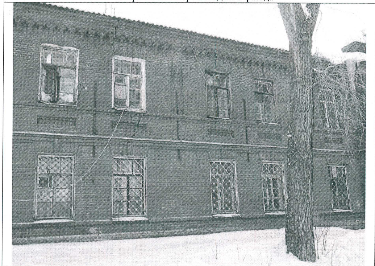
5.4. Фрагмент северо-западного фасада
