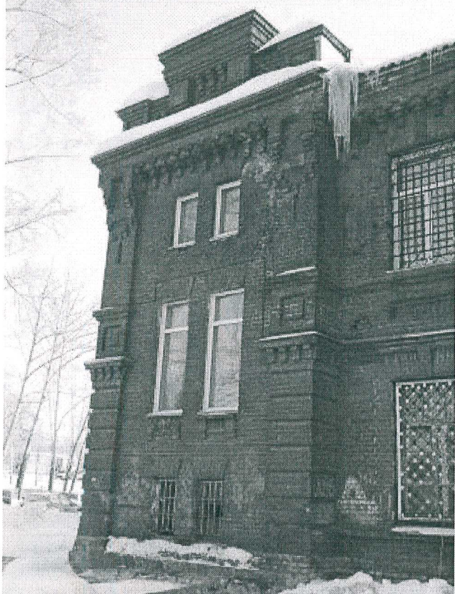
5.5. Северный ризалит. Северо-западный фасад
