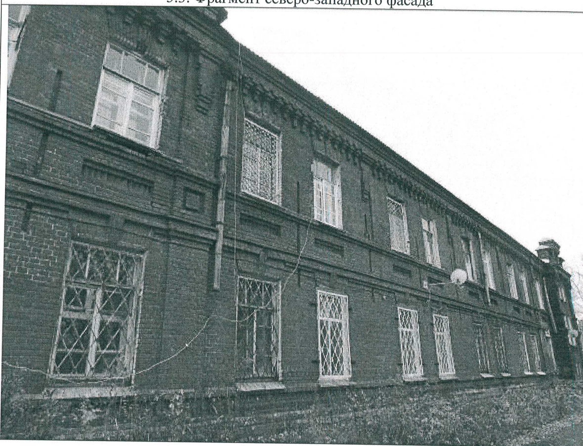
5.3. Фрагмент северо-западного фасада
