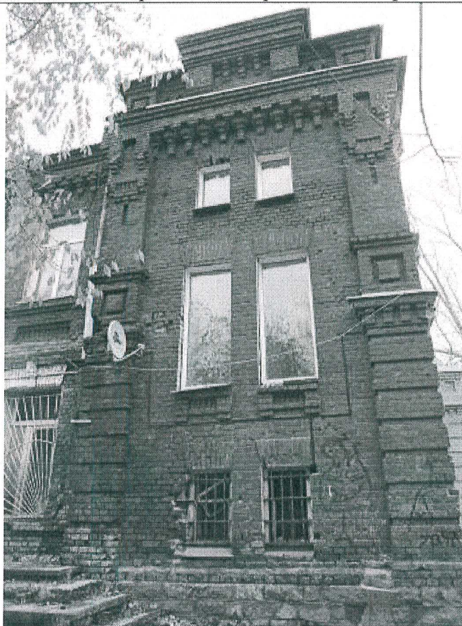
5.6. Южный ризалит, северо-западный фасад
