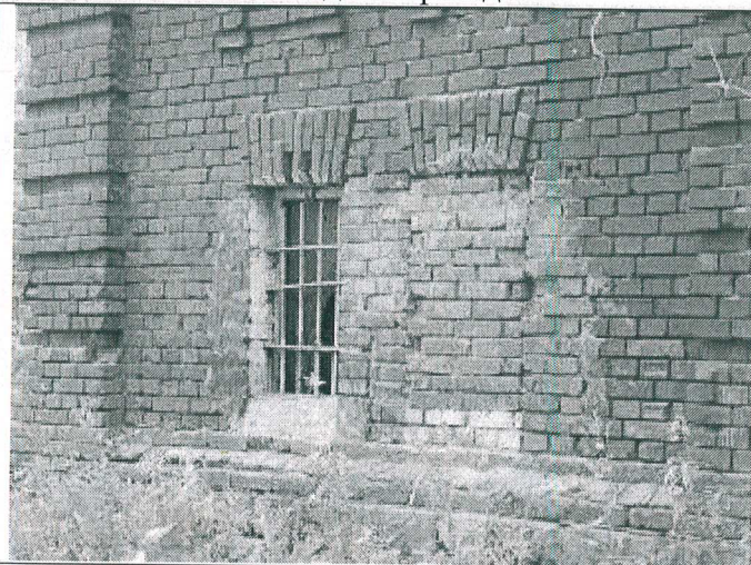
5.13. Фрагмент северного ризалита, северо-западный фасад
