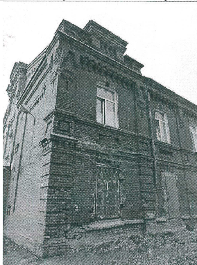
5.7. Южный ризалит, юго-восточный фасад
