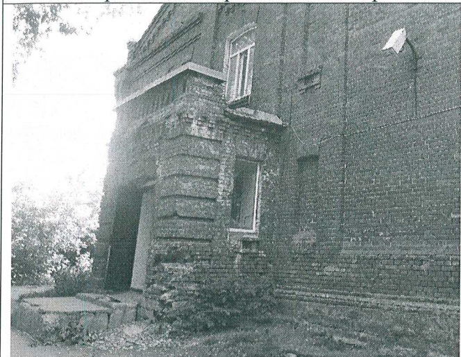
5.16. Фрагмент северо-восточного фасада
