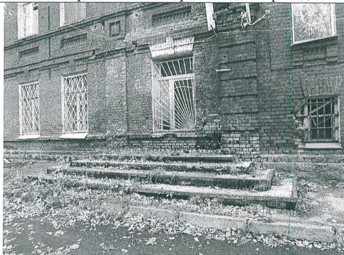
5.17. Крыльцо на северо-западном фасаде
