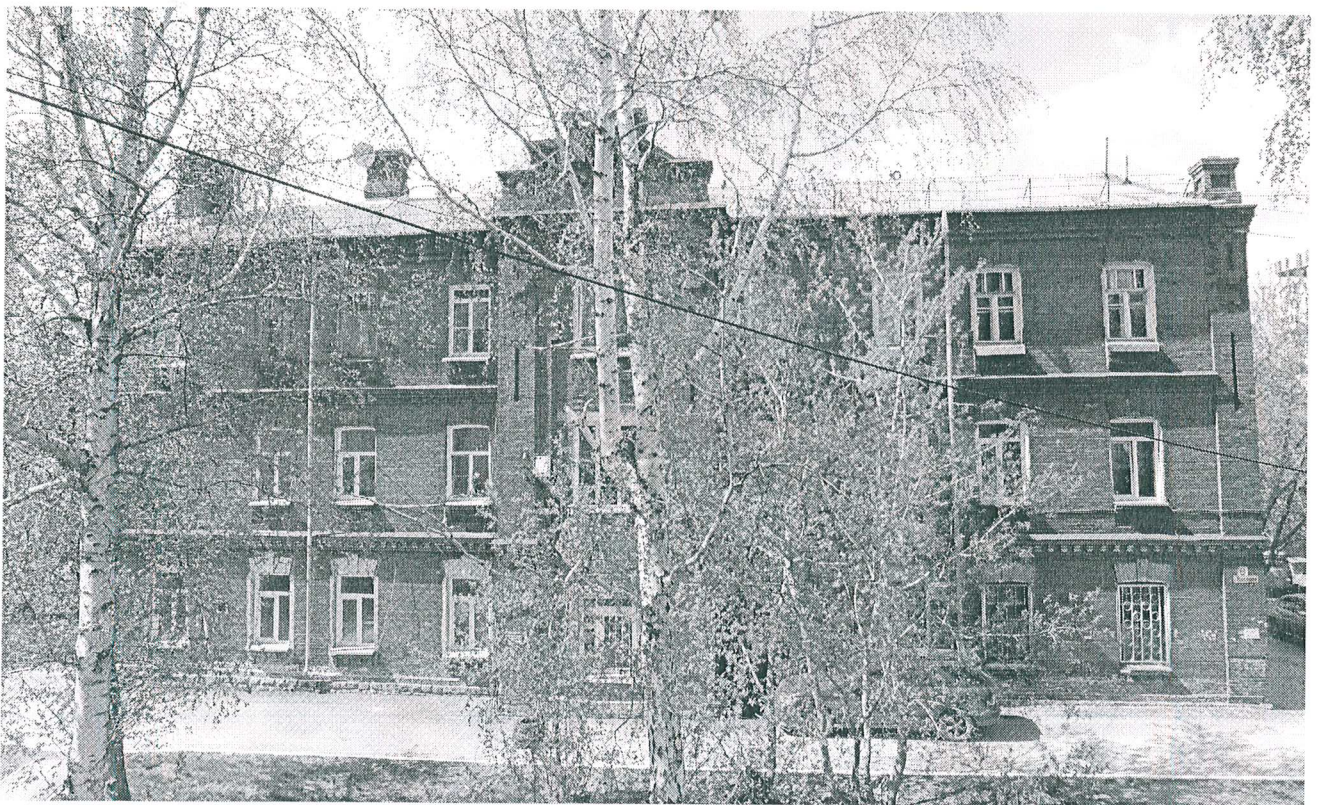
2. Общий вид дворового (юго-восточного) фасада Памятника.
