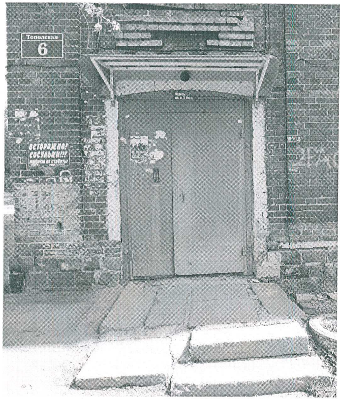
12. Вход в ризалите (подъезд №1).
