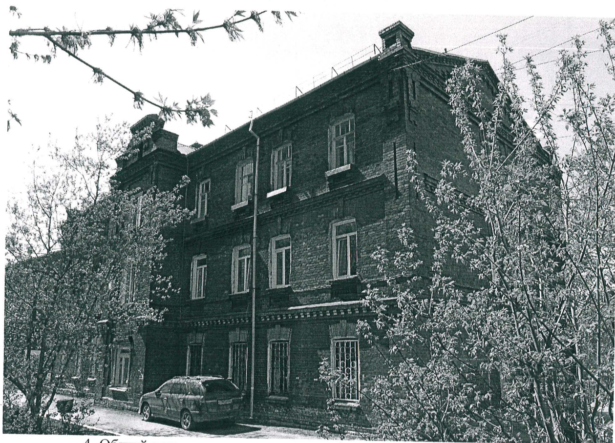
4. Общий вид дворового и торцевого (северо-восточного) фасадов.
