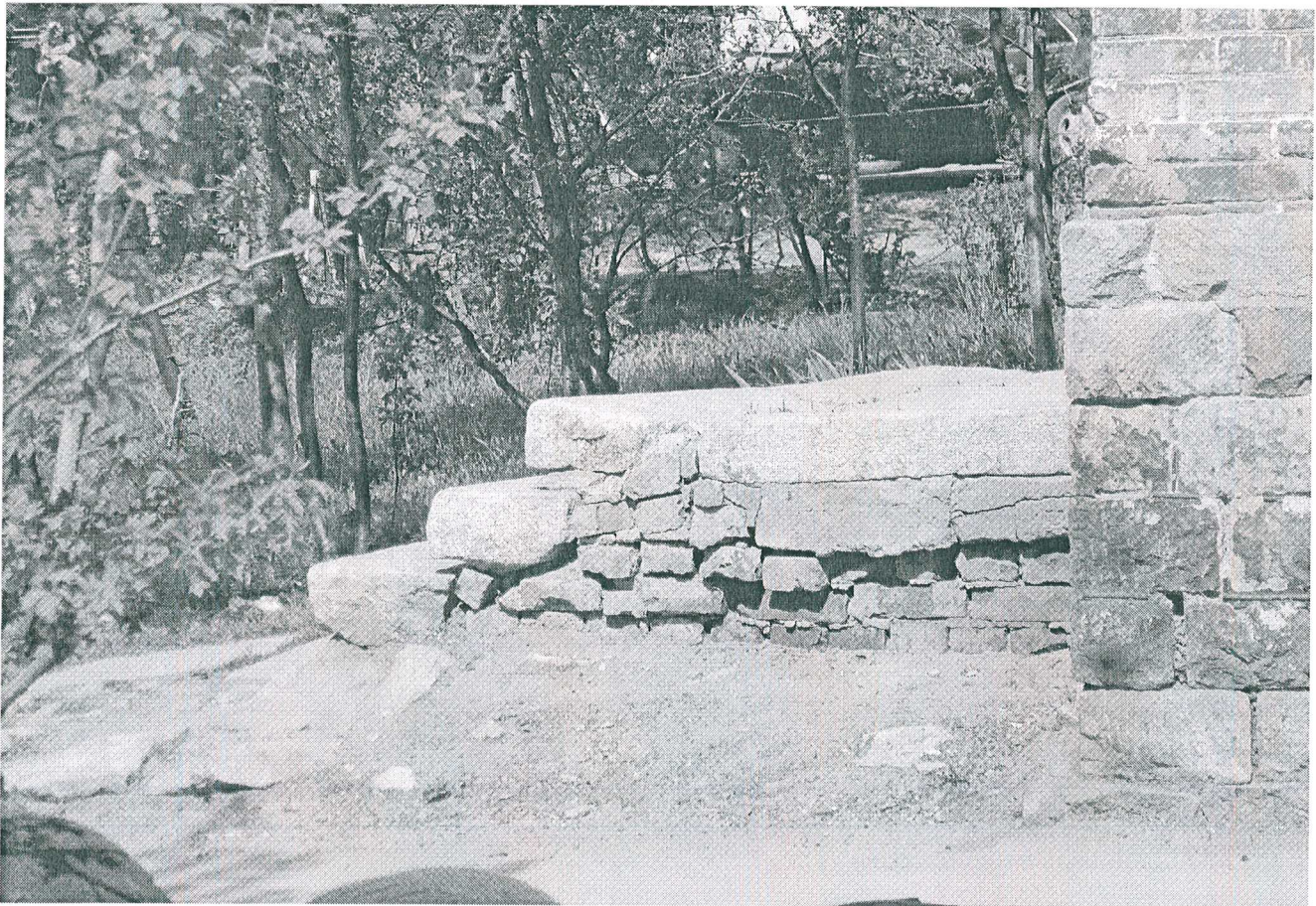
13. Крыльцо подъезда № 2 (вид со стороны торцевого фасада).
