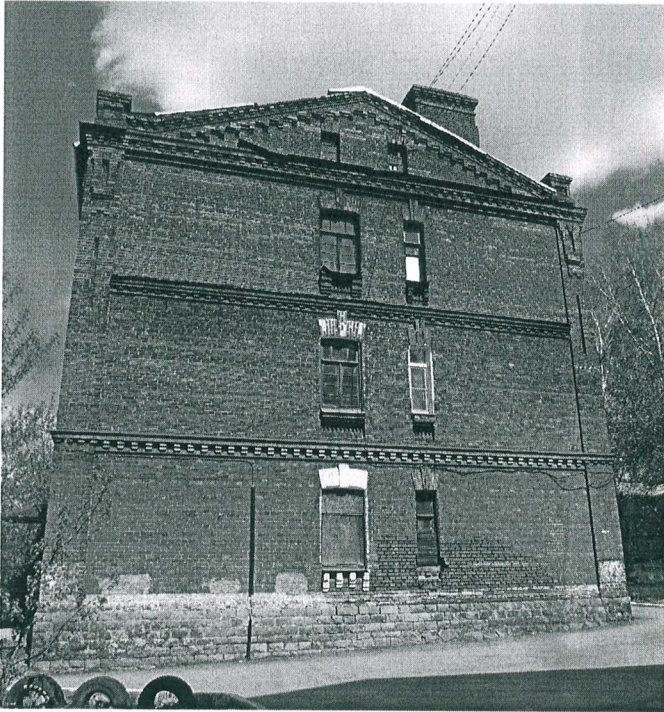
14. Вид торцевого (юго-западного) фасада.
