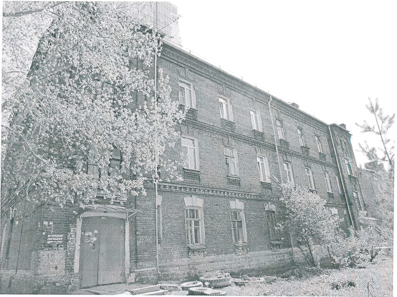
1. Общий вид главного (северо-западного) фасада Памятника.
