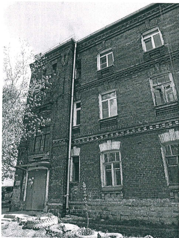
9. Фрагмент главного фасада.
