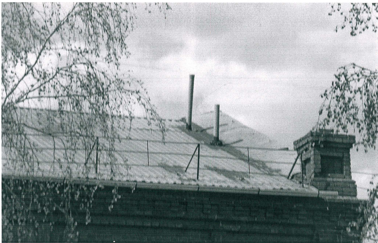
21. Общий вид кровли с северо-западной стороны.
