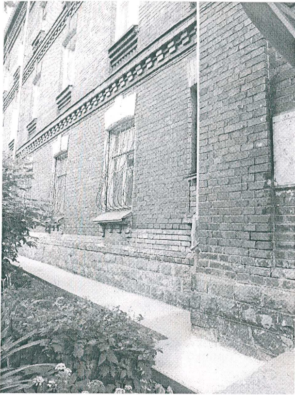
11. Фрагмент главного фасада: отмостка, цоколь.
