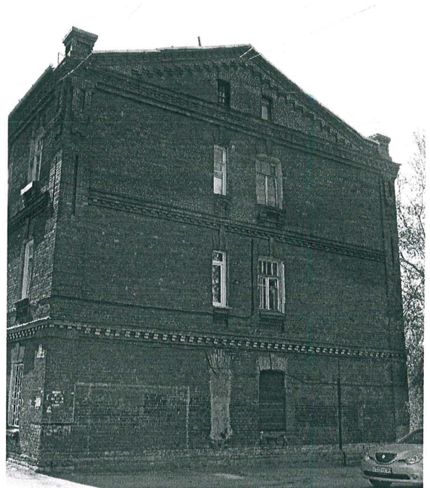
15. Вид торцевого (северо-восточного) фасада.
