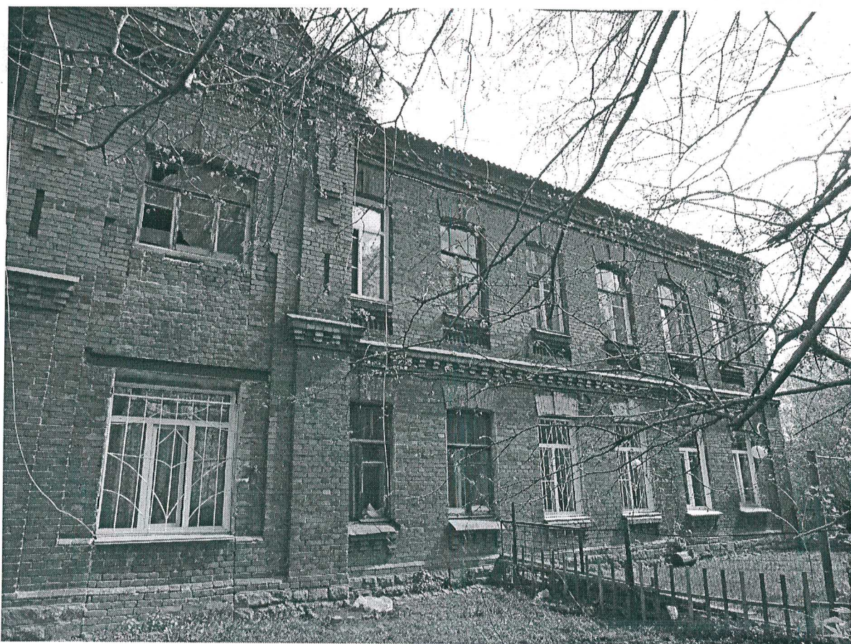
11. Фрагмент дворового фасада (южное крыло). Предмет охраны – кирпичный декор.
