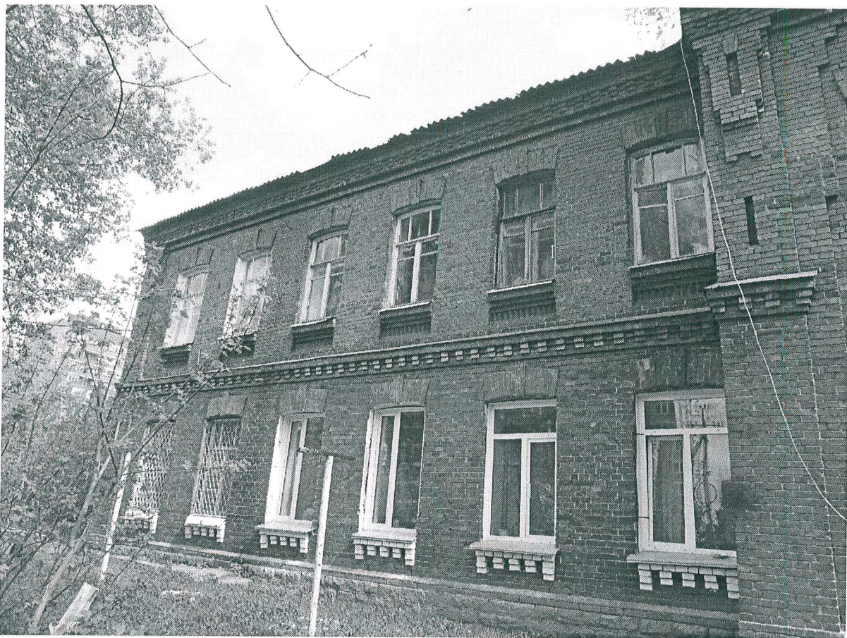
10. Фрагмент дворового фасада (северное крыло). Предмет охраны – кирпичный декор.
