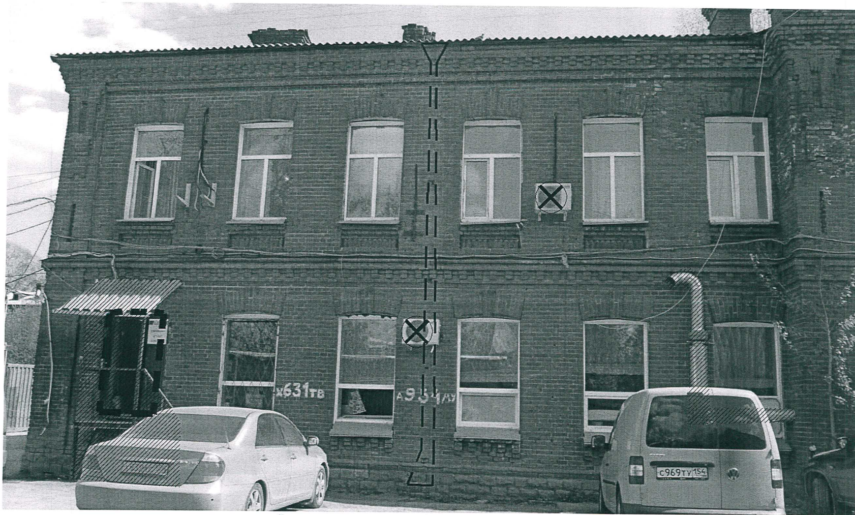
Фрагмент дворового (северо-западного) фасада: северное крыло.
