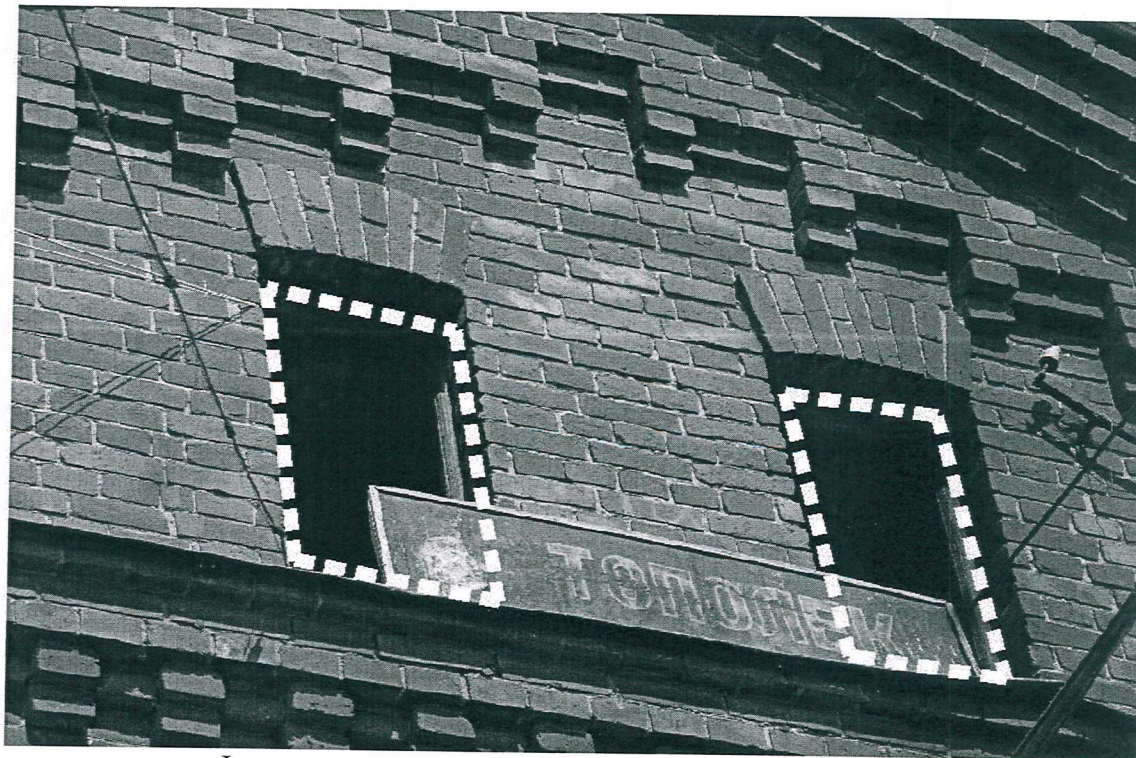
Фрагмент юго-западного фасада.
