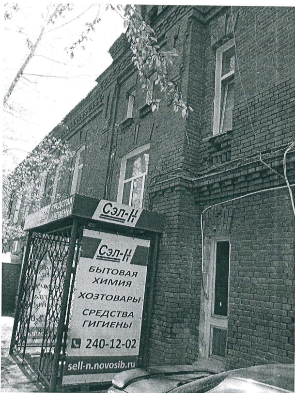
14. Фрагмент главного фасада. Утраты и поздние наслоения на ризалите.
