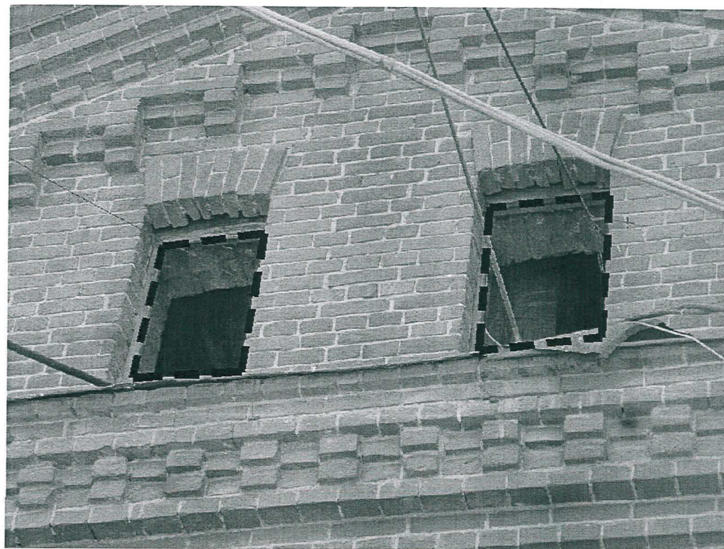
Фрагмент северо-восточного фасада.
