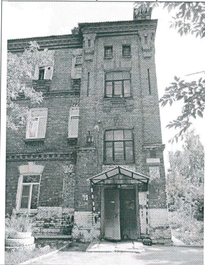
4. Ризалит северо-западного фасада
