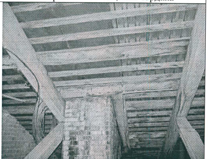
22. Фрагмент помещения чердака
