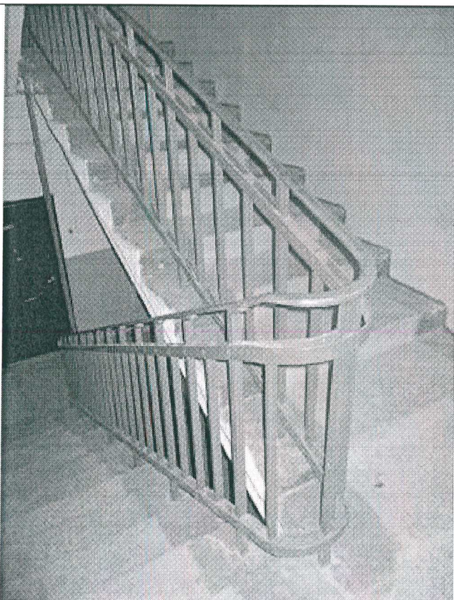
17. Фрагмент помещения северной лестничной клетки
