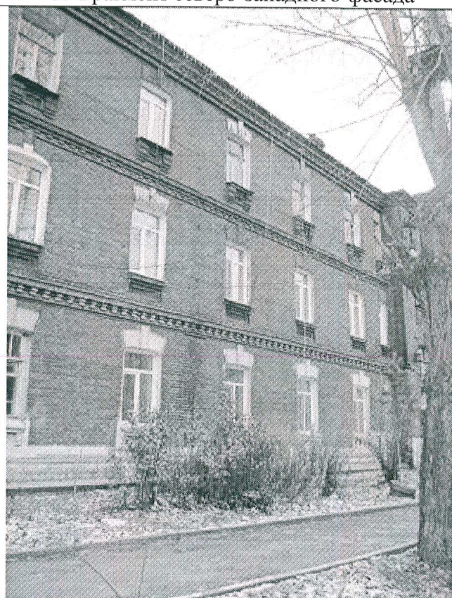
3. Фрагмент северо-западного фасада
