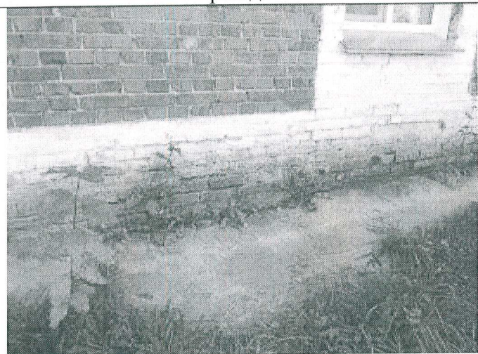
22. Цоколь и отмостка на северо-восточном фасаде
