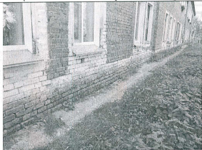
24. Цоколь и отмостка северо-западного фасада
