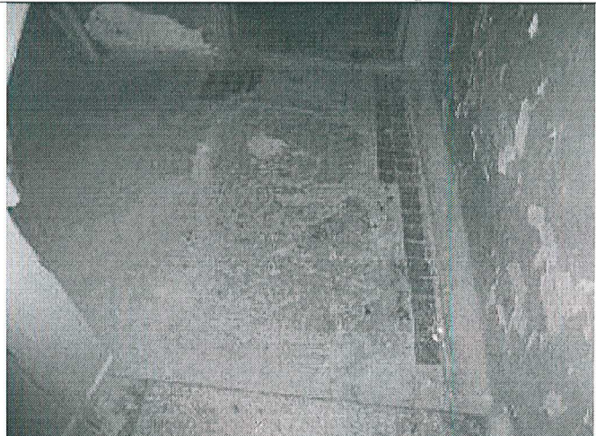
31. Лестничная площадка, первый этаж
