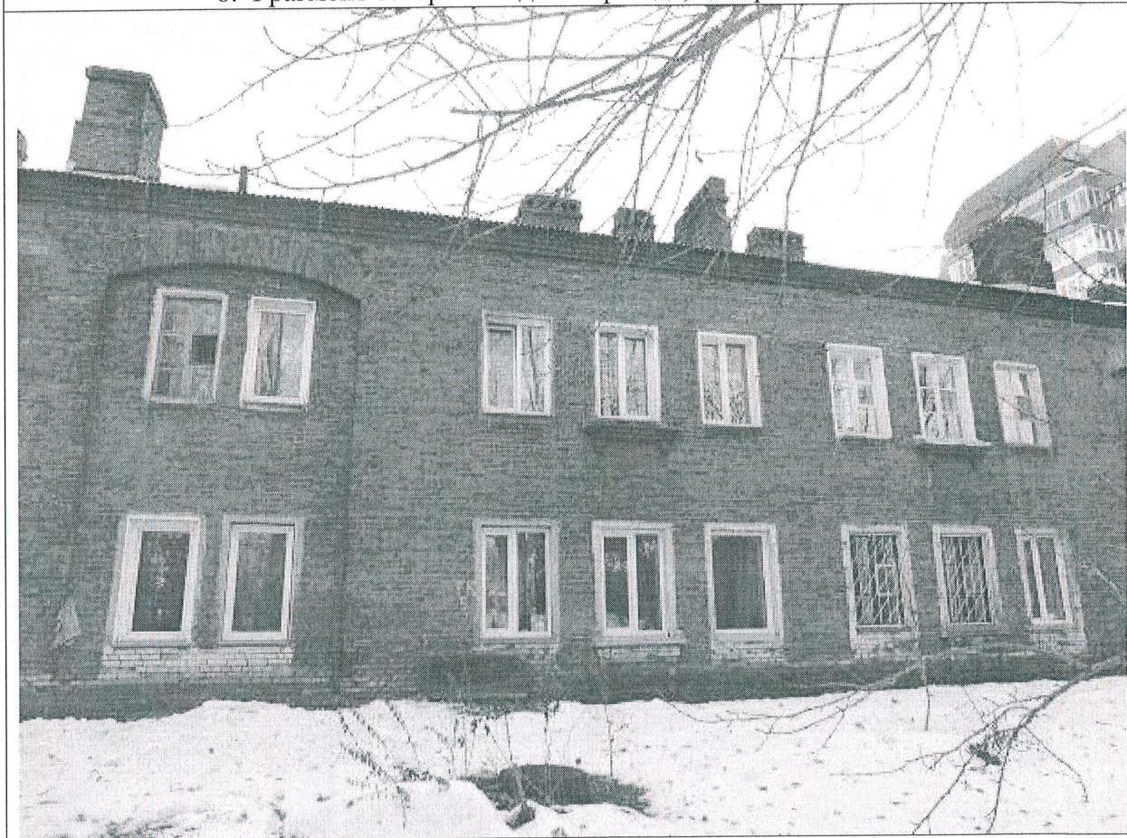
8. Фрагмент северо-западного фасада, центральная часть
