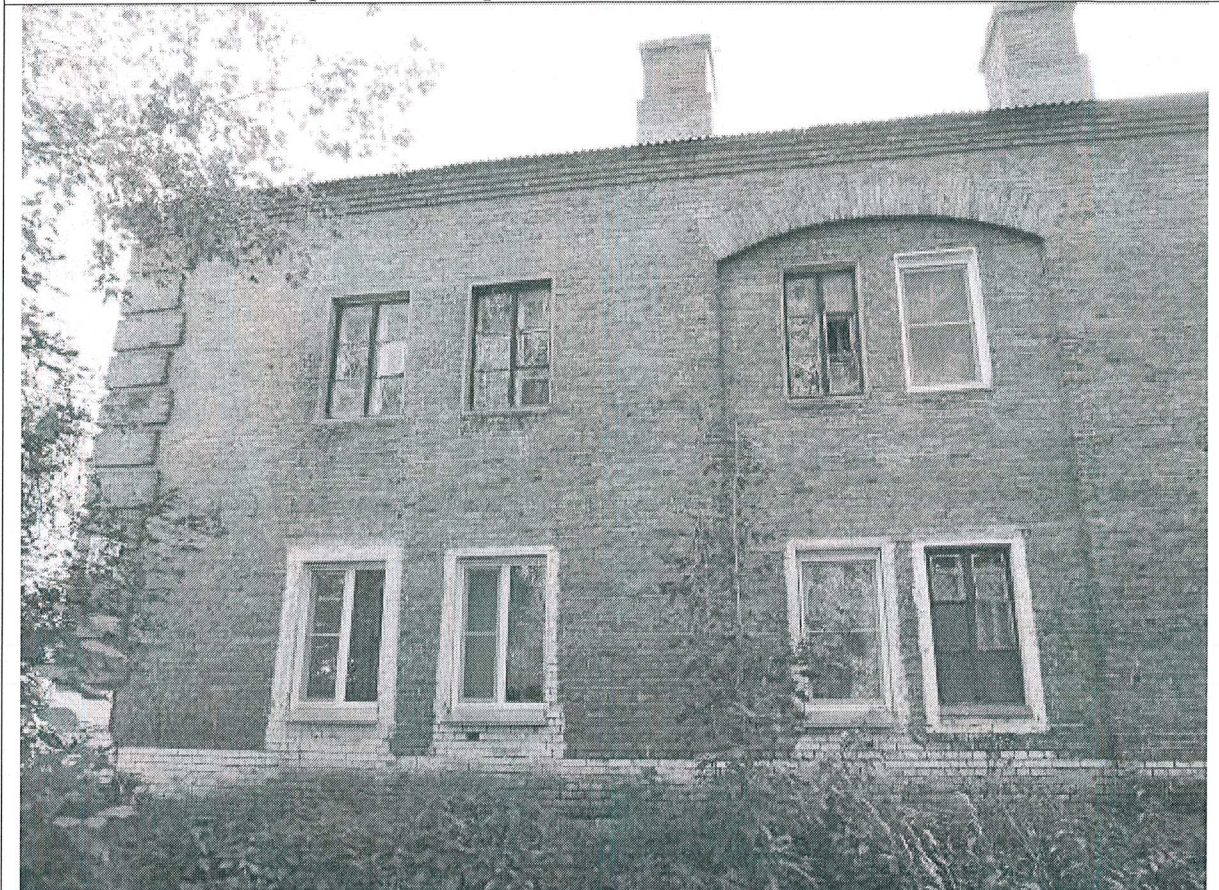
6. Фрагмент северо-западного фасада, северная часть
