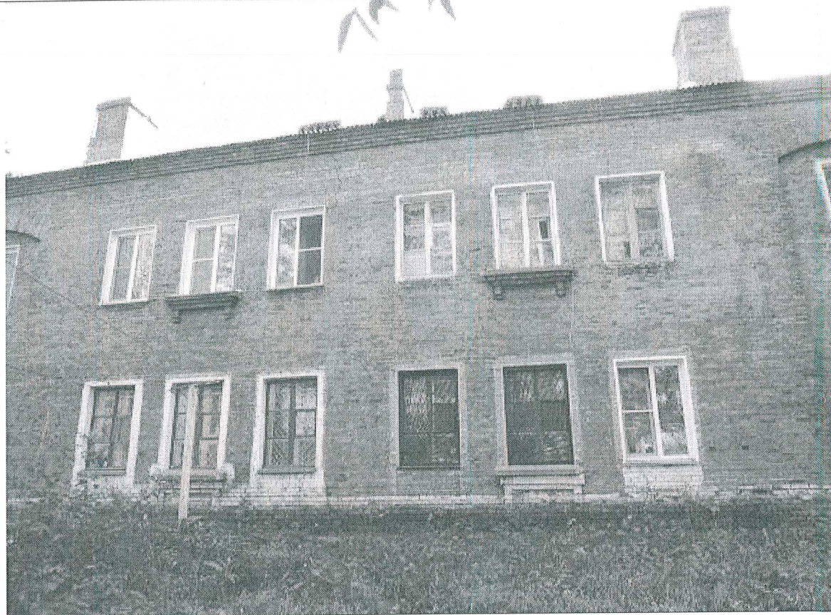
7. Фрагмент северо-западного фасада, центральная часть
