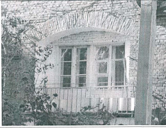
17. Первоначальный балконный блок
