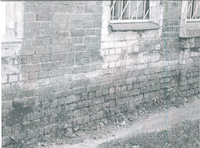
25. Фрагмент северо-западного фасада
