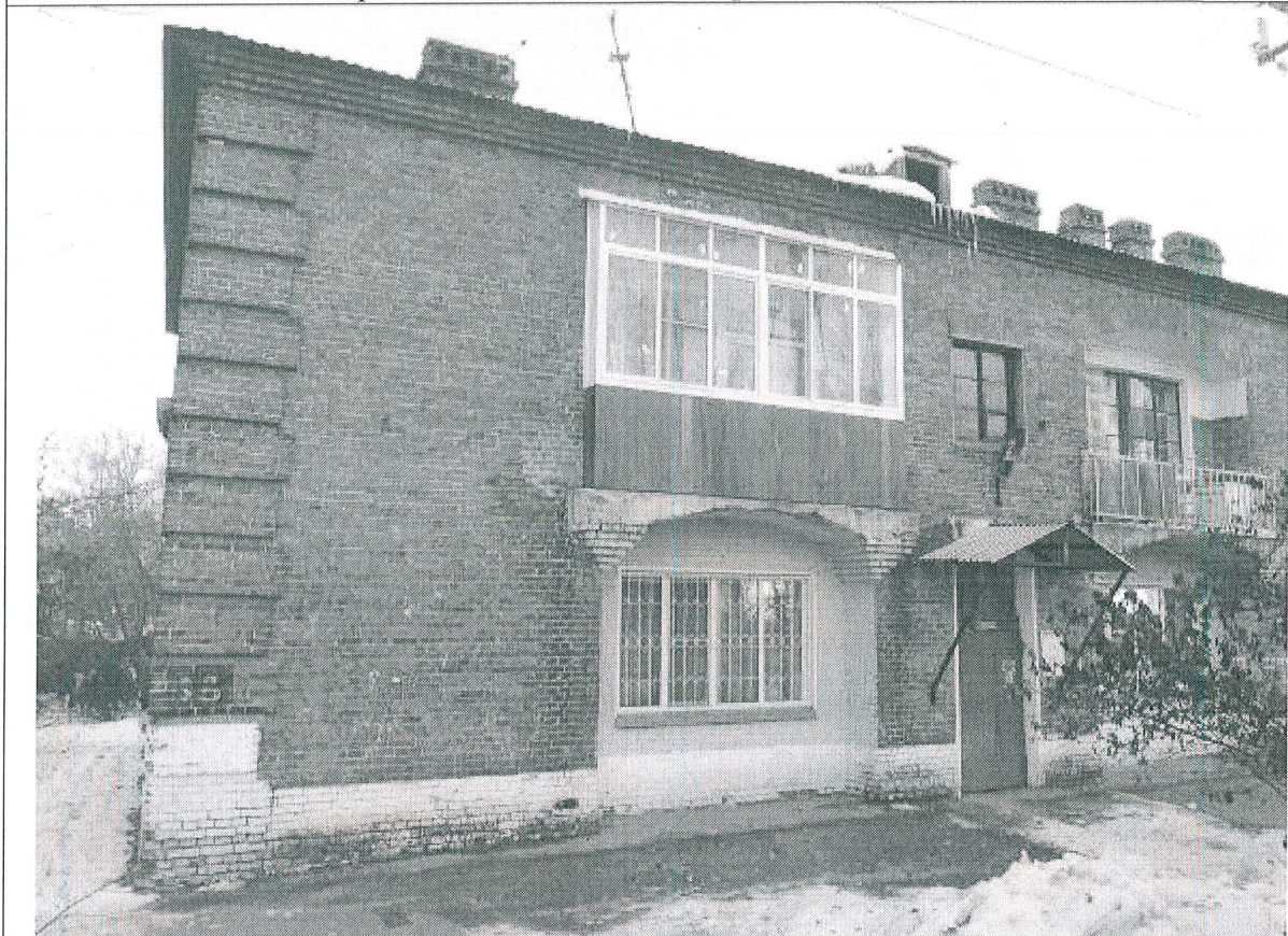
1. Фрагмент юго-восточного фасада, южная часть
