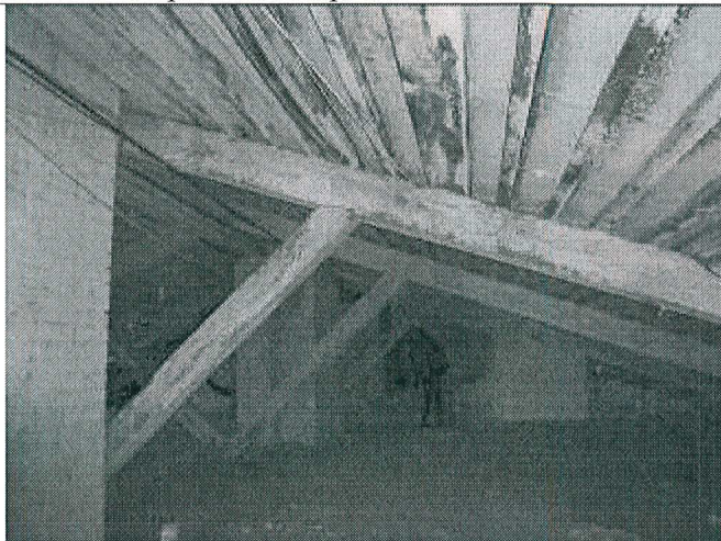
21. Фрагмент чердачного помещения
