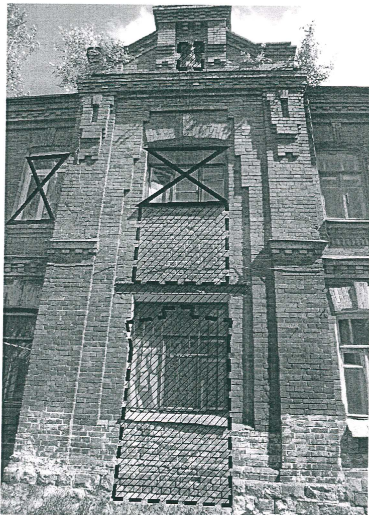
Северный ризалит дворового фасада.
