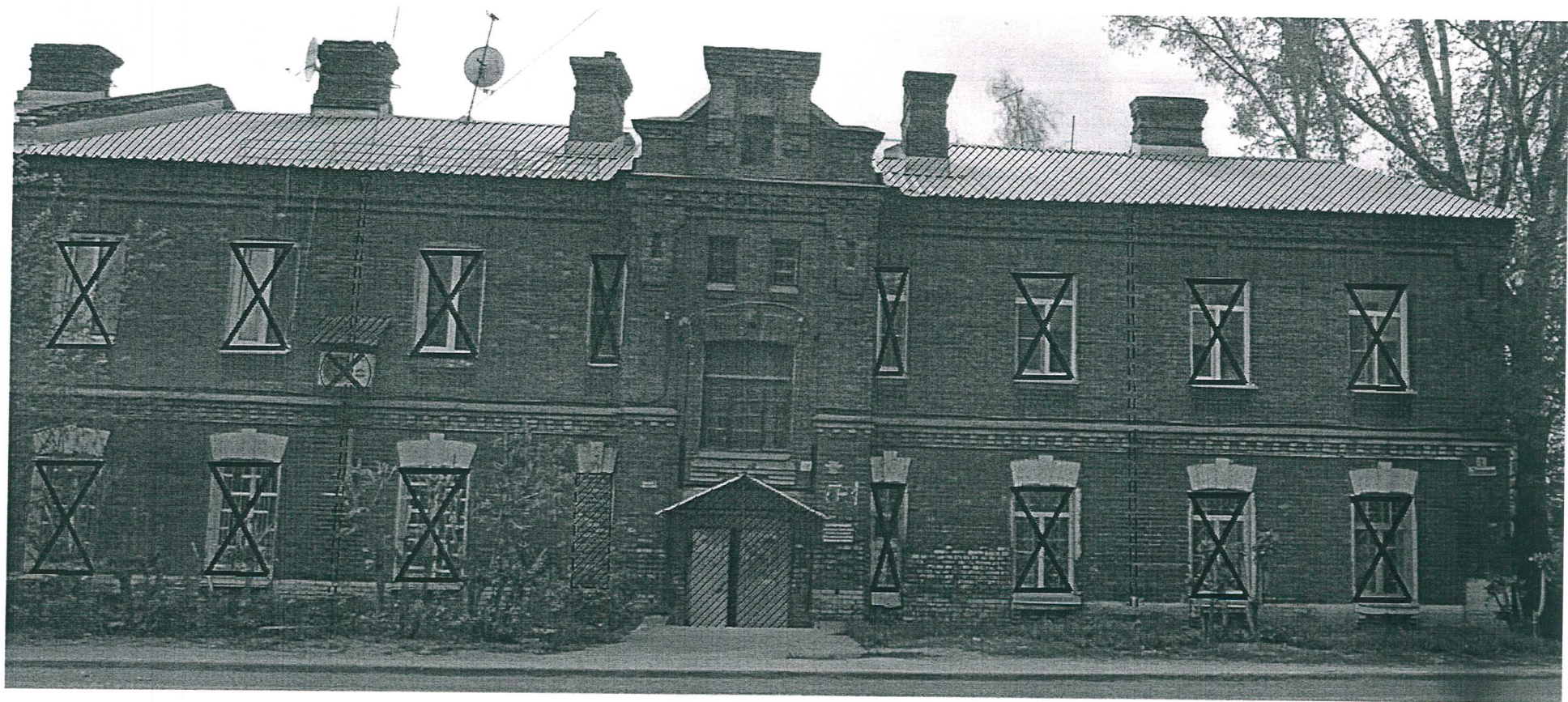
Фрагмент главного (юго-восточного) фасада: северное крыло.
