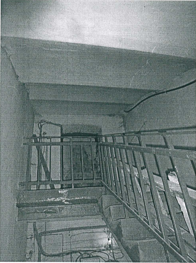
26. Предметы охраны: кирпичные своды и лестница в лестничной клетке.
