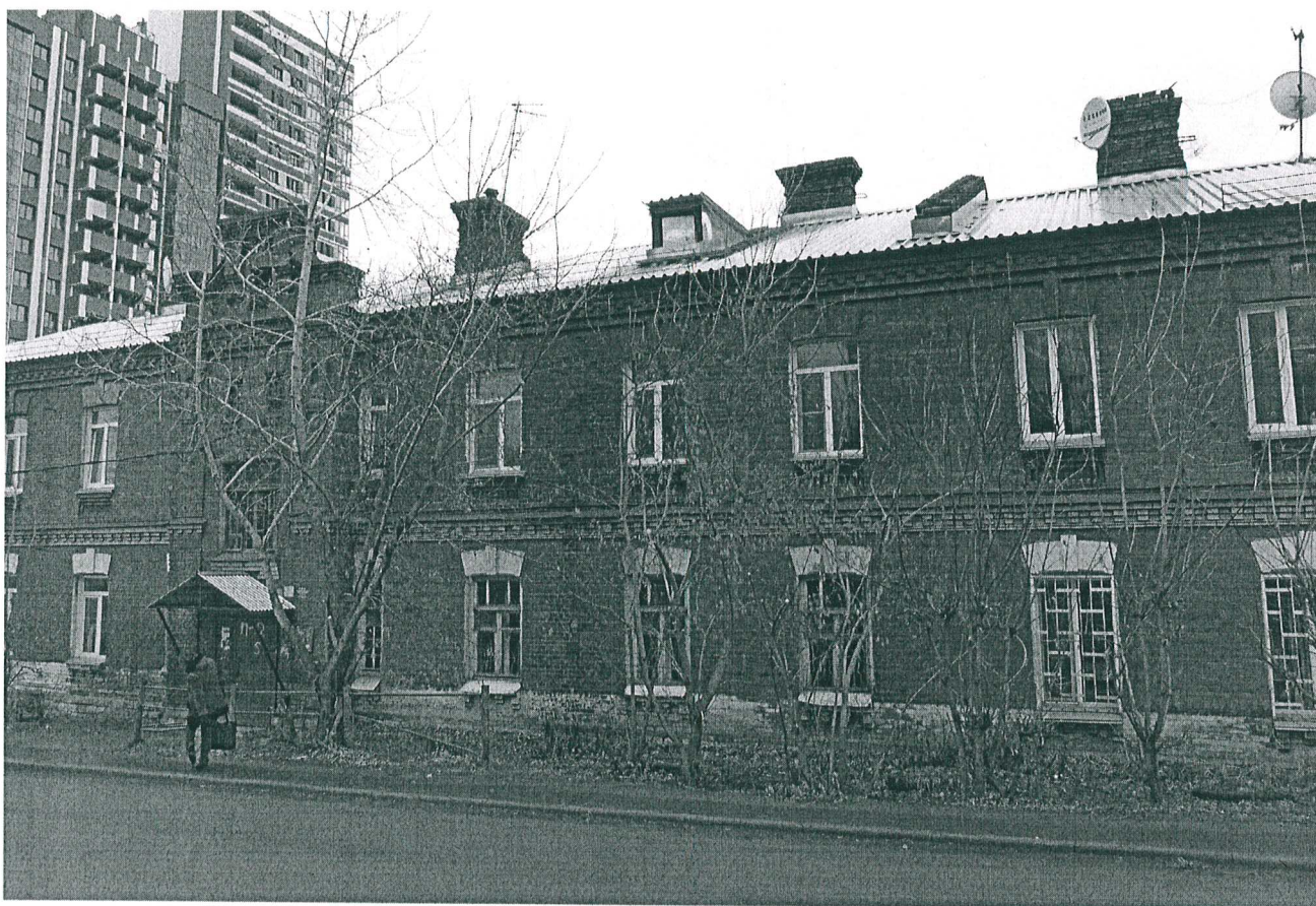
4. Фрагмент центральной части главного фасада. Поздние наслоения: окна из профиля ПВХ; покрытие и ограждение кровли; спутниковые антенны.
