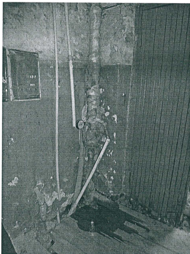
24. Фрагмент лестничной клетки (подьезд № 1).
