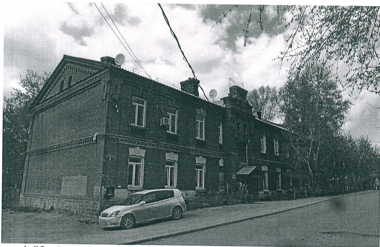
1. Общий вид здания с юга.
