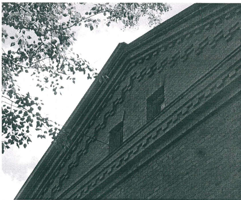
17. Фрагмент торцевого (северо-восточного) фасада. Предмет охраны – кирпичный декор.
