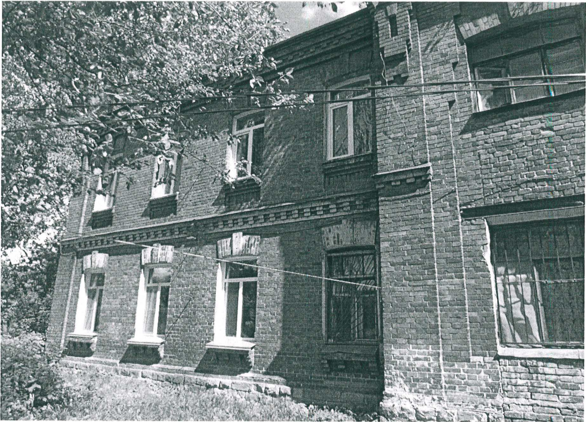
9. Фрагмент дворового фасада (северное крыло). Поздние наслоения: окна из профиля ПВХ и дерева. Предмет охраны – кирпичный декор, деревянное окно (1 этаж)
