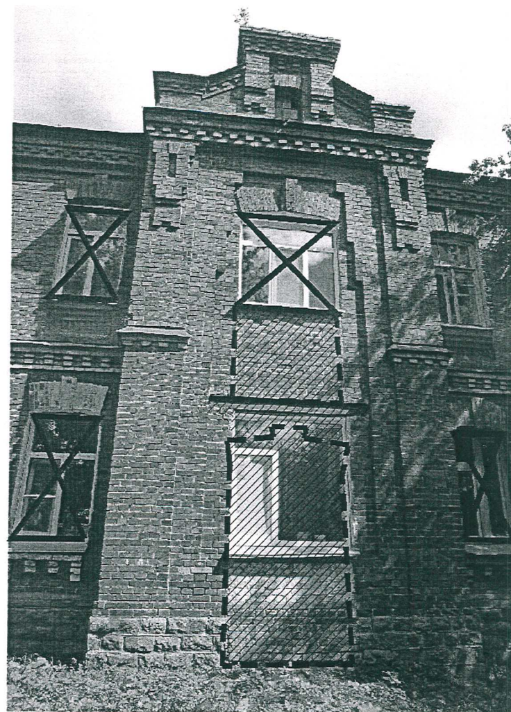
Южный ризалит дворового фасада.
