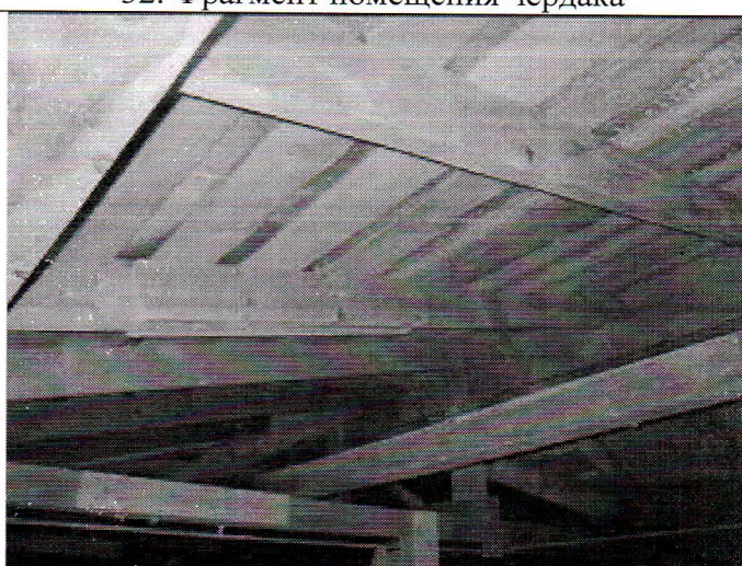
32. Фрагмент помещения чердака
