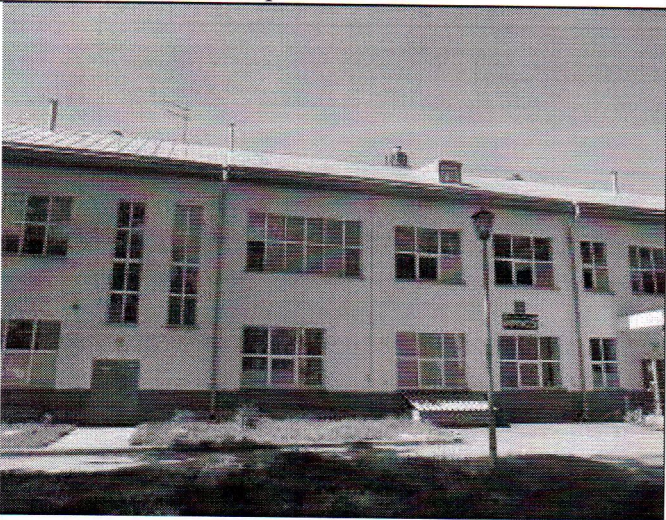
5. Фрагмент юго-восточного фасада, центральная часть
