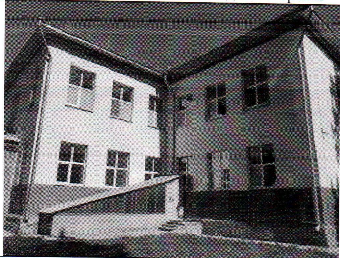
19. Южный объем, вид с западной стороны
