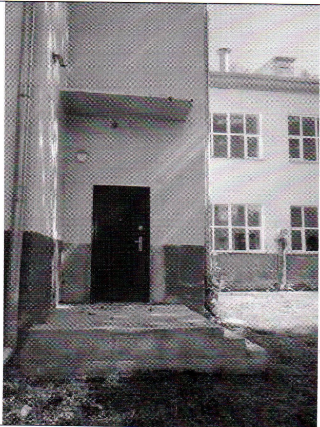
27. Входной узел в центральный выступающий объем
