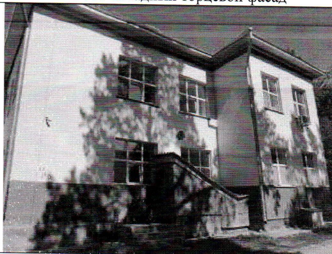
20. Юго-западный торцевой фасад
