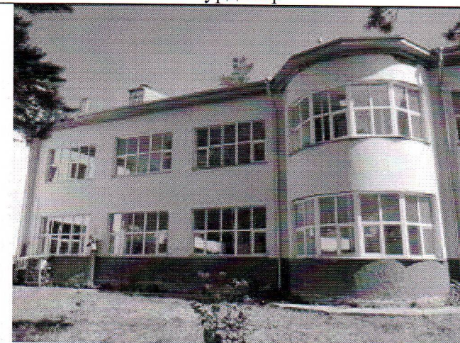
15. Фрагмент северо-западного фасада, южный курдонер
