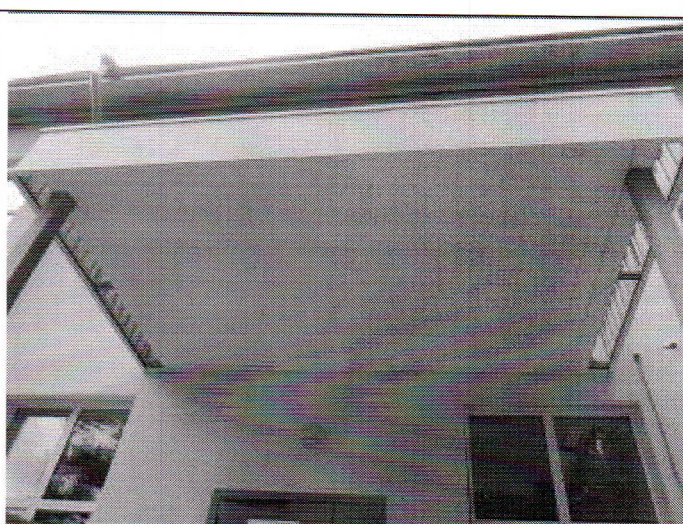
38. Навес на главном входе
