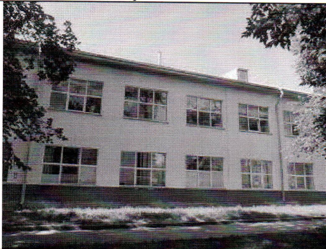
3. Фрагмент юго-восточного фасада, центральная часть
