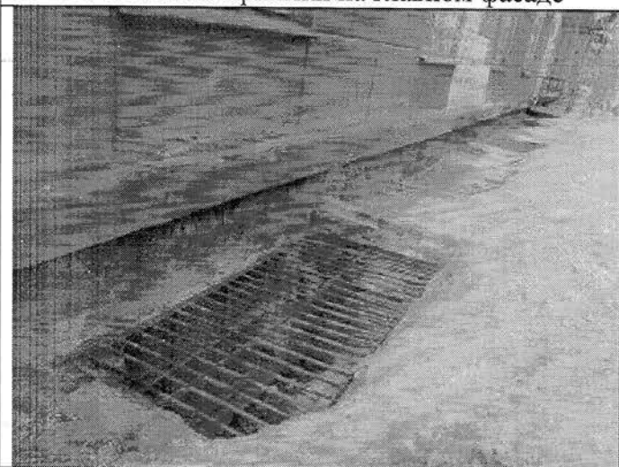
32. Световые приямки на главном фасаде
