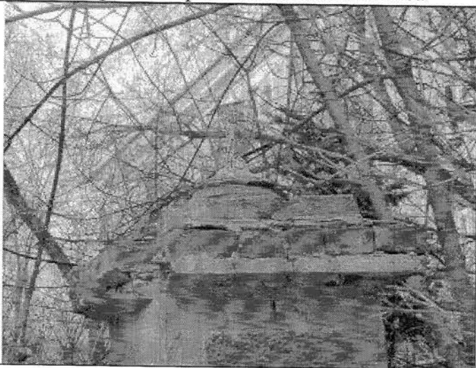
49. Дефекты отделки карниза на главном фасаде
