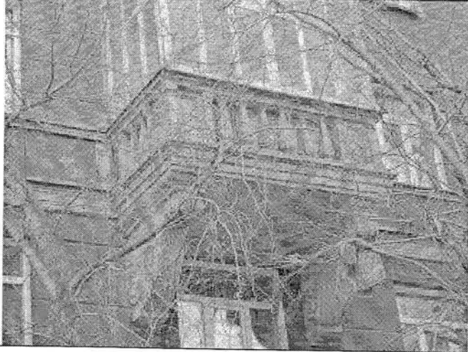
24. Балкон на южном фасаде, 3 этаж
