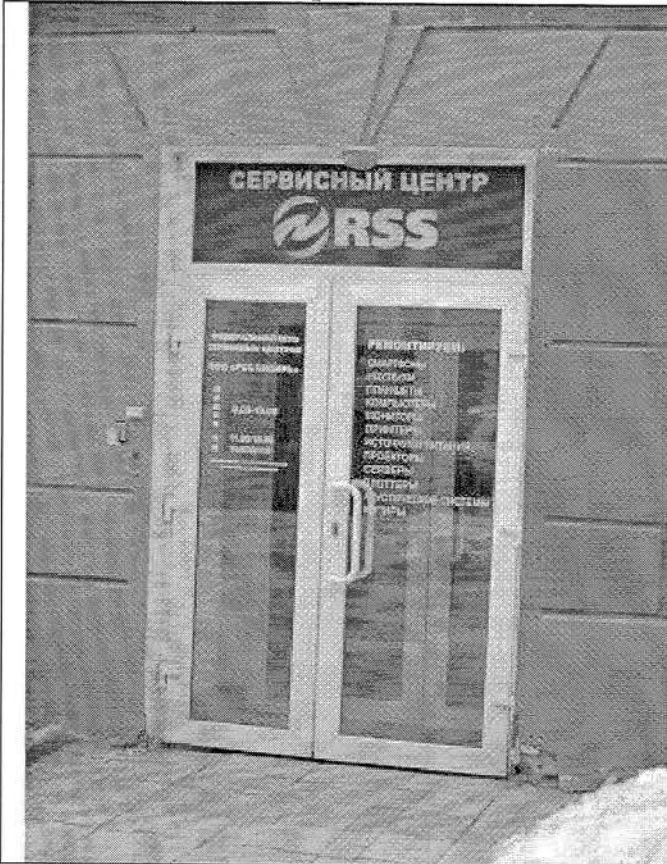
20. Современный входной узел на главном фасаде
