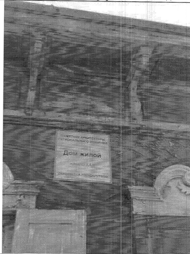
14. Дефекты декоративного оформления обшивки, наличников, карниза.
