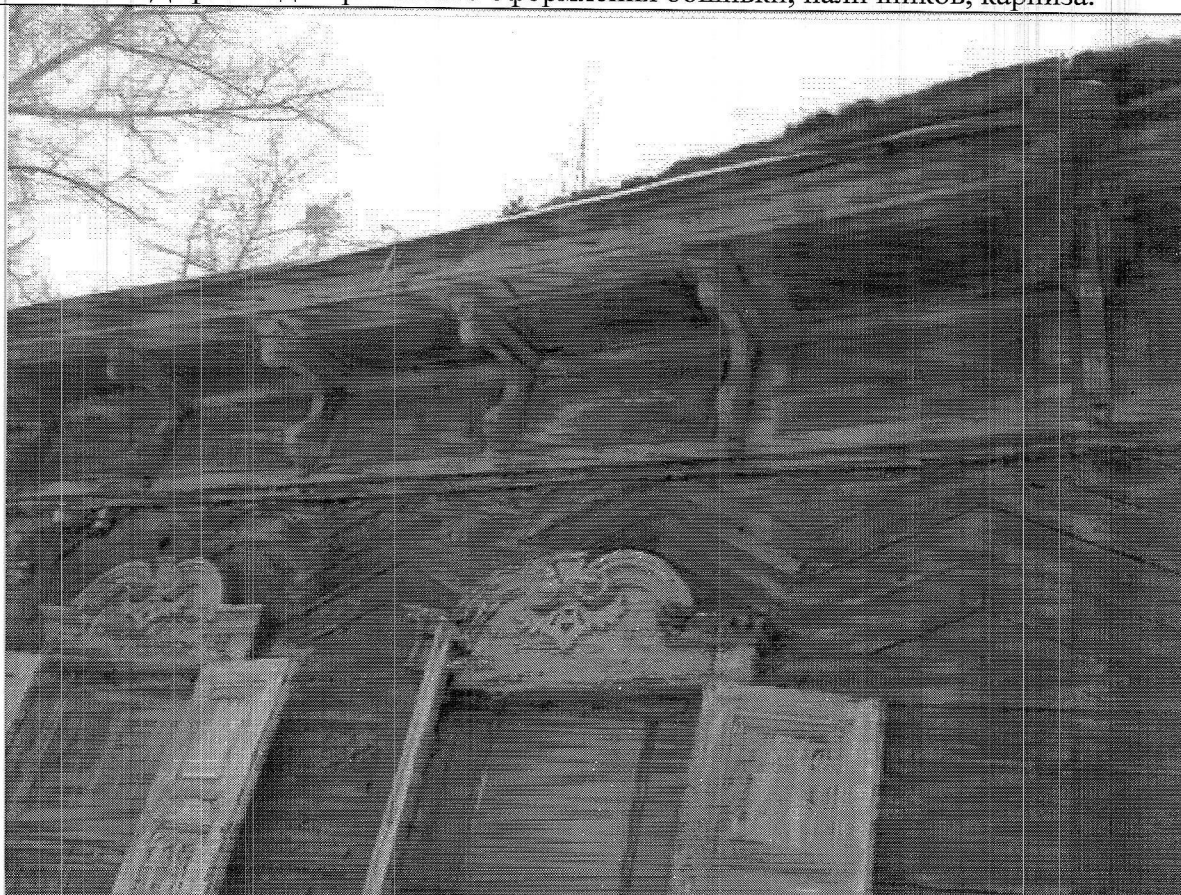
14. Дефекты декоративного оформления обшивки, наличников, карниза.
