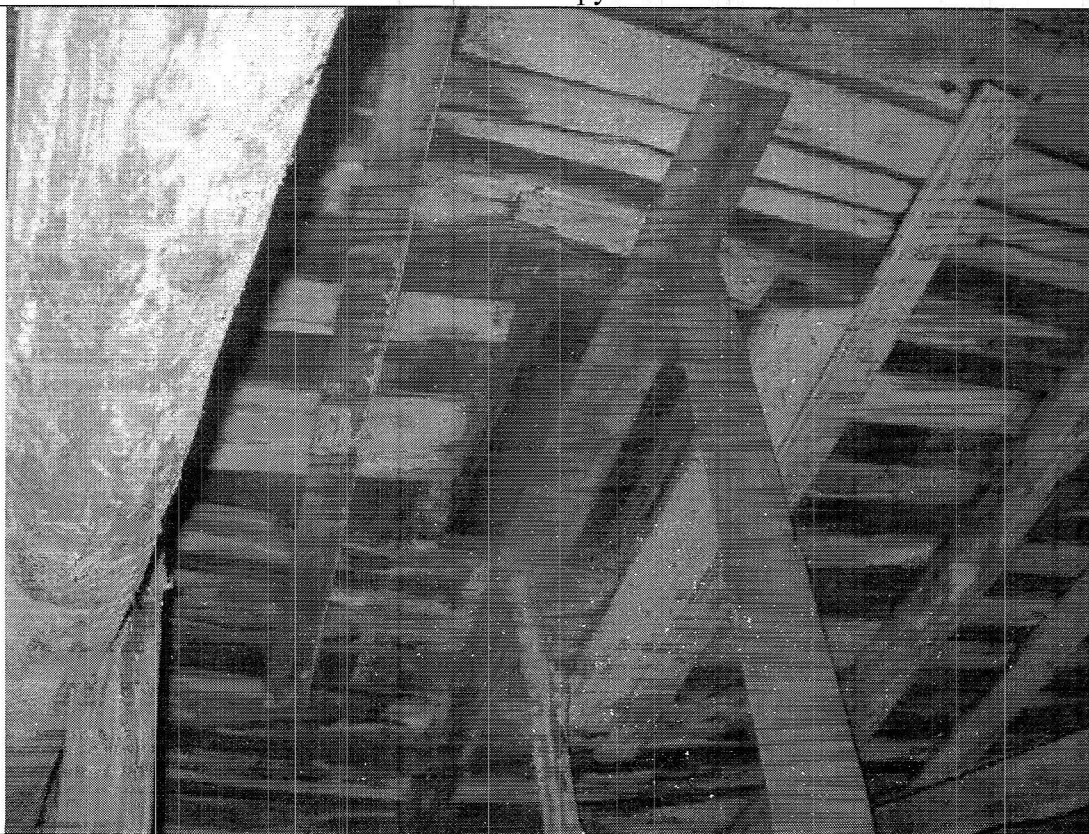
26. Участок северо-восточного ската крыши, подвергавшийся ремонту, после демонтажа печной трубы.
