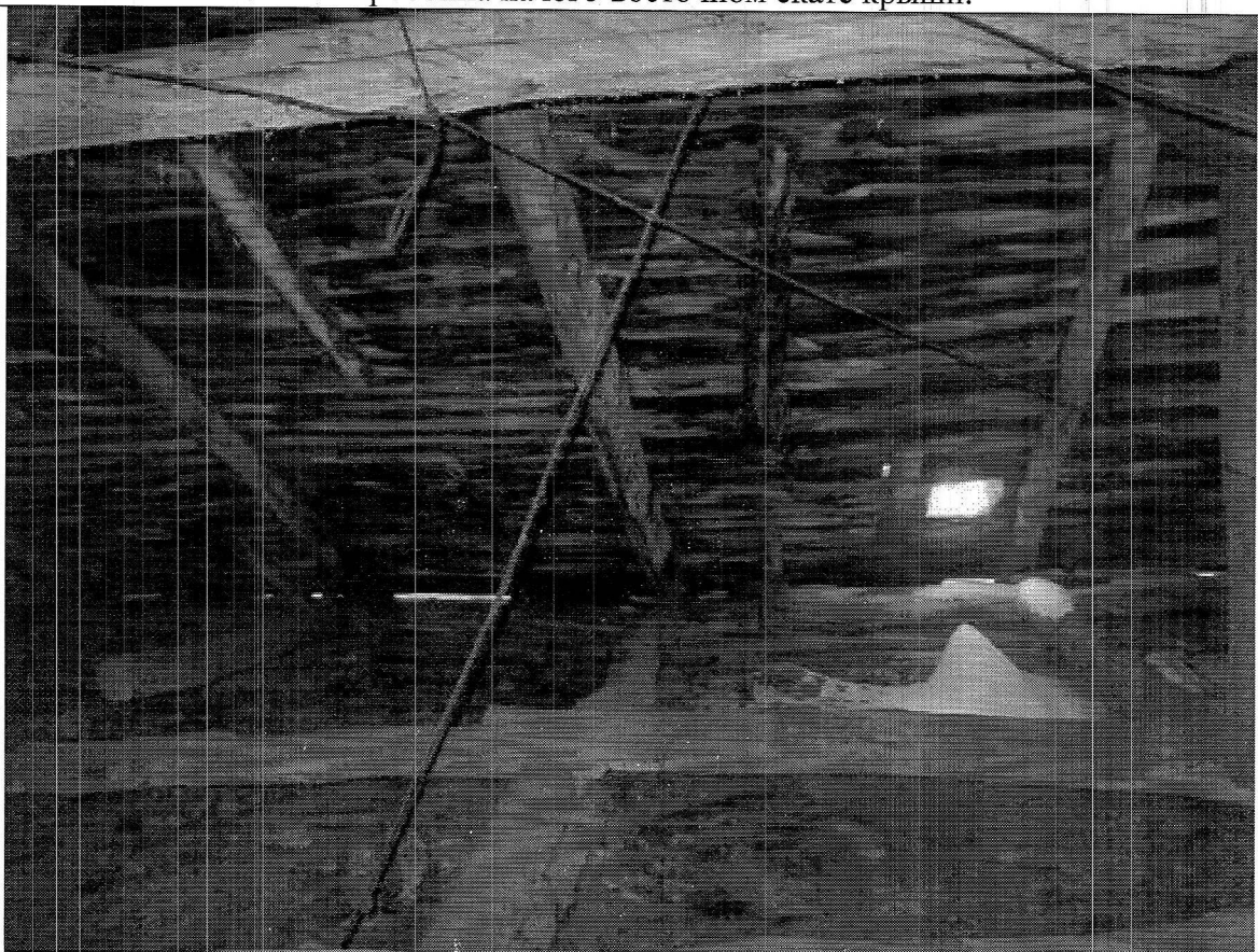
28. Пробоина на юго-восточном скате крыши.
