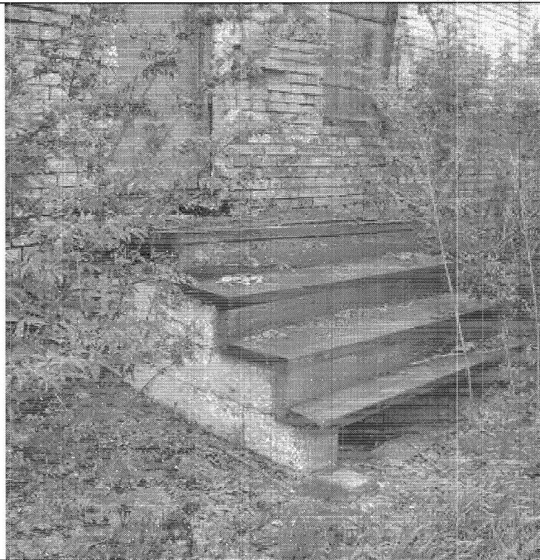
16. Крыльцо на юго-восточном фасаде. Фото май 2018 года.
