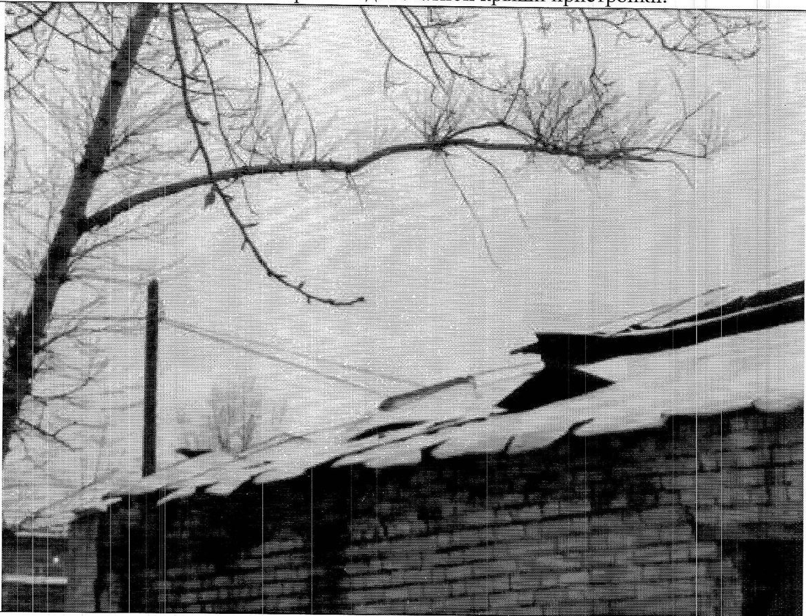
28. Пробоина на юго-восточном скате крыши.
