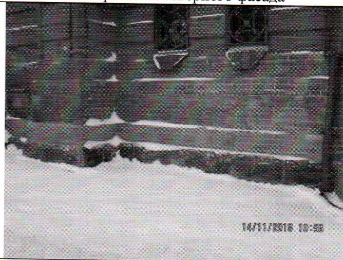
20. Фрагмент северного фасада
