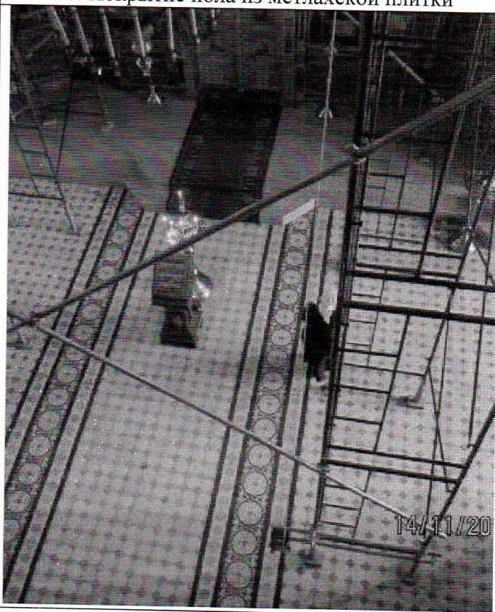
28. Покрытие пола из метлахской плитки
