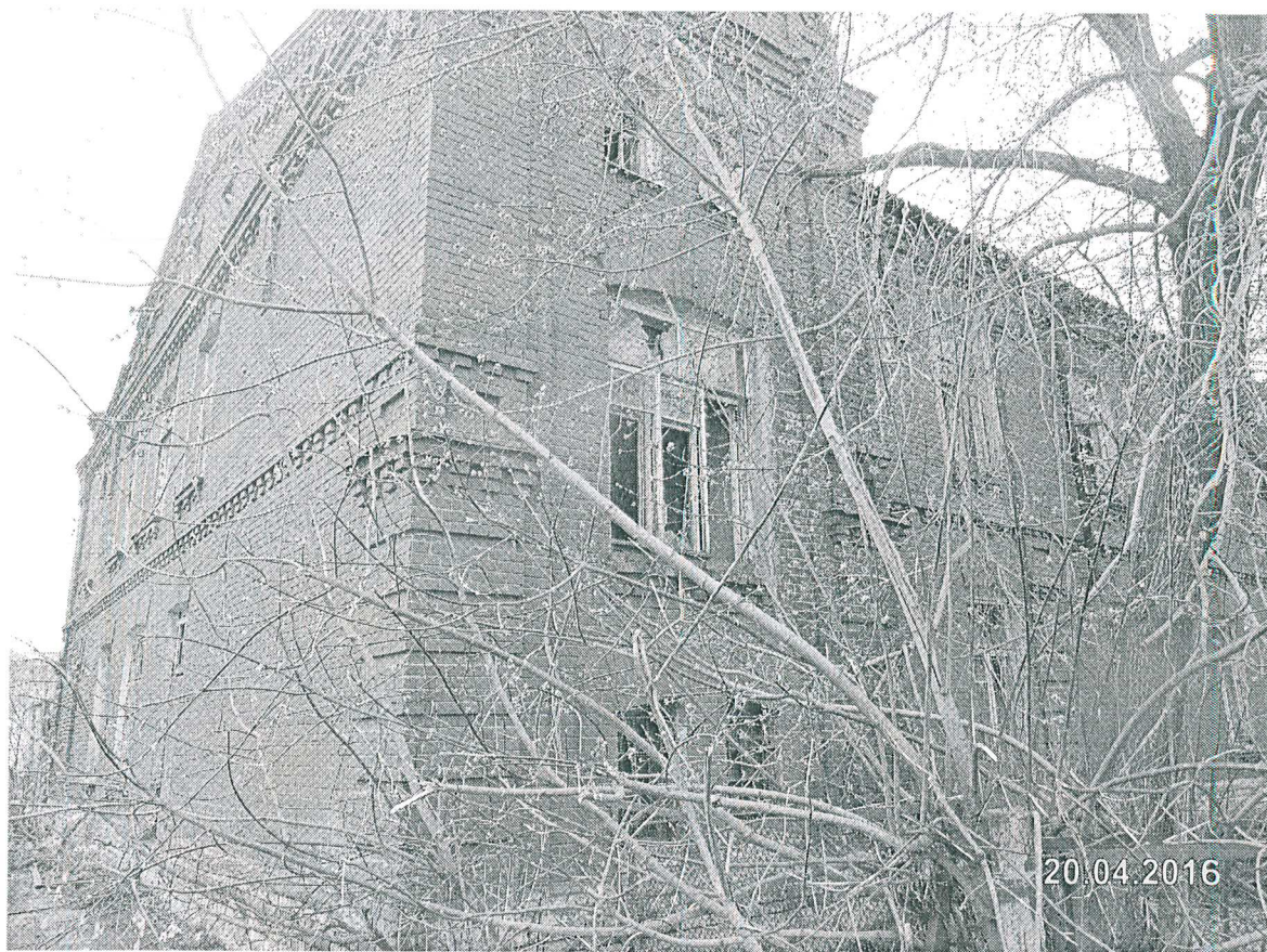
1. Левый ризалит северо-западного фасада.
