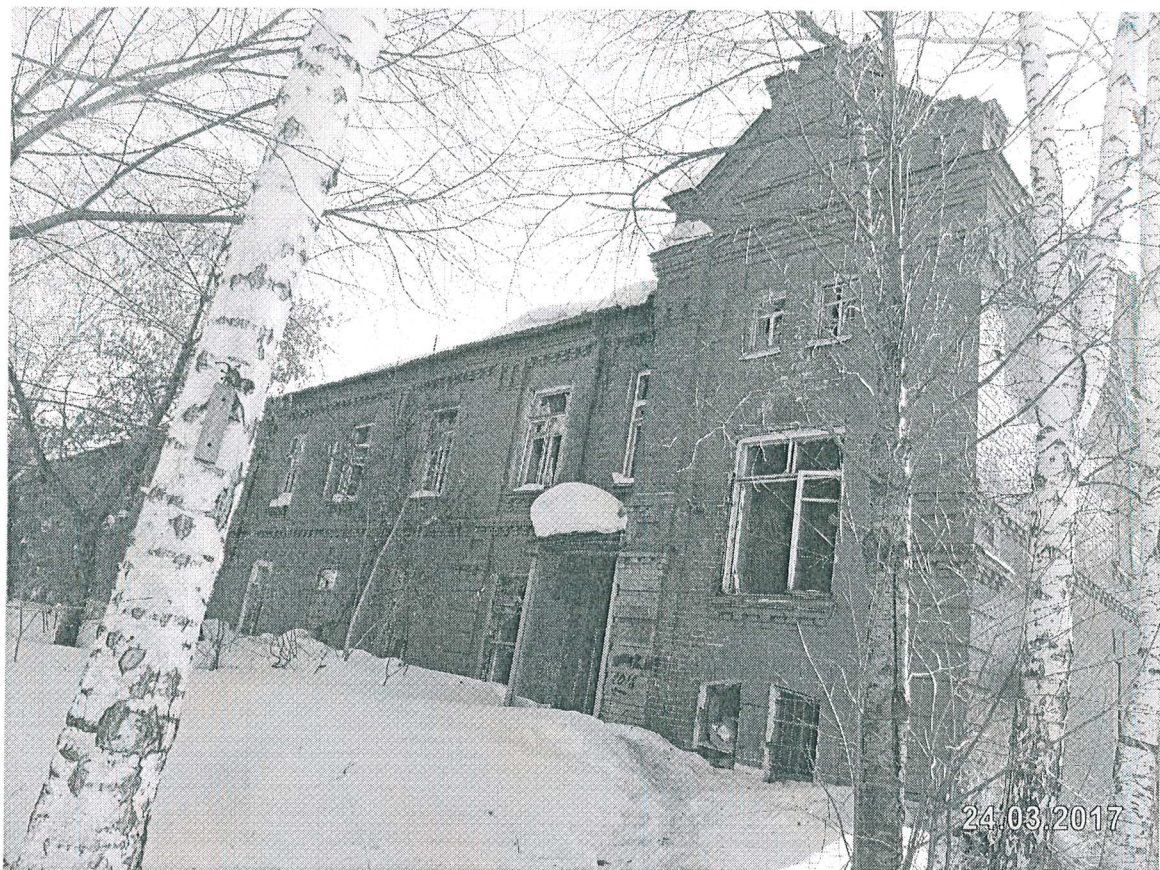
5. Правый ризалит северо-западного фасада.
