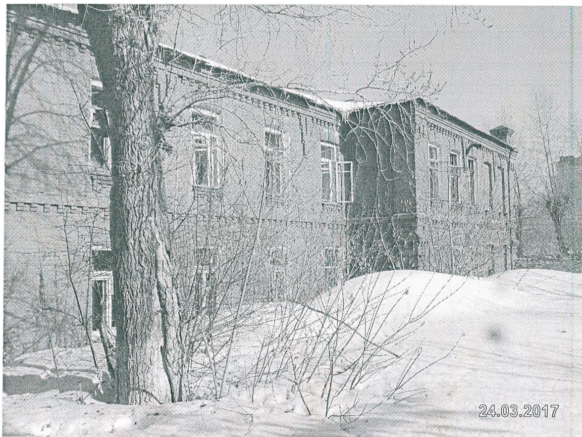
9. Правая часть юго-восточного фасада с видом на ризалит.
