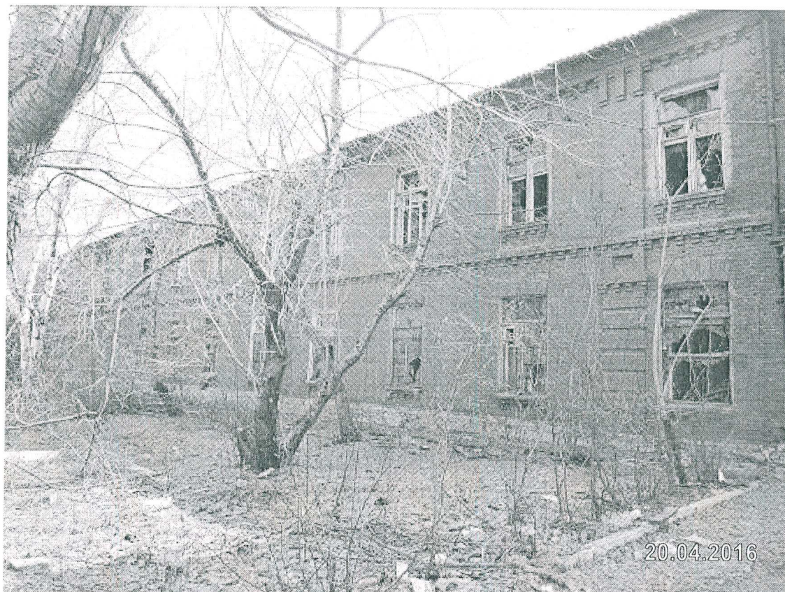
3. Средняя часть северо-западного фасада.
