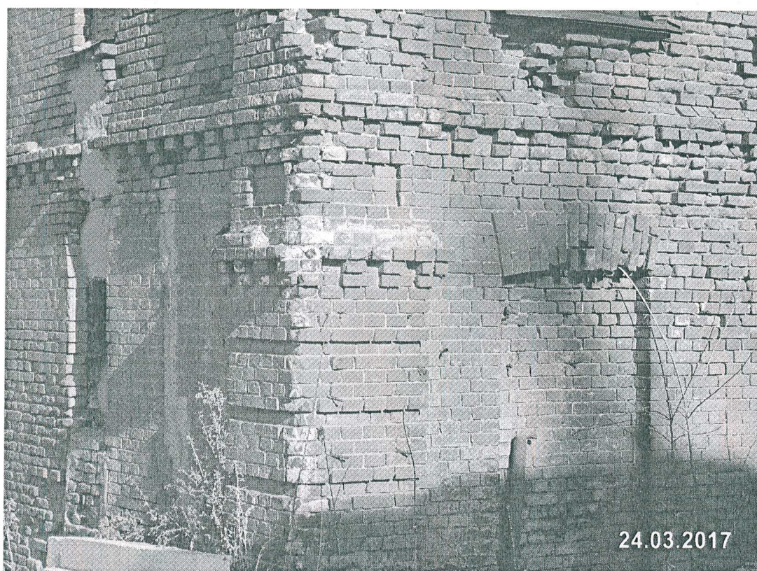
15. Состояние кирпичной кладки юго-западного и юго-восточного фасадов.
