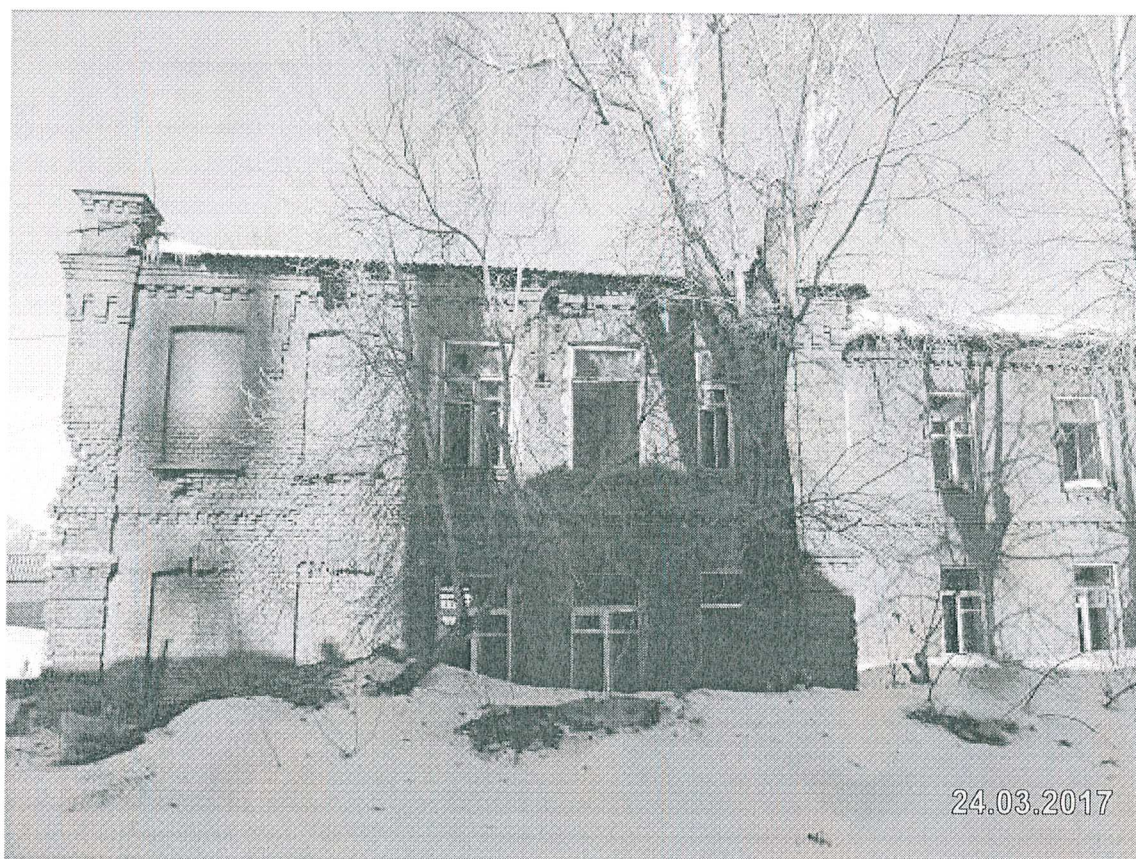
7. Левый ризалит юго-восточного фасада.
