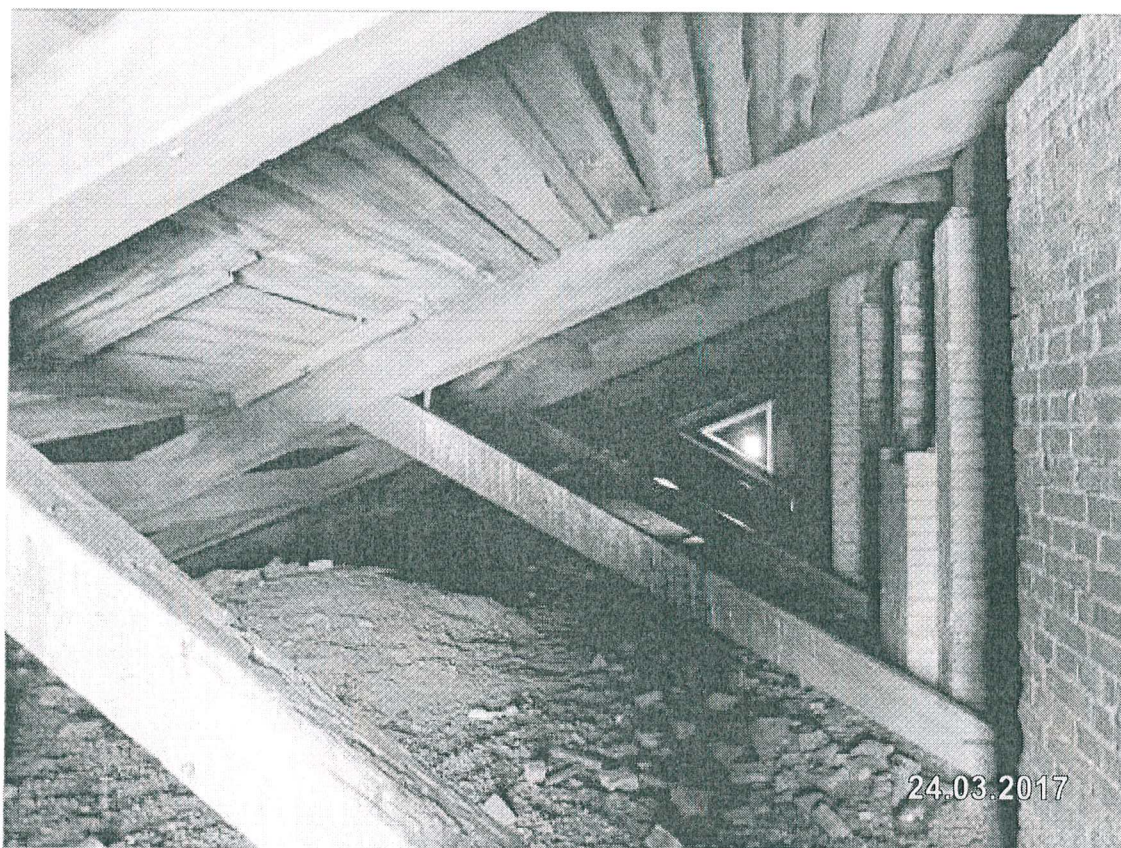
16. Помещение чердака: конструкции крыши, остатки печных труб.
