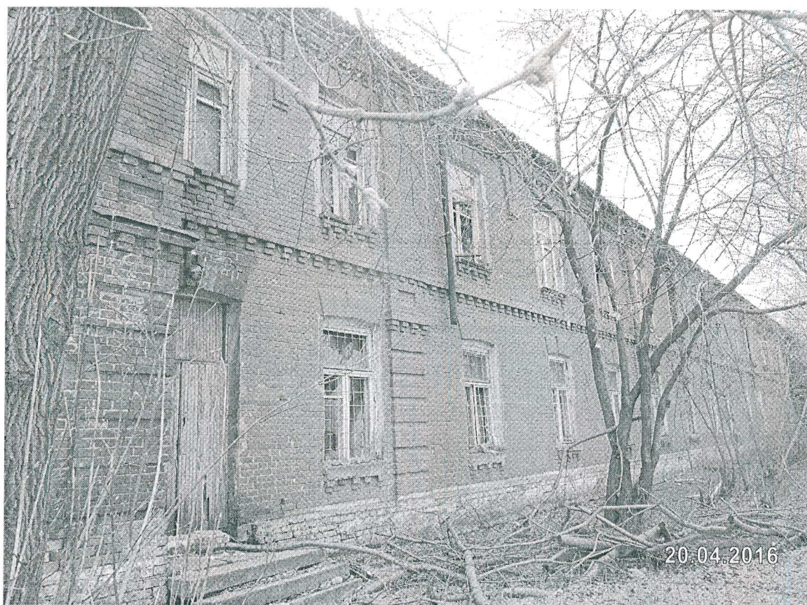
2. Средняя часть северо-западного фасада.
