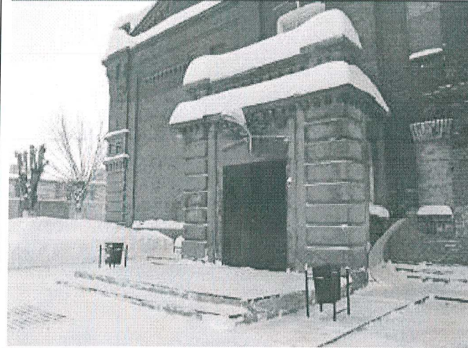
14. Входной узел на северо-восточном фасаде
