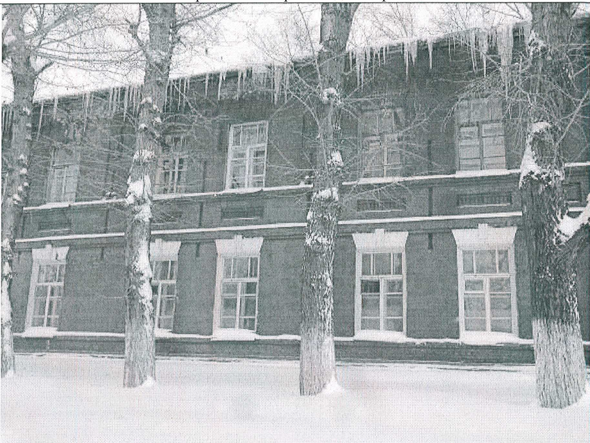
9. Фрагмент северо-западного фасада
