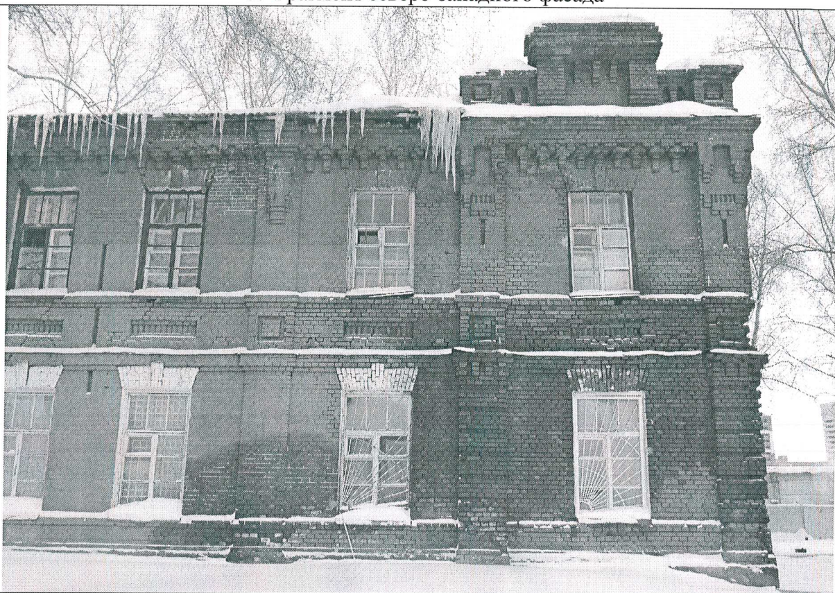
5. Фрагмент северо-западного фасада
