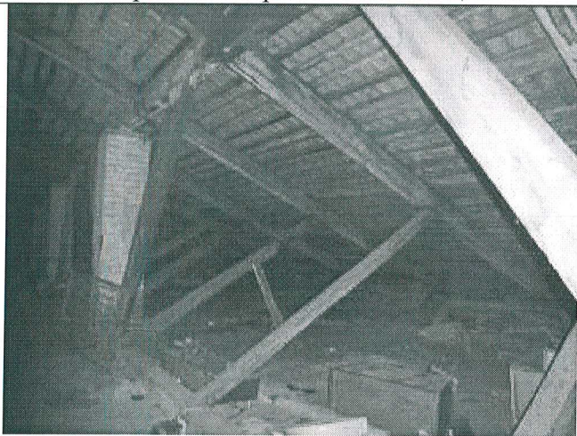
24. Фрагмент чердачного помещения
