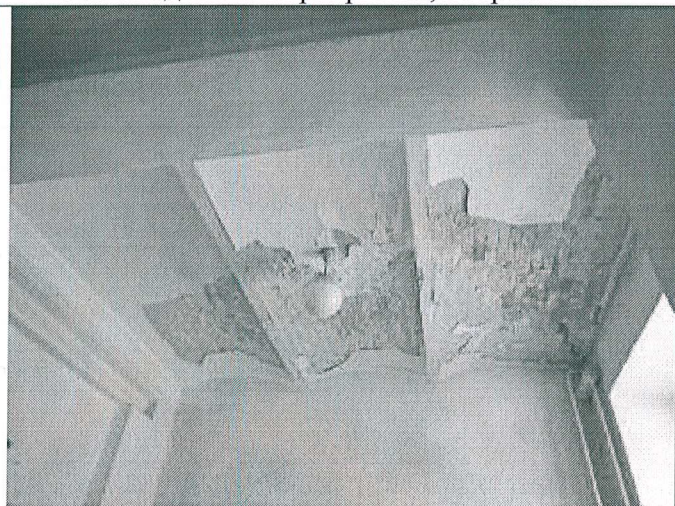
30. Сводчатые перекрытия, второй этаж
