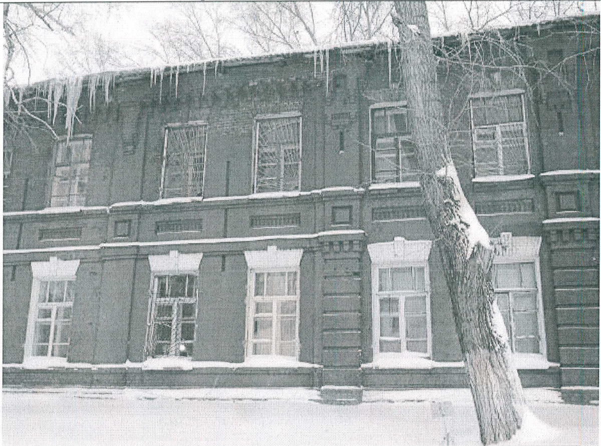
8. Фрагмент северо-западного фасада
