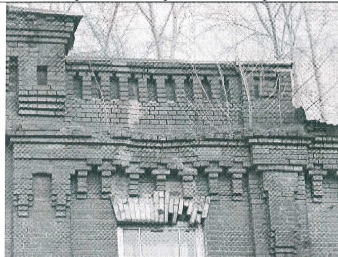
21. Фрагмент северо-западного фасада
