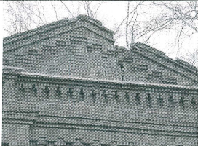
23. Фрагмент фронтона юго-западного фасада
