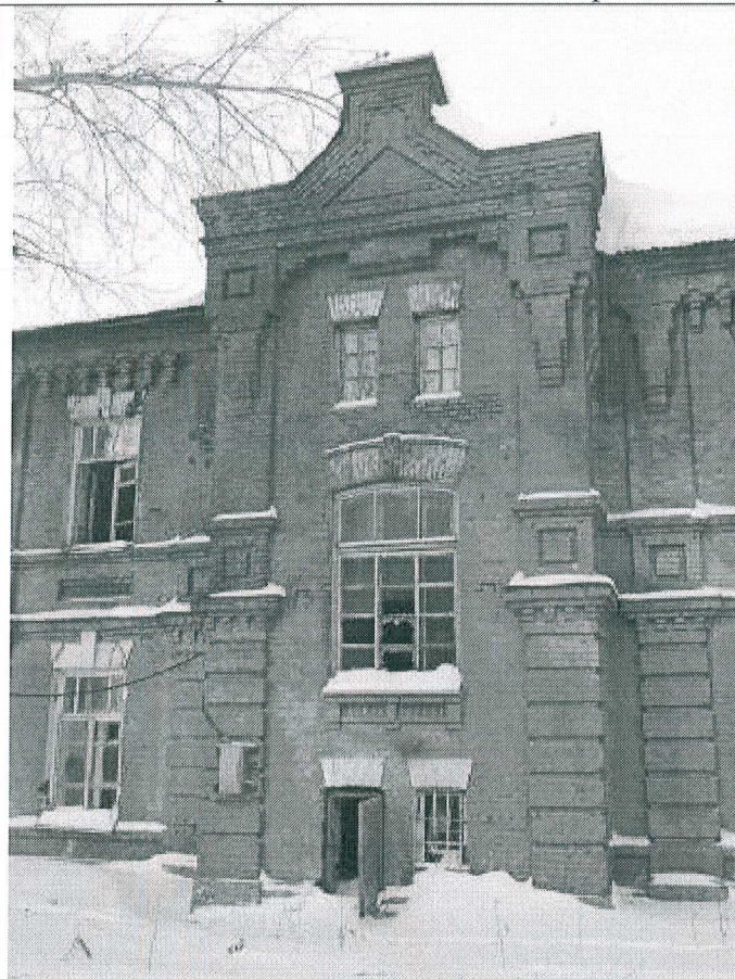
9. Южный ризалит юго-восточного фасада
