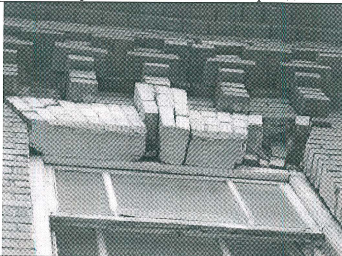
24. Фрагмент юго-восточного фасада
