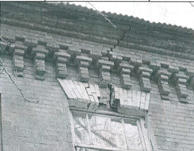
22. Фрагмент юго-восточного фасада
