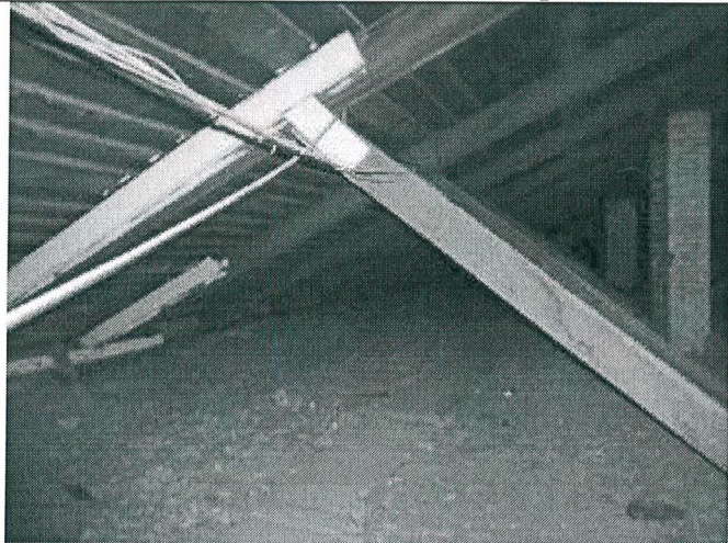
27. Фрагмент помещения чердака
