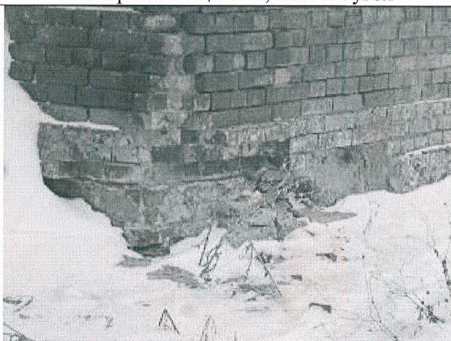
20. Фрагмент цоколя, южный угол
