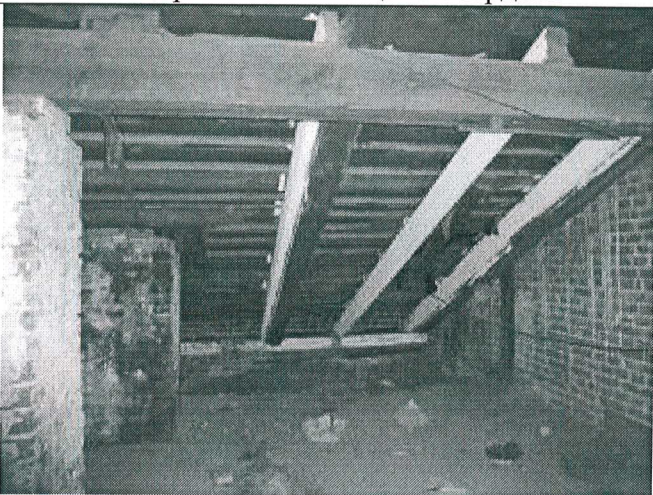
28. Фрагмент помещения чердака
