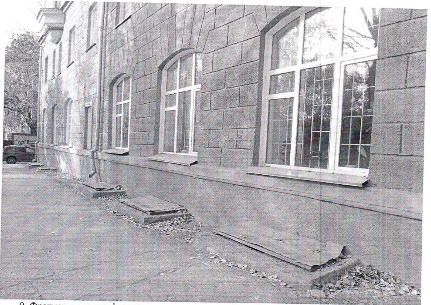
9. Фрагмент южного фасада.
