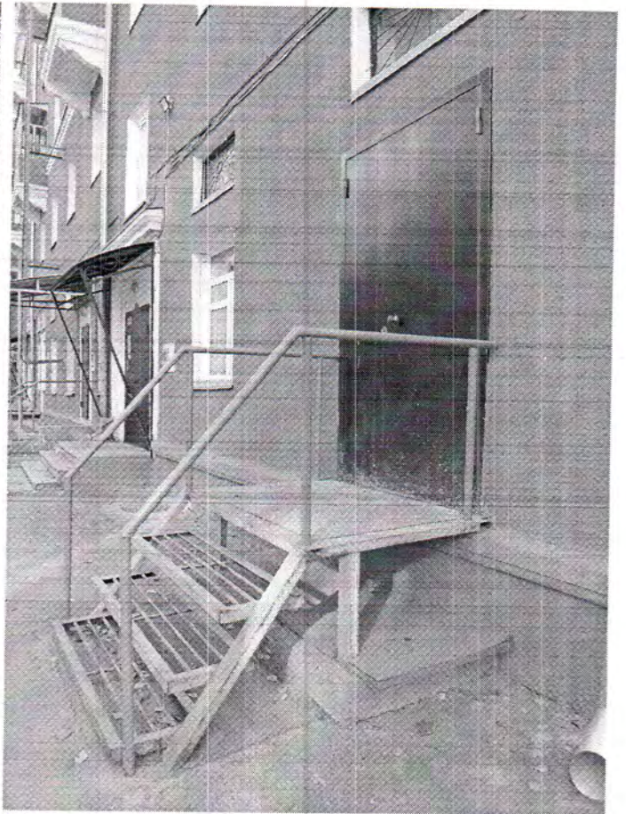
30. Вход на северном (дворовом) фасаде на месте первоначального окна.
