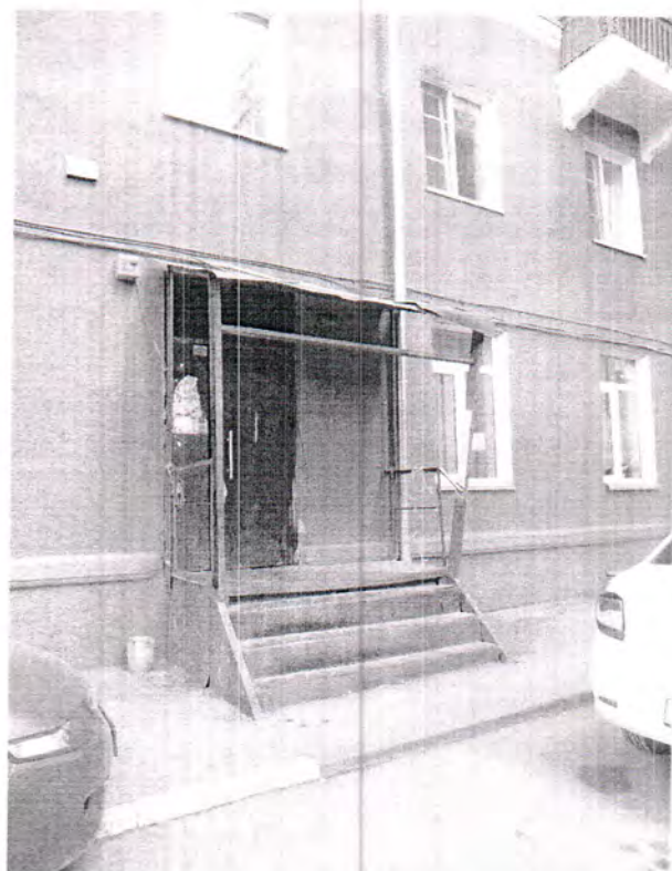
26. Вход на западном (дворовом) фасаде на месте первоначального окна.
