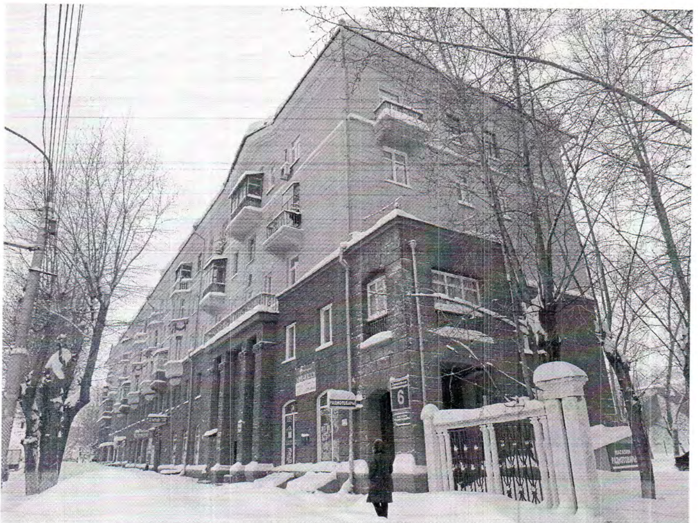
2. Общий вид фасадов с северо-востока.
