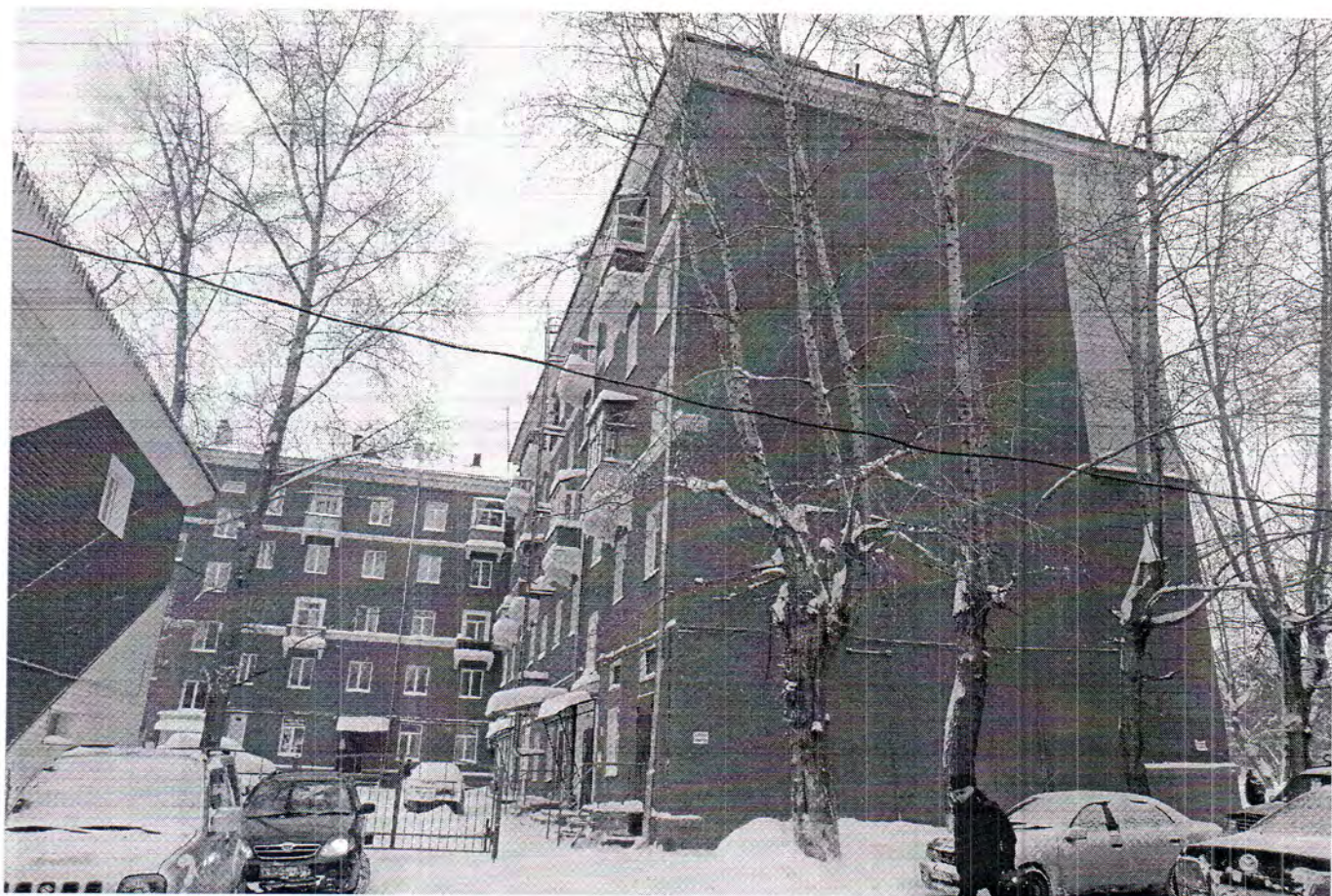
6. Вид части здания с запада.
