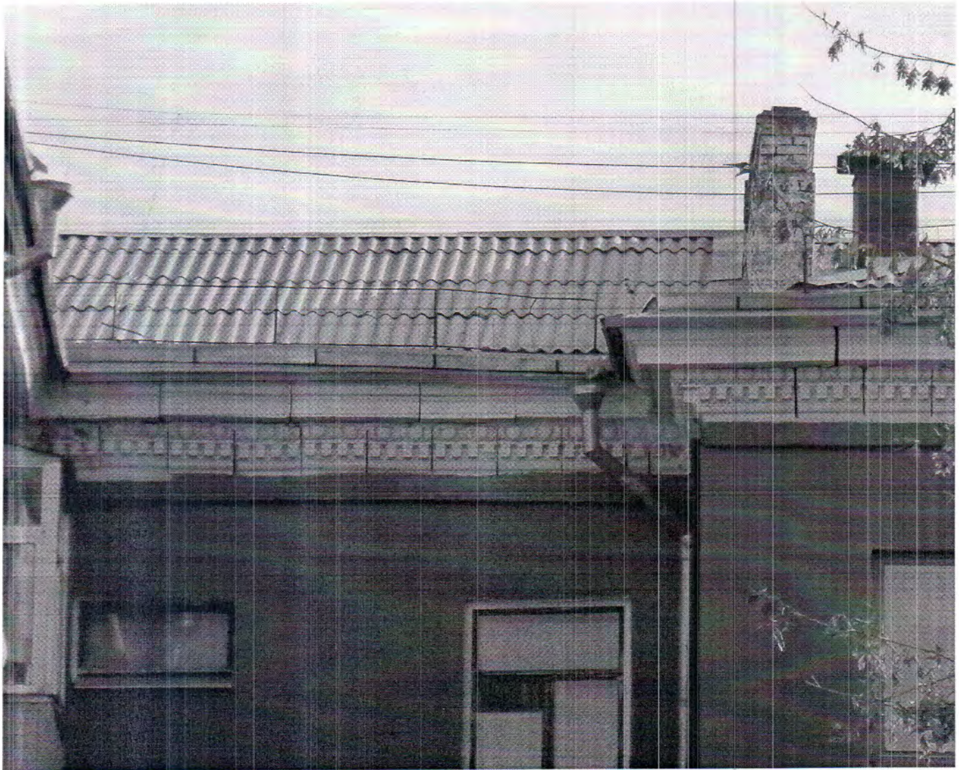
37. Фрагмент крыши северного (дворового) фасада.
