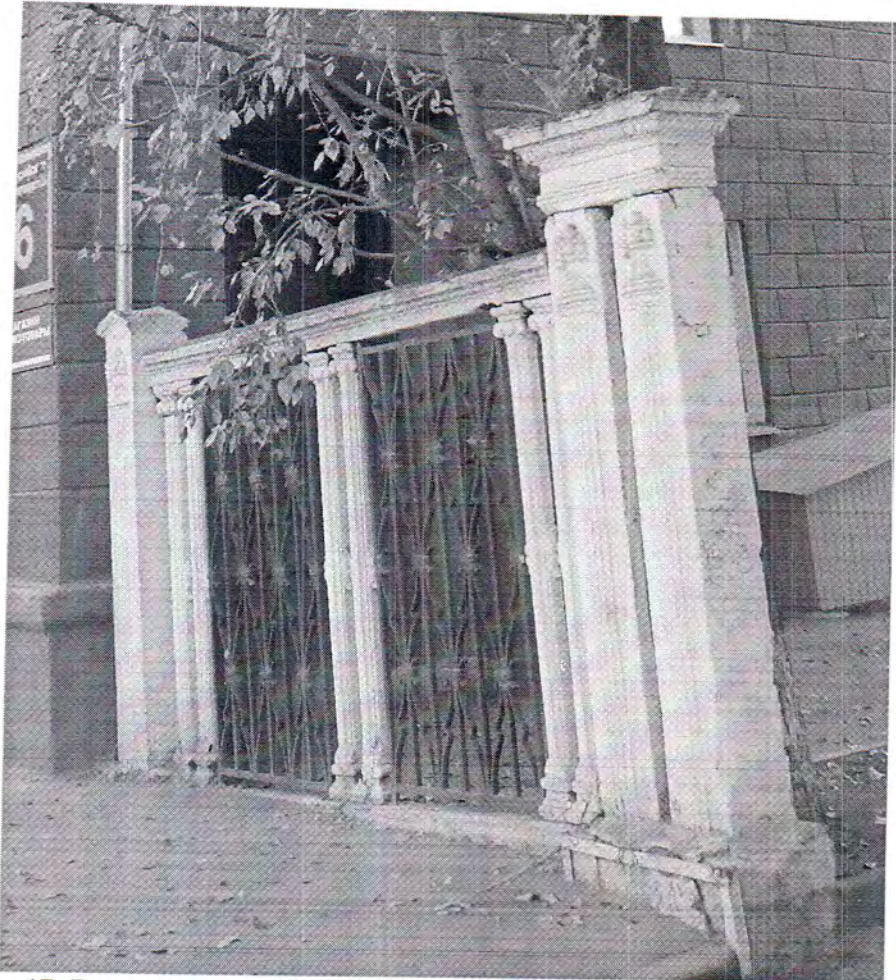
47. Вид ограждения с ул. Станиславского.
