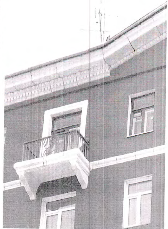
34. Окна, балконная дверь западного фасада: предмет охраны – рисунок переплетов.
