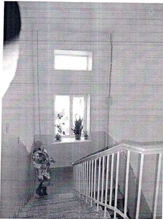
43. Фрагмент лестницы (подъезд № 2).
