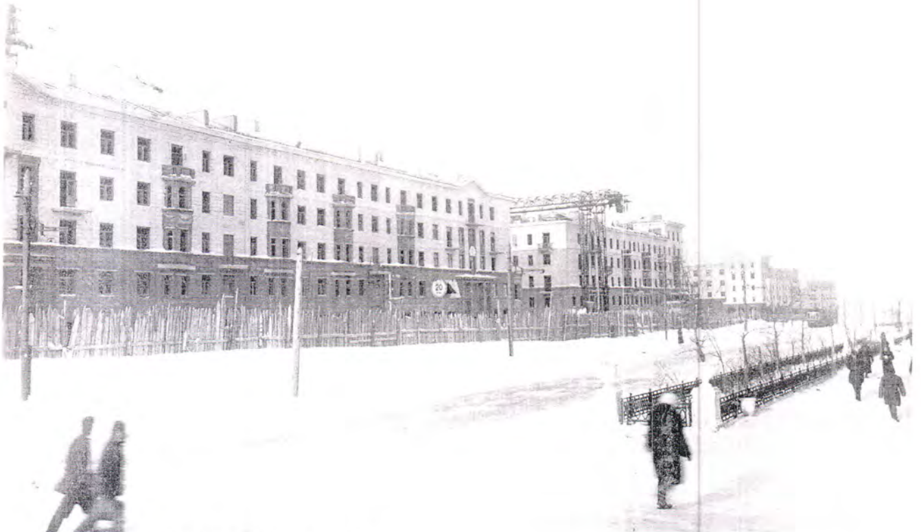
51. Завершающий этап строительства.
