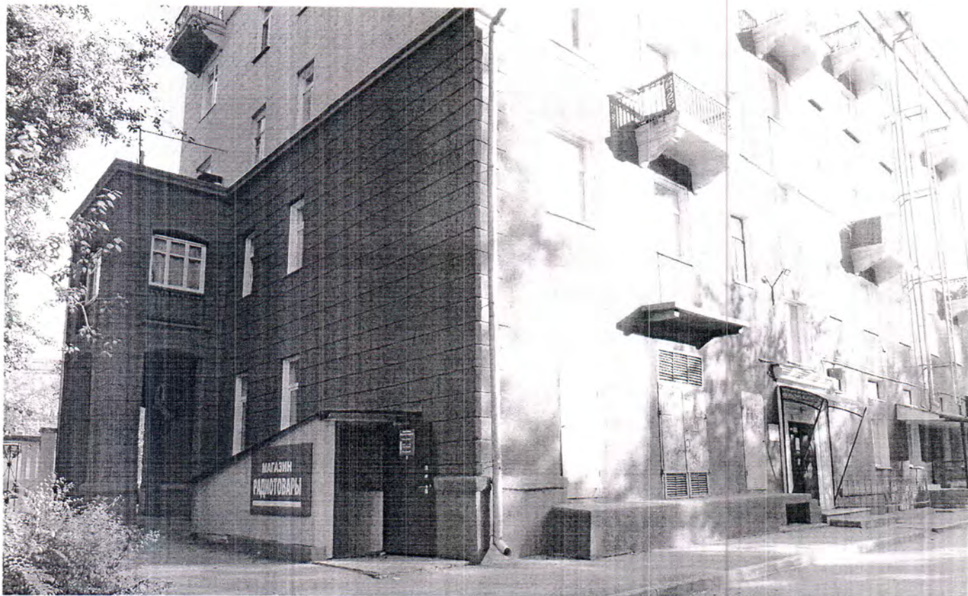
19. Фрагмент северного (торцевого) и западного (дворового) фасадов.
