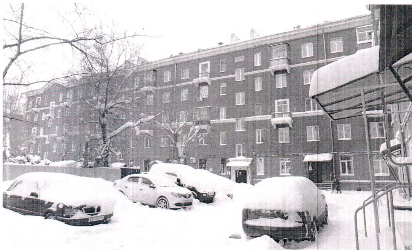
4. Общий вид западного (дворового) фасада.
