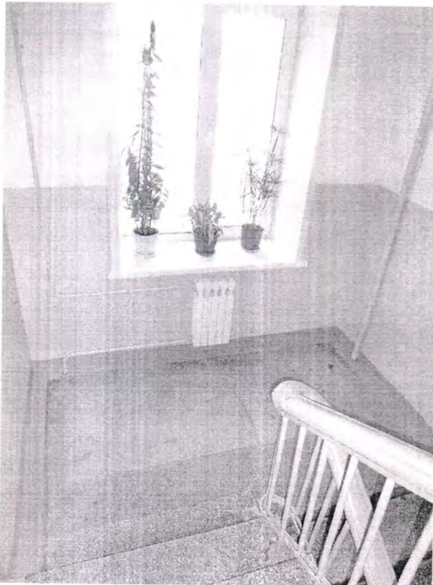
39. Междуэтажная площадка (подъезд № 2) после ремонта.
