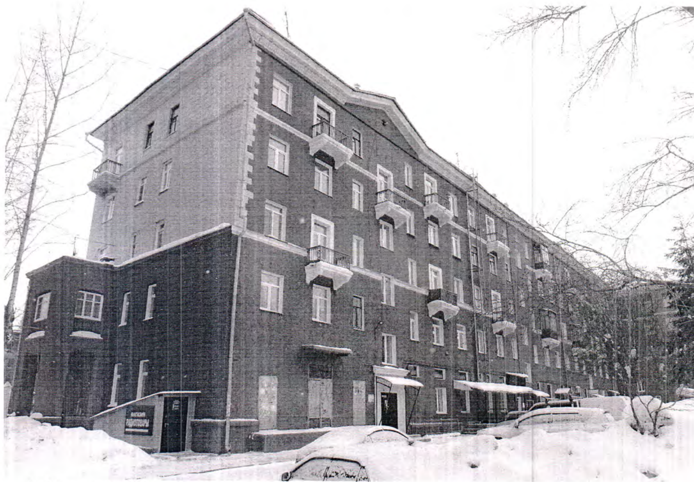
3. Общий вид фасадов с северо-запада.
