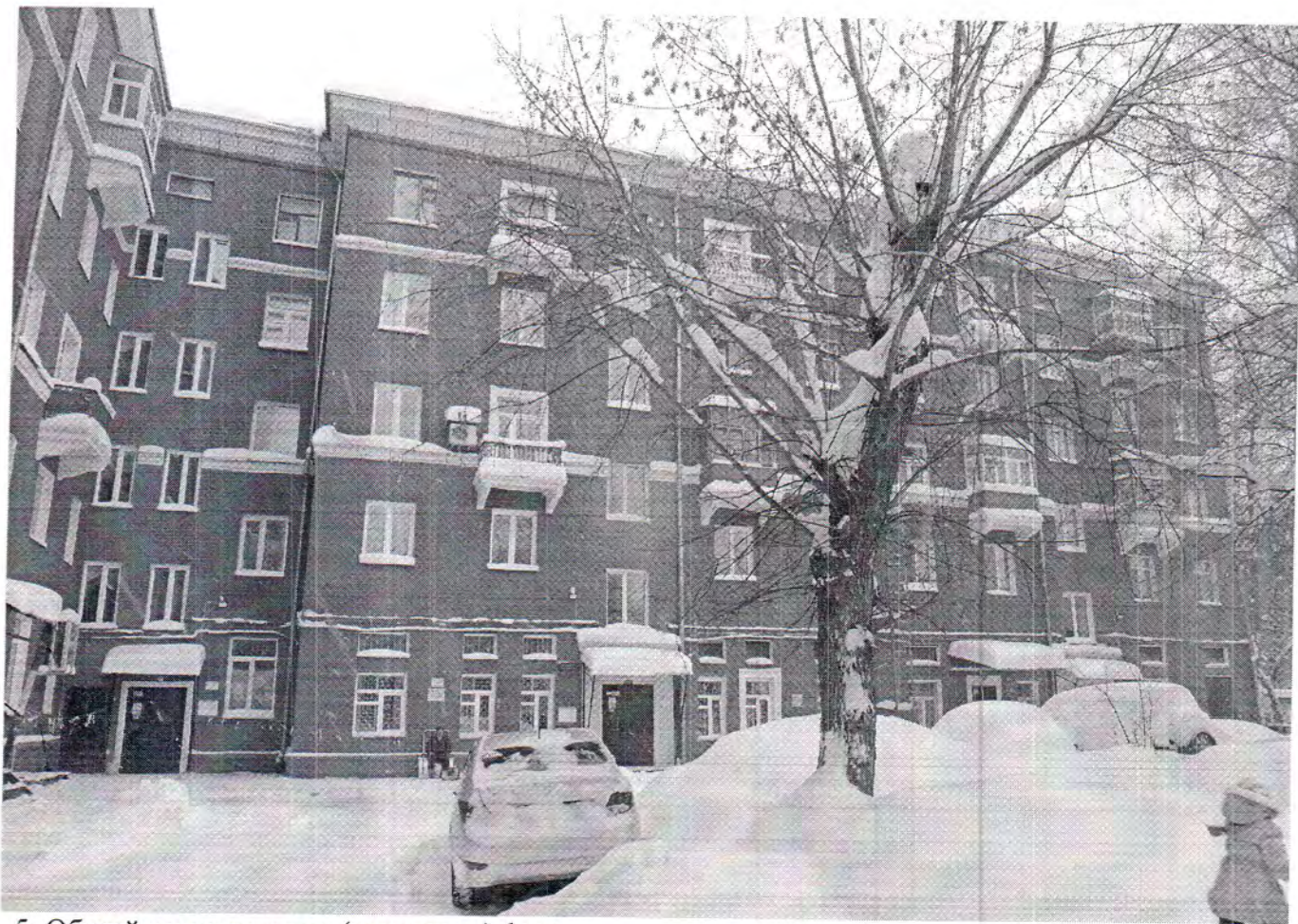
5. Общий вид северного (дворового) фасада.
