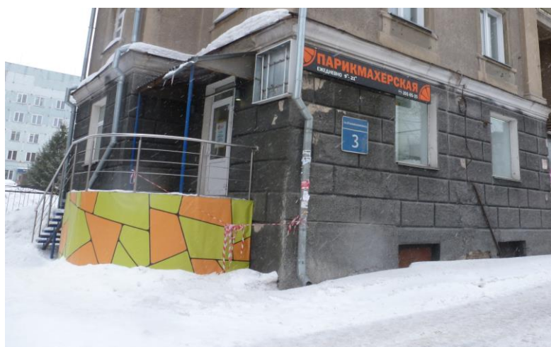
Северное крыло: северный и западный (главные) фасады. Согласовано 23.04.2001 г. (арх. № 84)
