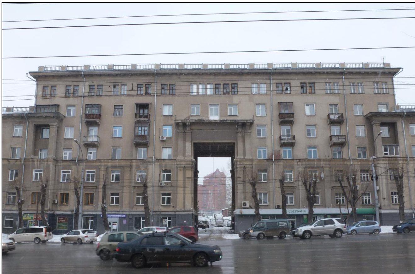
4.6. Западный (главный) фасад. Центральный объем.
