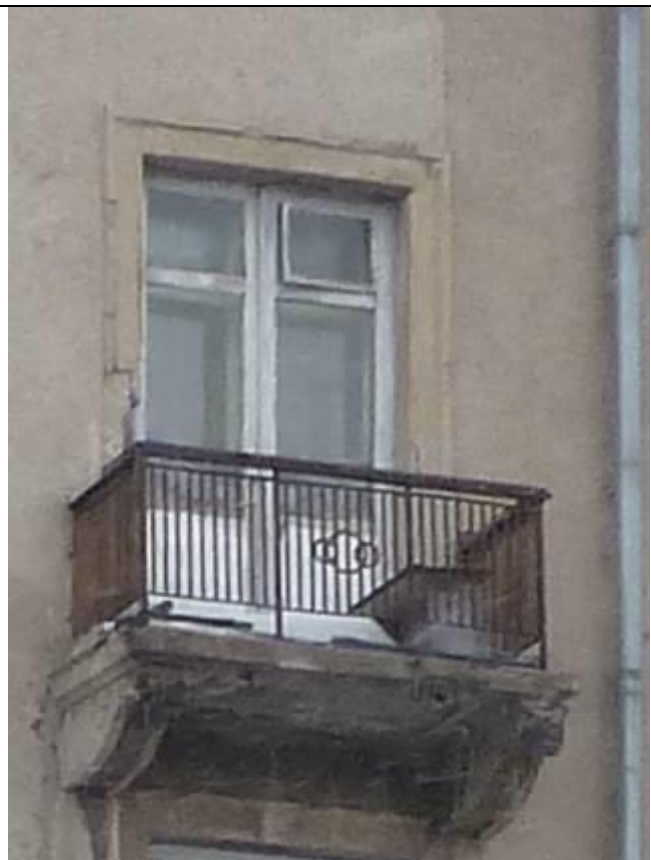
4.30. Фрагмент главного (западного) фасада. Первоначальное ограждение и дверь балкона на 6-м этаже центрального объема.
