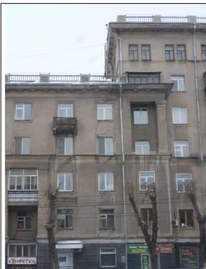
4.2. Фрагмент западного (главного) фасада. Северное крыло.
