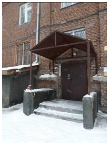
4.20. Южное крыло. Вход в подъезд №2 на дворовом фасаде.
