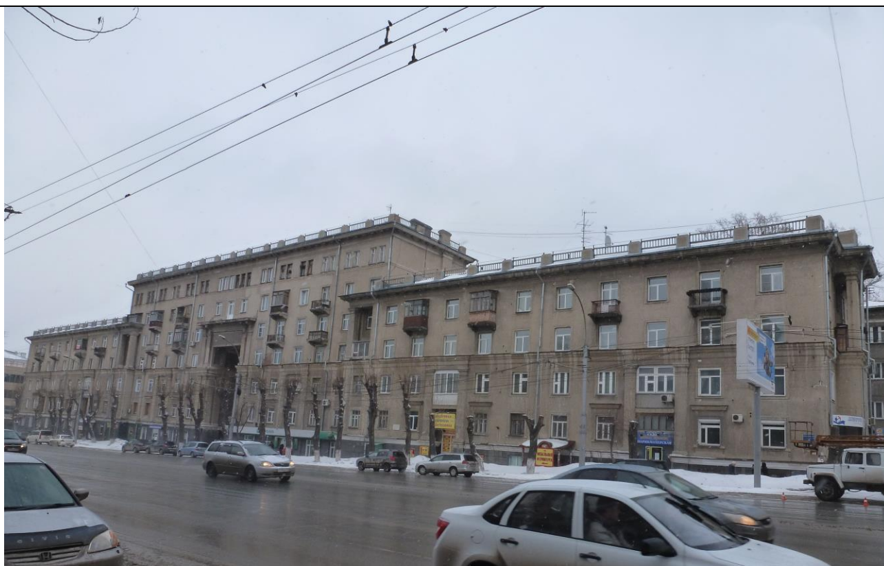
4.4. Общий вид главных фасадов здания (западного и южного).
