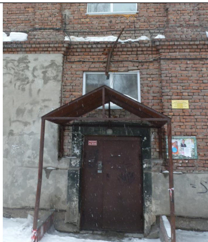
4.17. Северное крыло. Вход в подъезд № 5 на дворовом фасаде.
