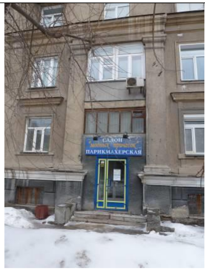
4.11. Фрагмент главного фасада. Южное крыло. Ниша парадного входа в подъезд № 1.
