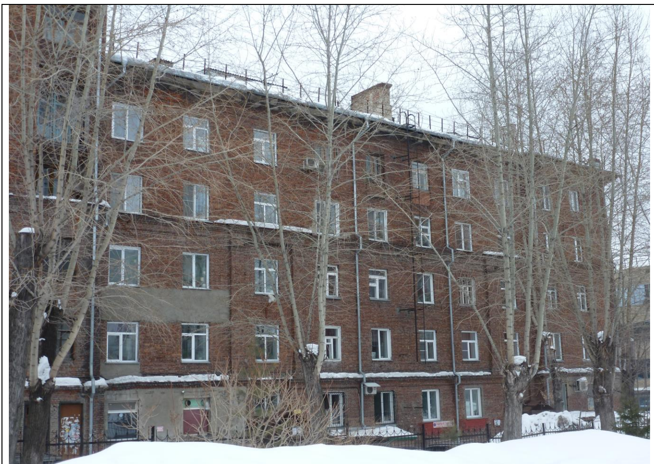
4.15. Дворовый (восточный) фасад. Общий вид северного крыла
