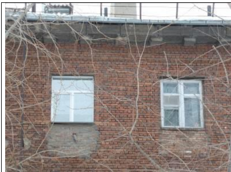
4.19. Южное крыло. Фрагмент дворового фасада в уровне 4-го этажа. Проемы утраченных «французских балконов».
