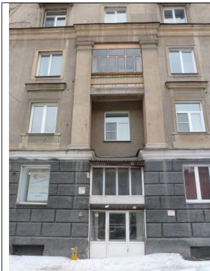
4.8. Фрагмент главного фасада. Северное крыло. Ниша парадного входа в подъезд № 6.
