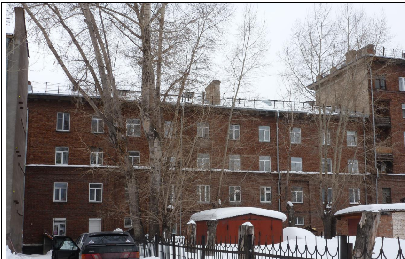
4.18. Дворовой (восточный) фасад. Общий вид южного крыла
