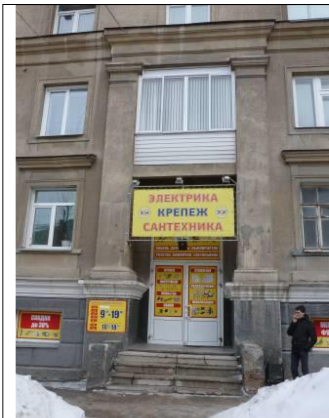
4.10. Фрагмент главного фасада. Южное крыло. Ниша парадного входа в подъезд № 2.
