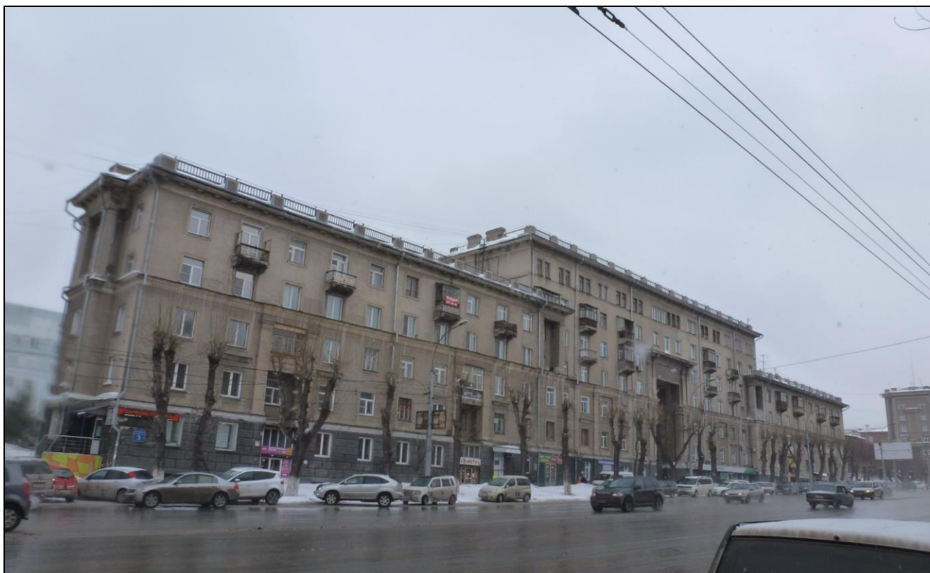
4.1. Общий вид главных фасадов здания (западного и северного).
