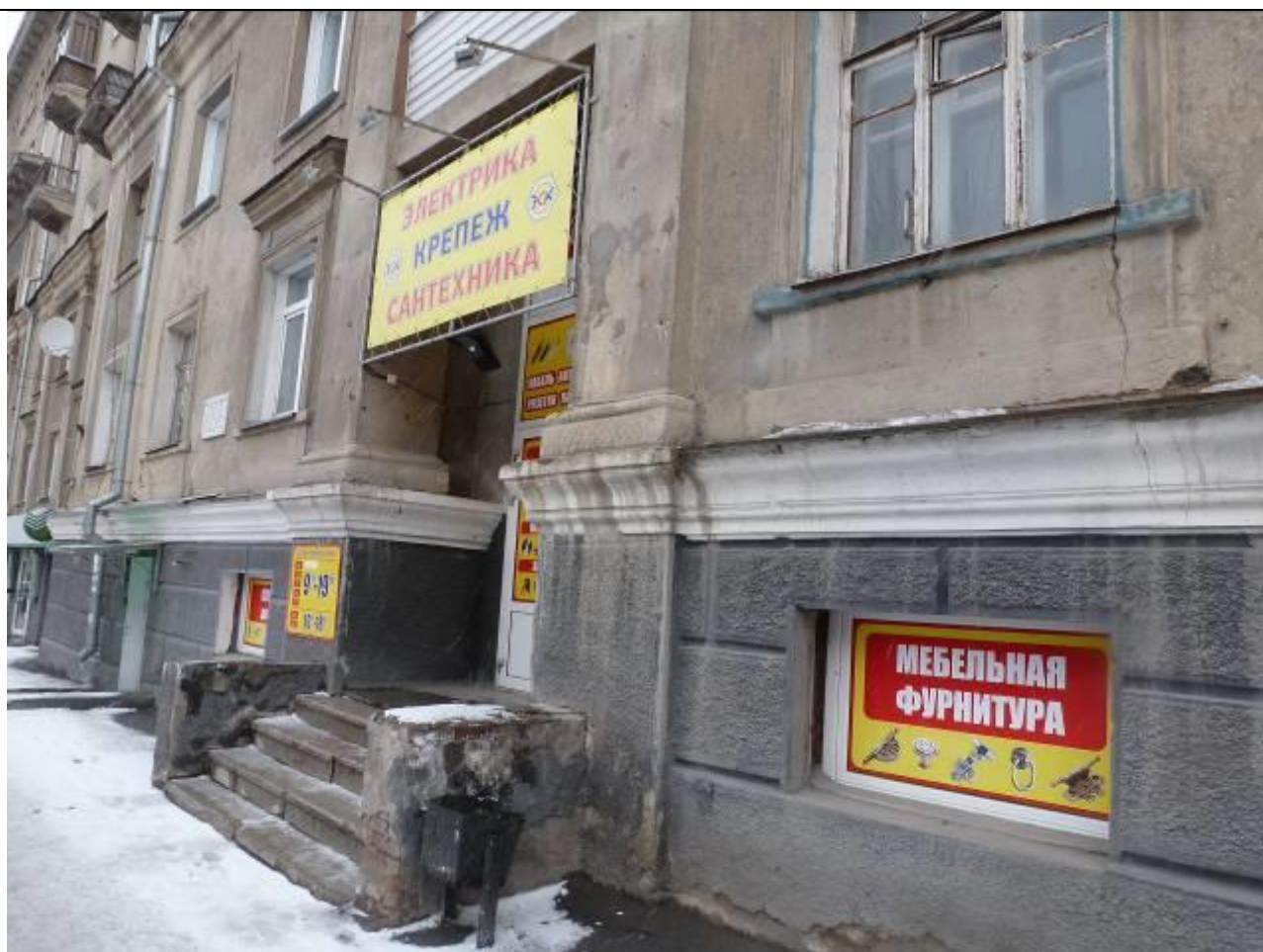
4.5. Южное крыло. Первоначальный вход на западном (главном) фасаде.
