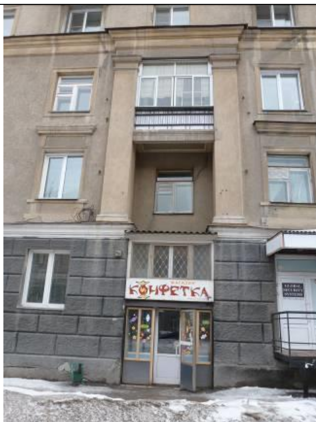
4.9. Фрагмент главного фасада. Северное крыло. Ниша парадного входа в подъезд № 5.
