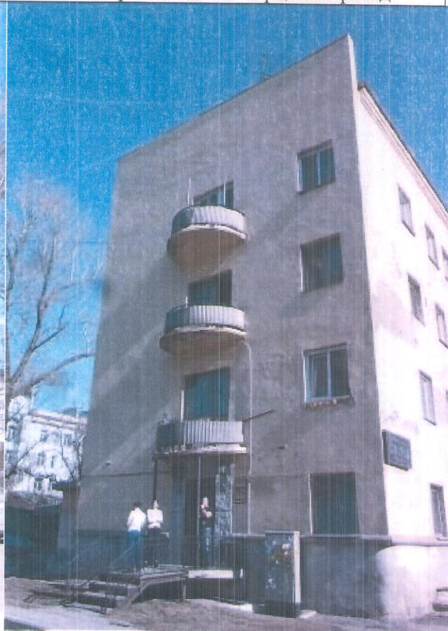
6. Северо-западный торцевой фасад
