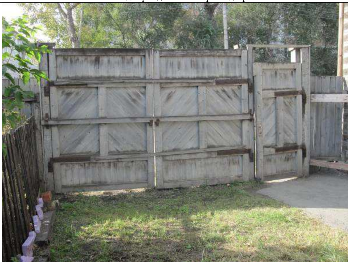
22. Вид ограждения со стороны двора
