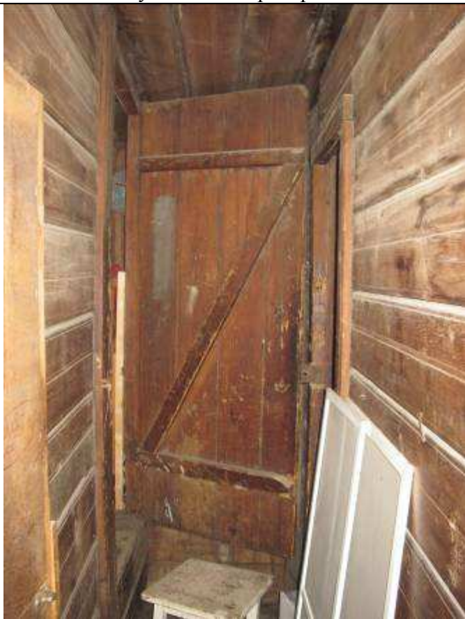
13. Дверь подсобного помещения в двухэтажной пристройке
