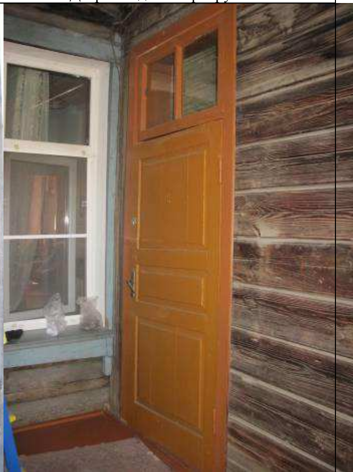
10. Дверь входа в квартиру 1 этажа
