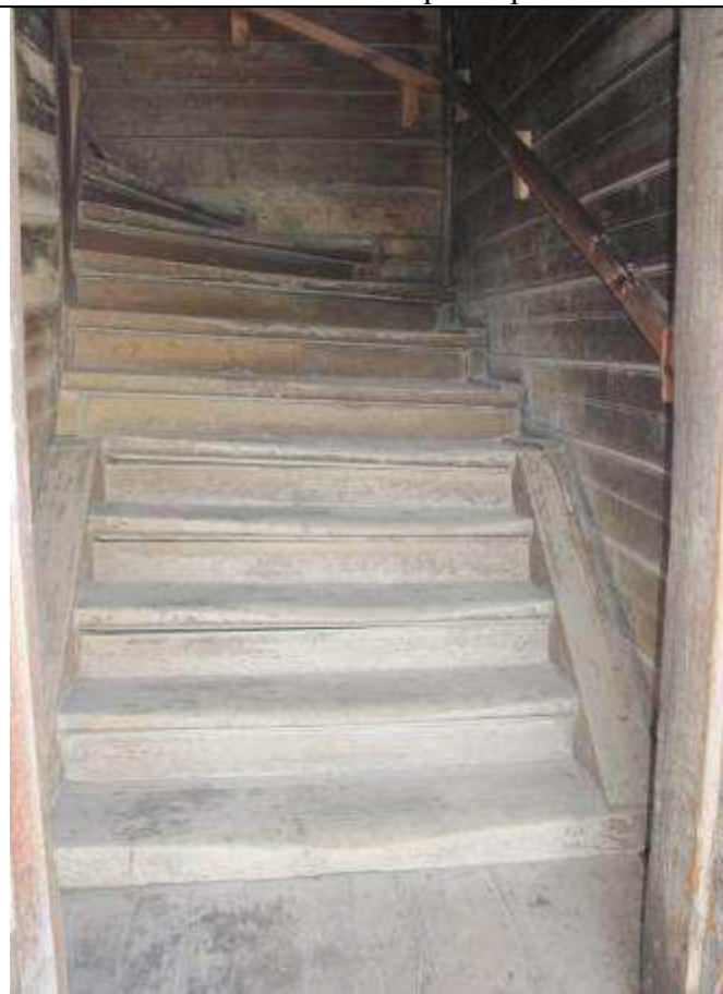
19. Лестничный марш первый
