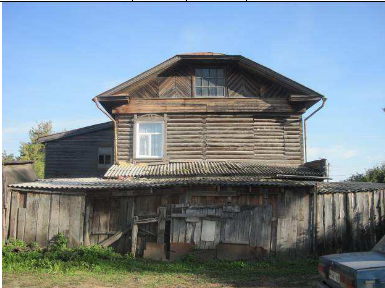
5. Фрагмент северо-западного фасада.
