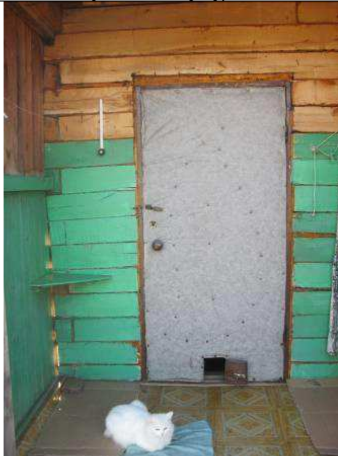
11. Дверь входа в квартиру 1 этажа.
