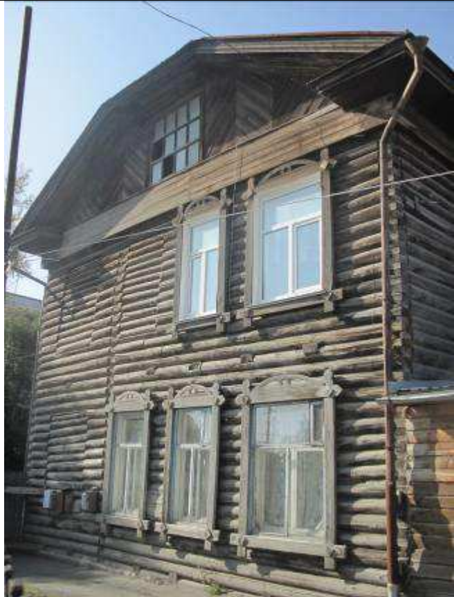
3. Фрагмент юго-восточного фасада.
