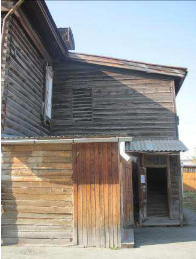
4. Фрагмент юго-восточного фасада.
