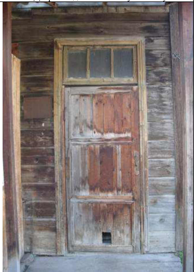
9. Дверь входа в лестничную клетку
