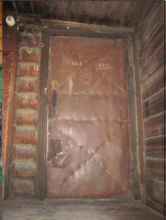
12. Дверь входа в квартиры 2 этажа.
