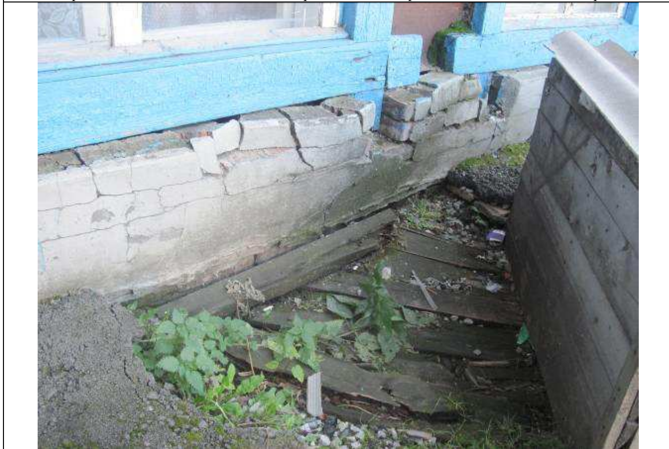
26. Фрагмент нижней части стены северо-восточного фасада. Место ввода теплотрассы.
