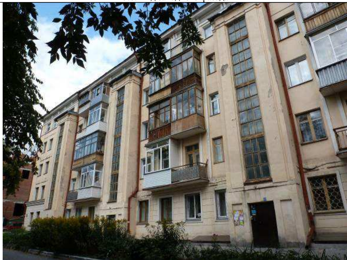
5.8. Вид западного фасада
