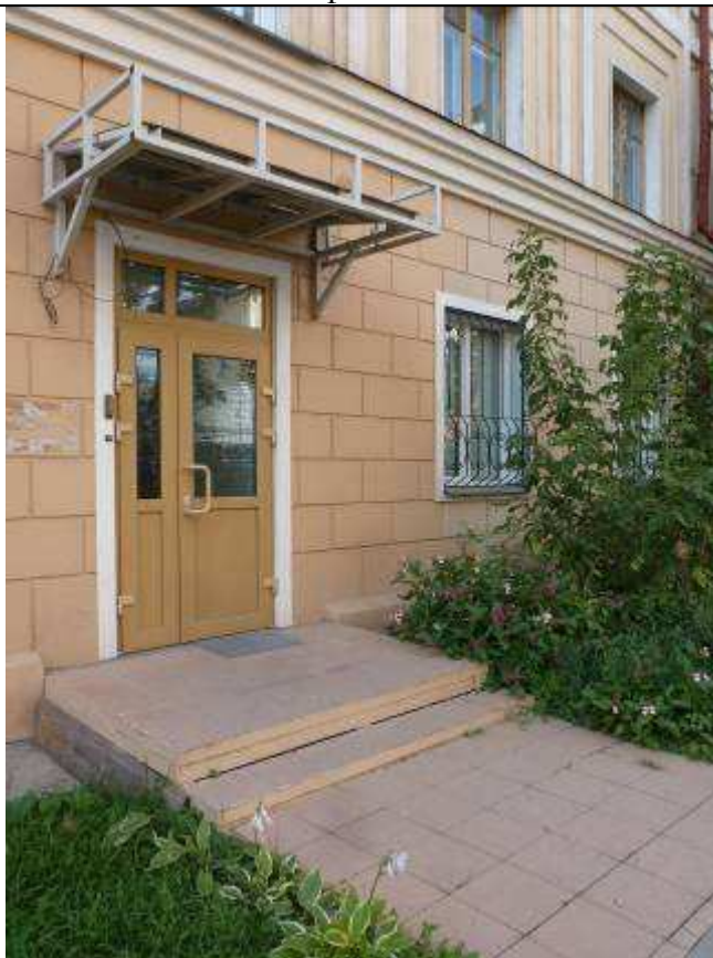
5.16. Вход в нежилые помещения, восточный фасад
