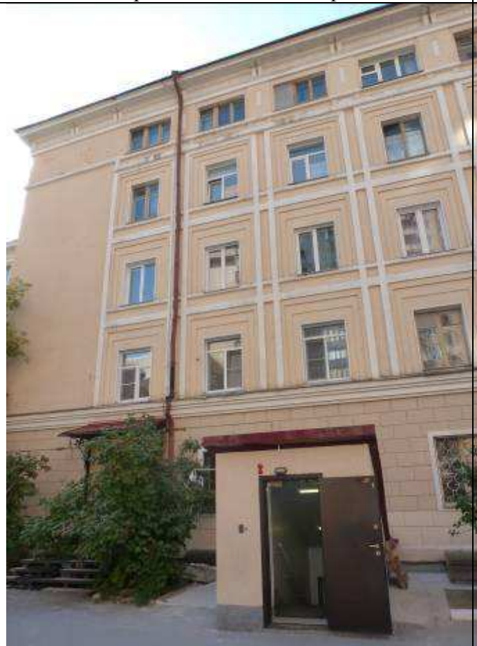
5.3. Фрагмент восточного фасада
