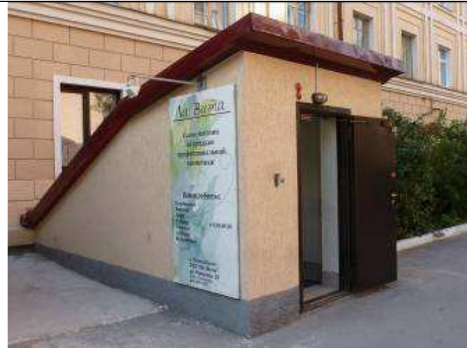
5.20. Приемок спуска в подвал, восточный фасад
