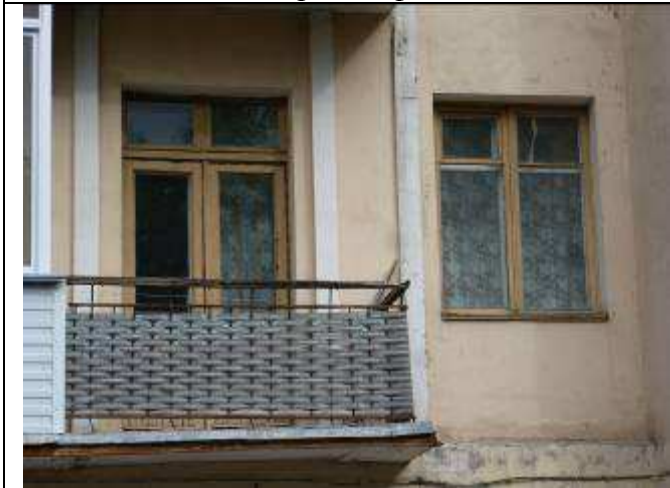
5.35. Первоначальный балконный блок и окно на дворовом фасаде
