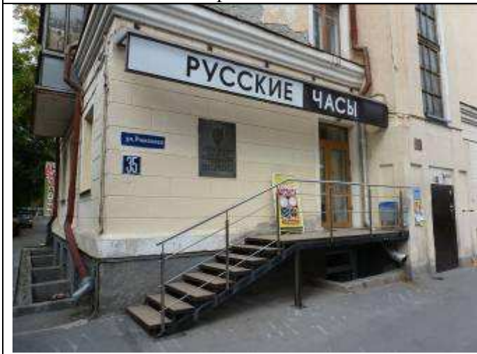
5.21. Вход в нежилые помещения, южный фасад
