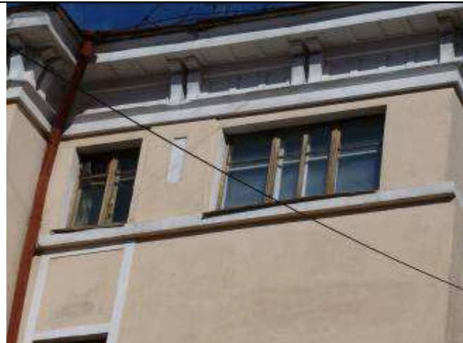
5.36. Первоначальные окна южного фасада
