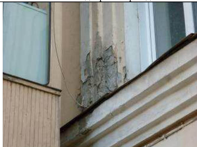
5.32. Угол дворовых фасадов
