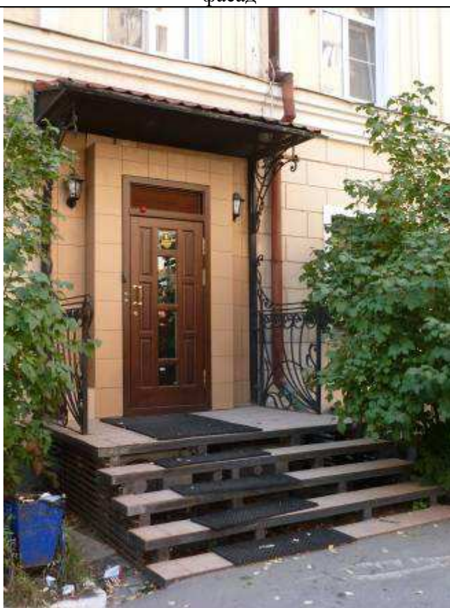
5.14. Вход в нежилые помещения, восточный фасад
