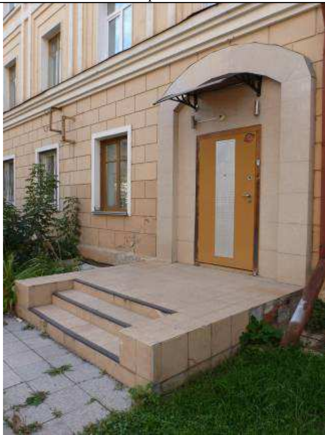
5.15. Вход в нежилые помещения, восточный фасад
