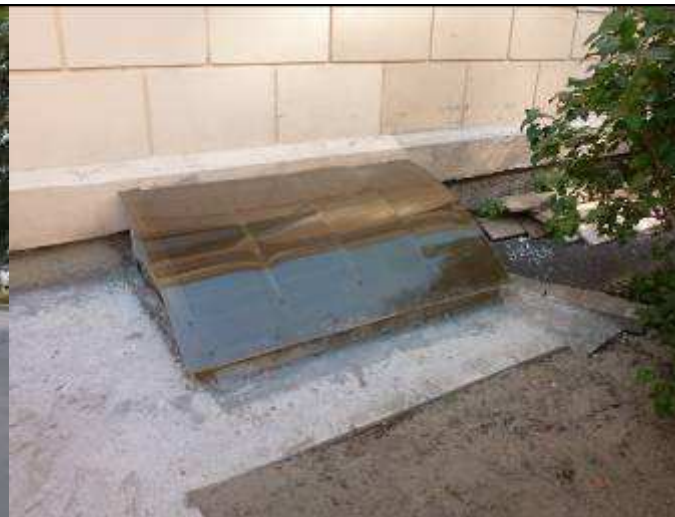
5.24. Световой приемок, восточный фасад
