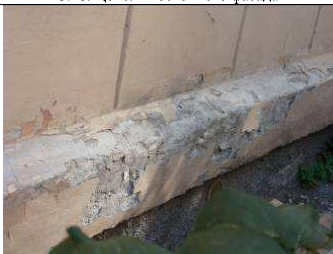
5.28. Цоколь восточного фасада
