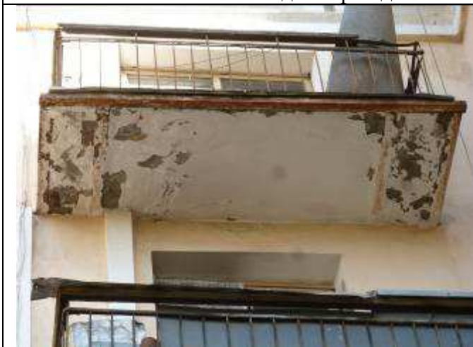
5.31. Балкон на западном фасаде
