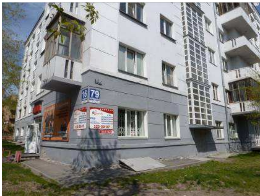
5.9. Фрагмент главного (южного) фасада. Размещение наружной рекламы.
