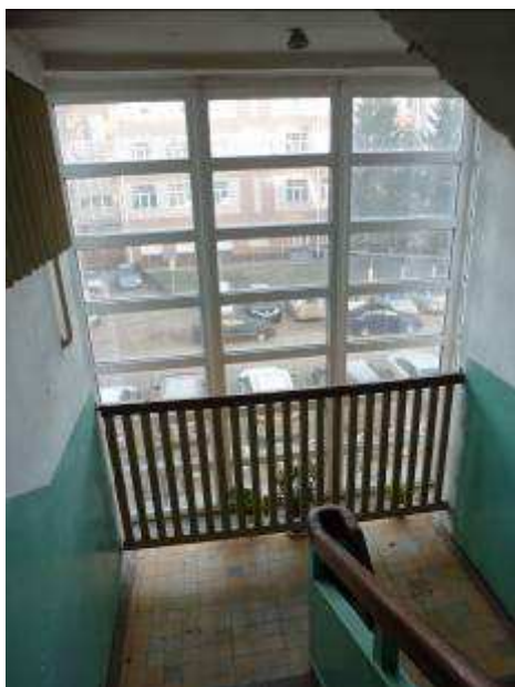
5.21 Вид лестничной клетки.
