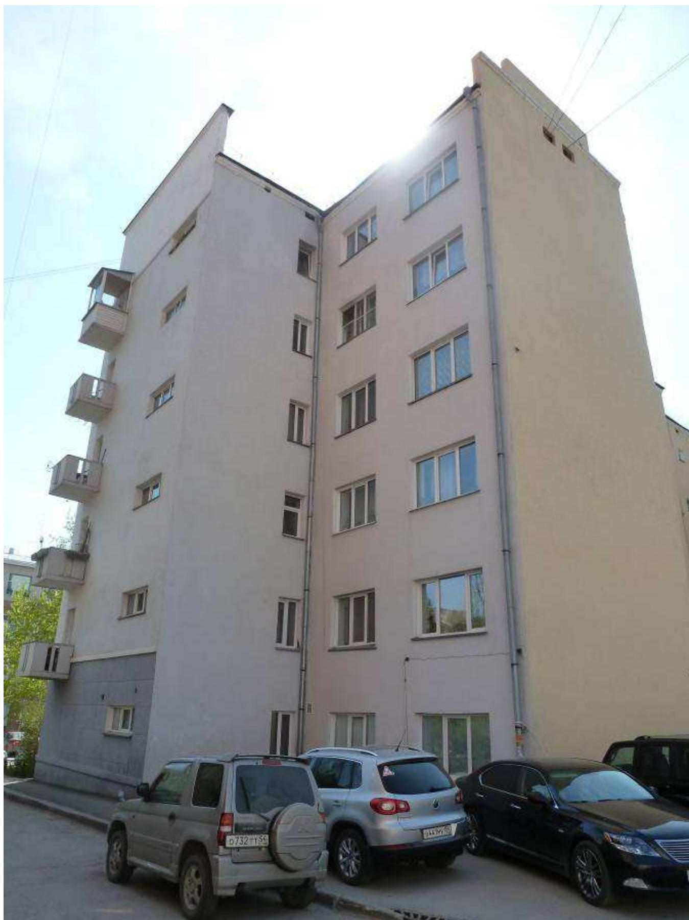
5.6. Общий вид бокового (восточного) фасада.
