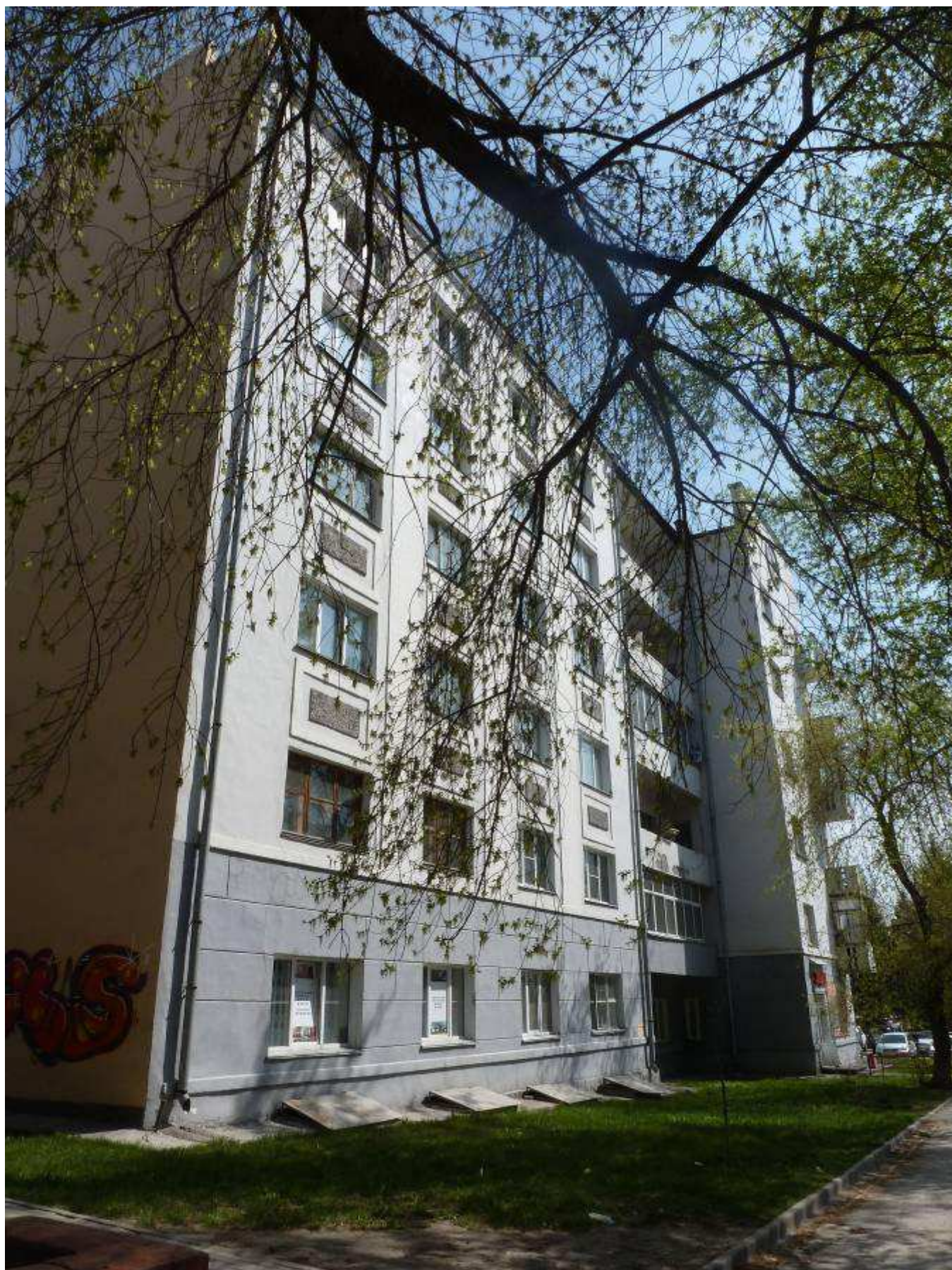
5.3. Вид западного фасада со стороны ул. Каменская.
