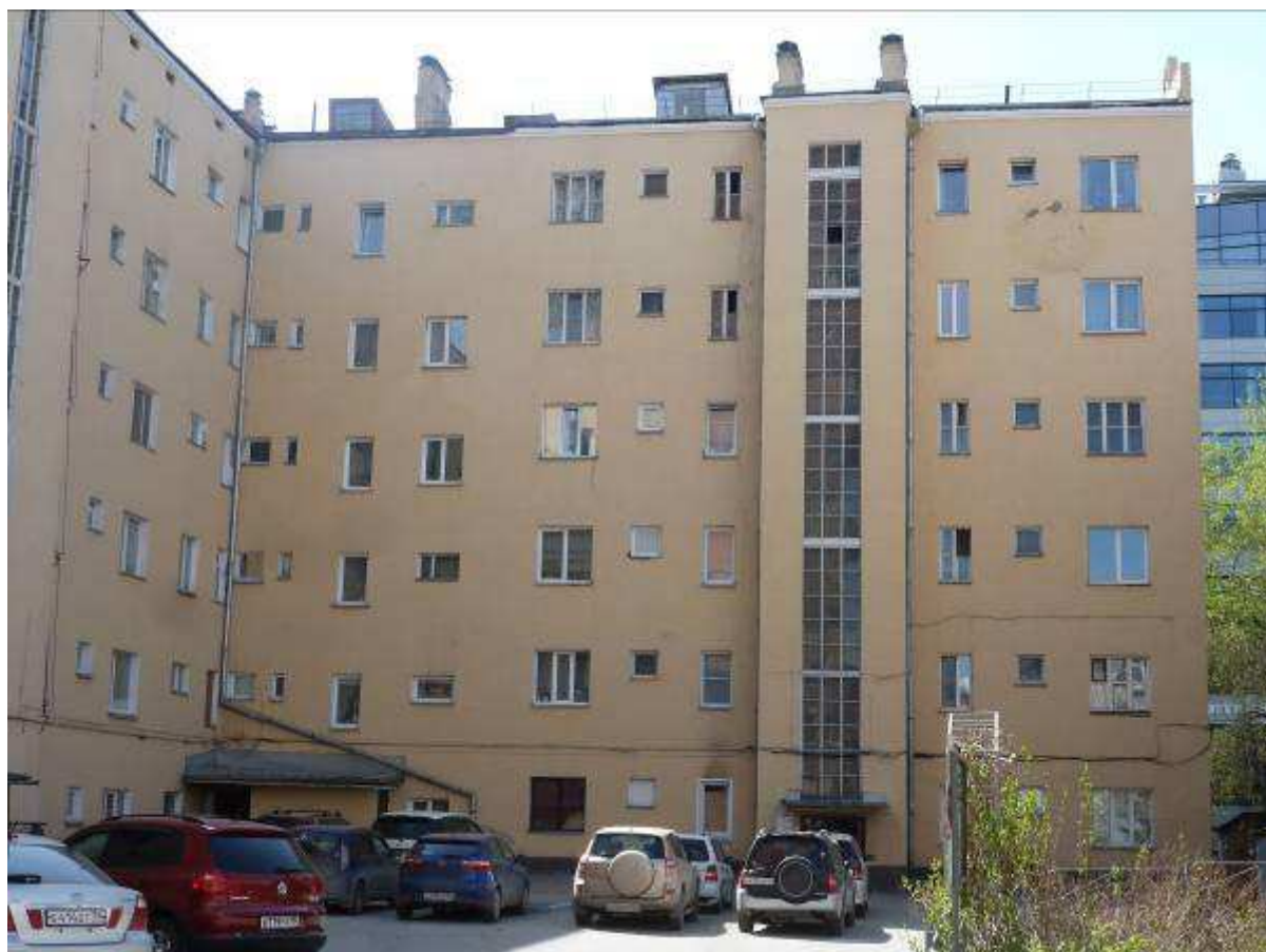
5.5. Вид восточного дворового фасада
