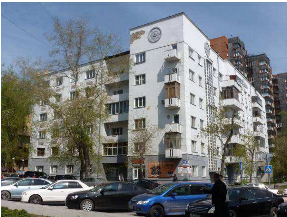
5.1. Общий вид главных фасадов.
