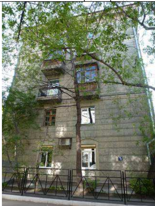
4. Восточный торцевой фасад
