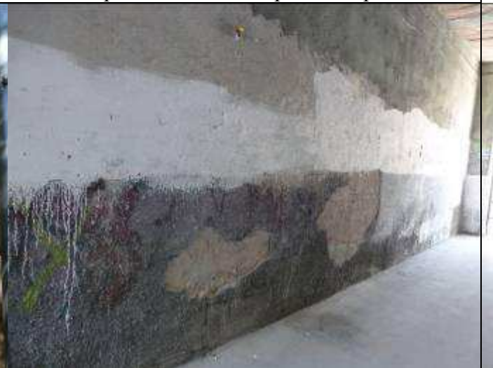
27. Фрагмент стены в арочном проезде
