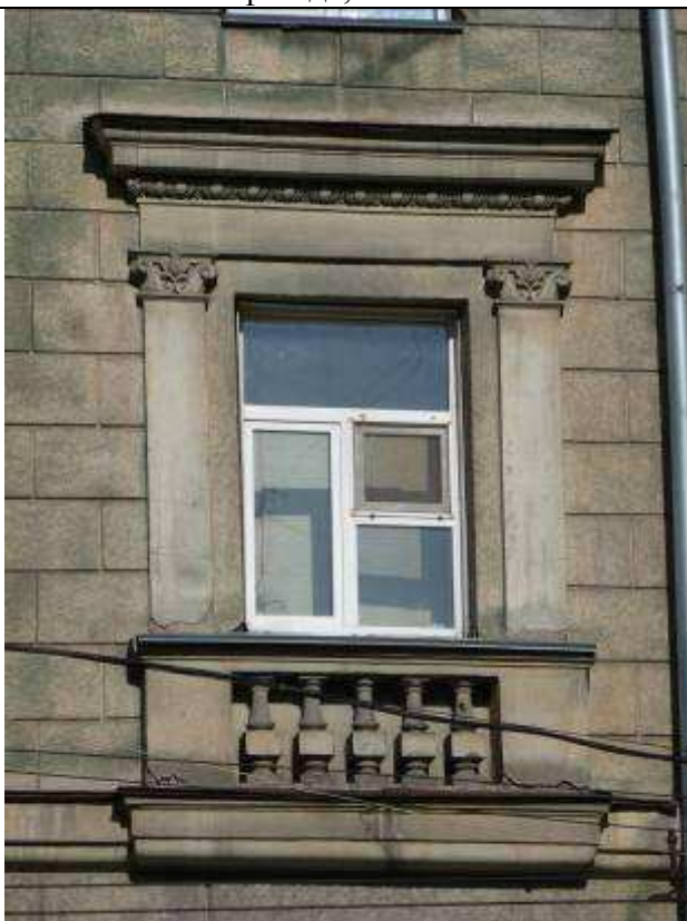
11. Оформление оконного проема на восточном фасаде, 3 этаж
