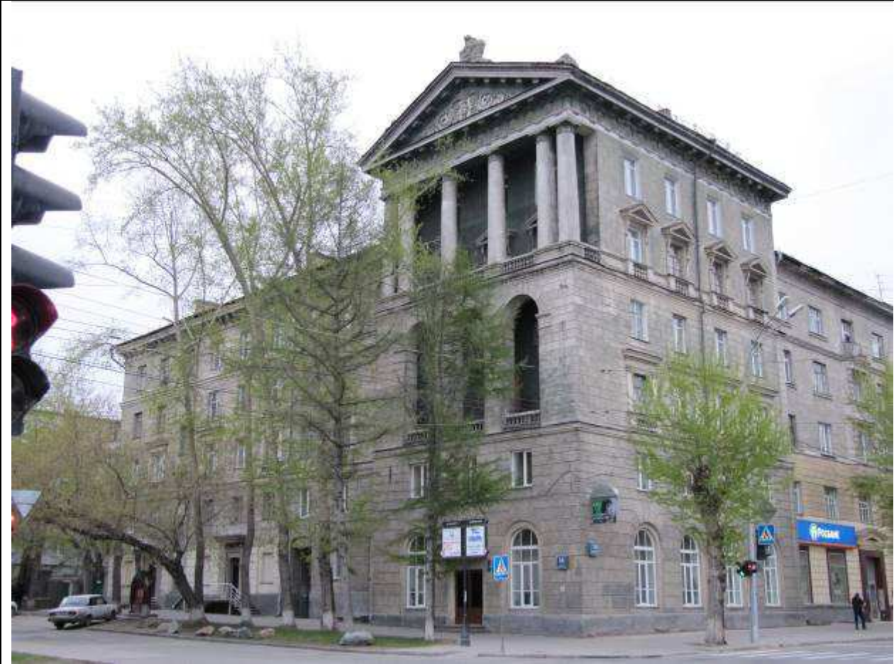
1. Северный и западный уличные фасады
