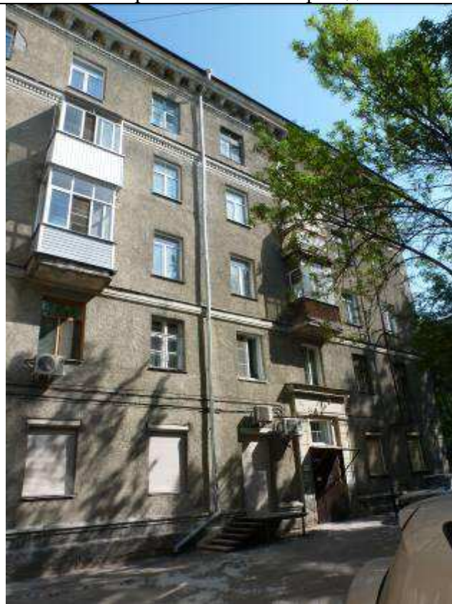
7. Фрагмент южного фасада
