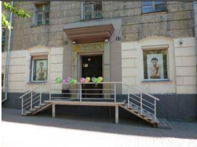
19. Входной узел в нежилые помещения, северный фасад
