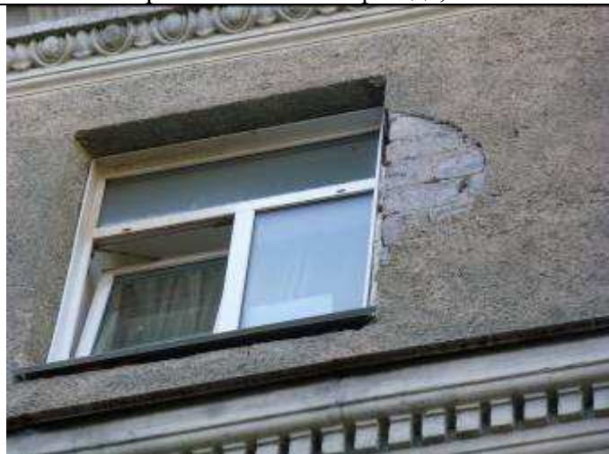
30. Фрагмент южного фасада, 5 этаж
