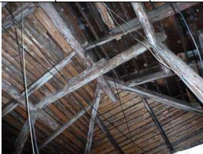
35. Фрагмент помещения чердака
