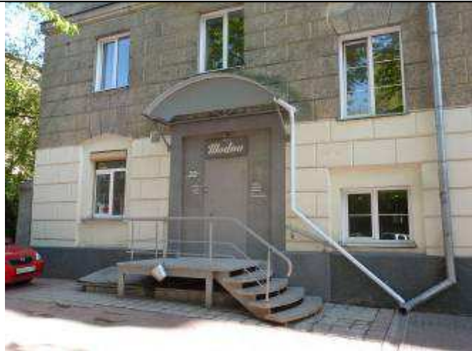
18. Входной узел в нежилые помещения, северный фасад
