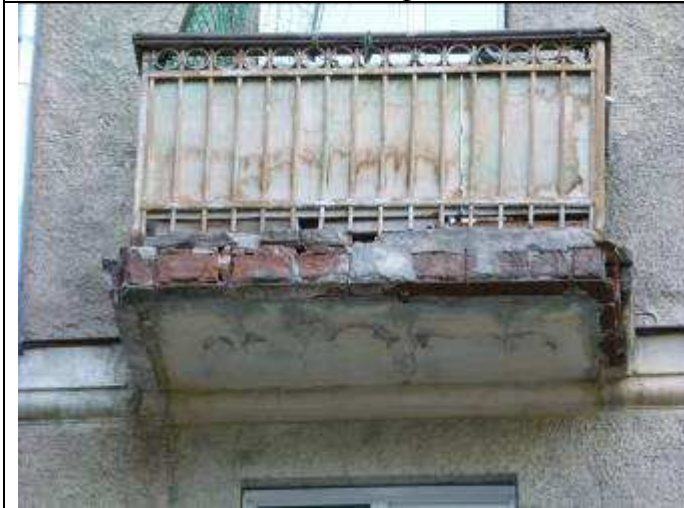
28. Балкон на южном фасаде, 3 этаж
