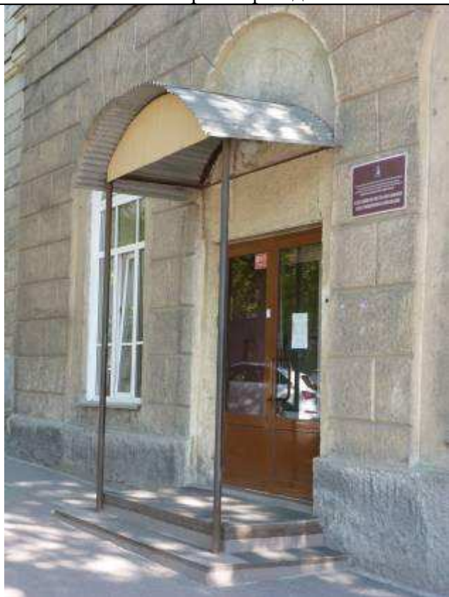
8. Входной узел в нежилые помещения, северный фасад
