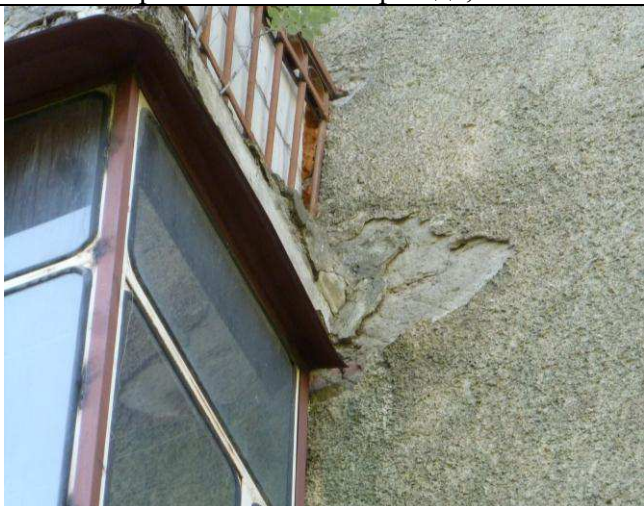
31. Фрагмент южного фасада, 4 этаж
