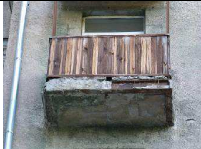
29. Балкон на южном фасаде, 4 этаж
