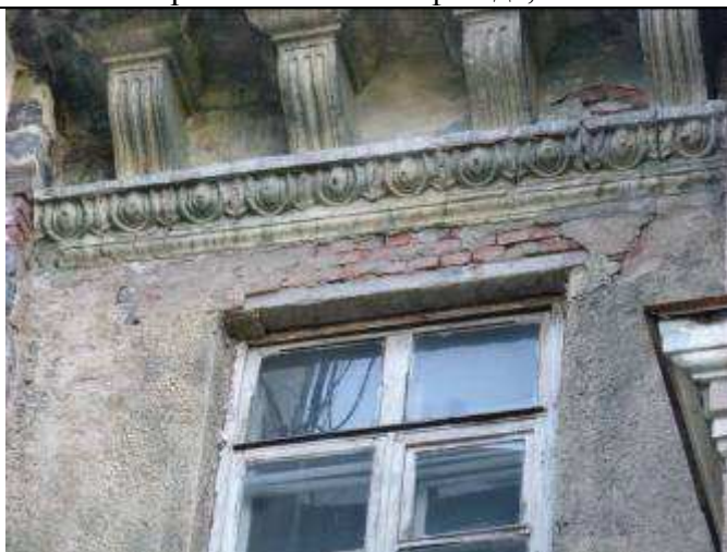
33. Фрагмент южного фасада, 5 этаж
