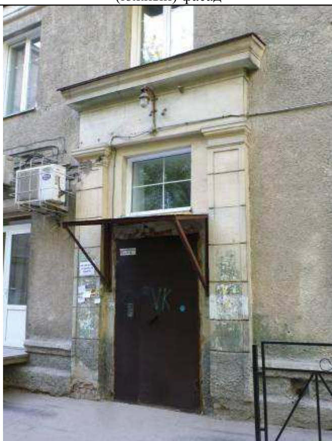
13. Входной узел в жилые помещения, дворовый (южный) фасад
