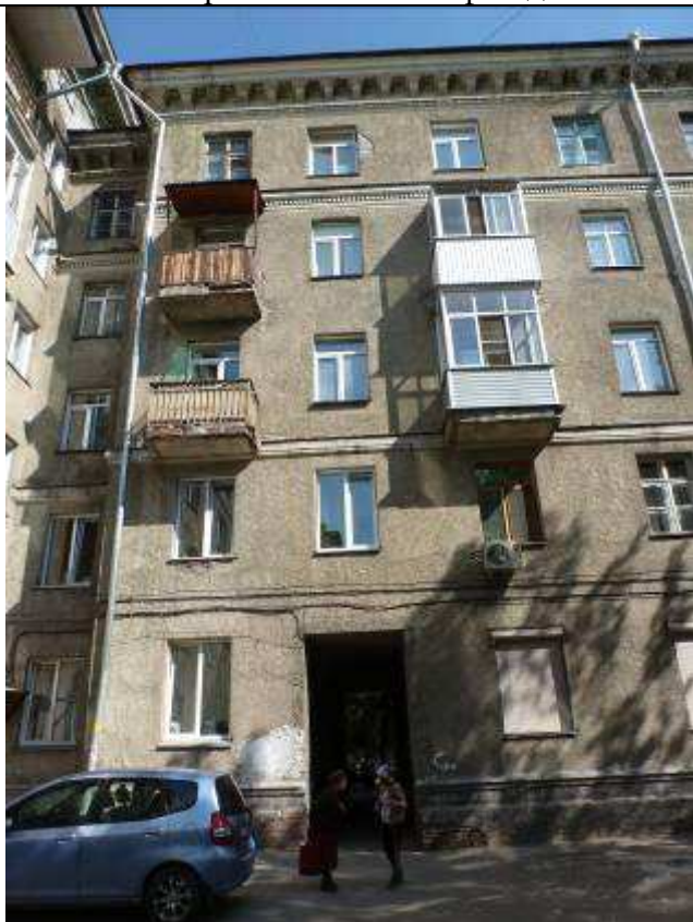
6. Фрагмент южного фасада
