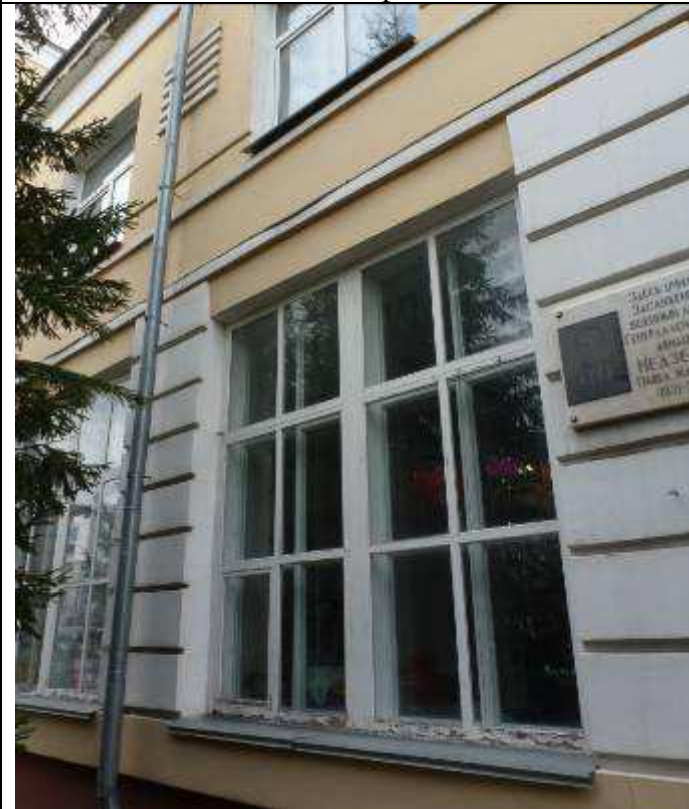
12. Первоначальные оконные переплеты, главный фасад
