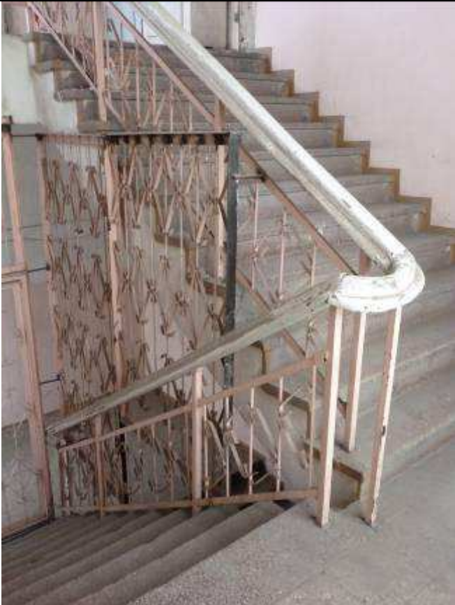
26. Фрагмент западной лестничной клетки
