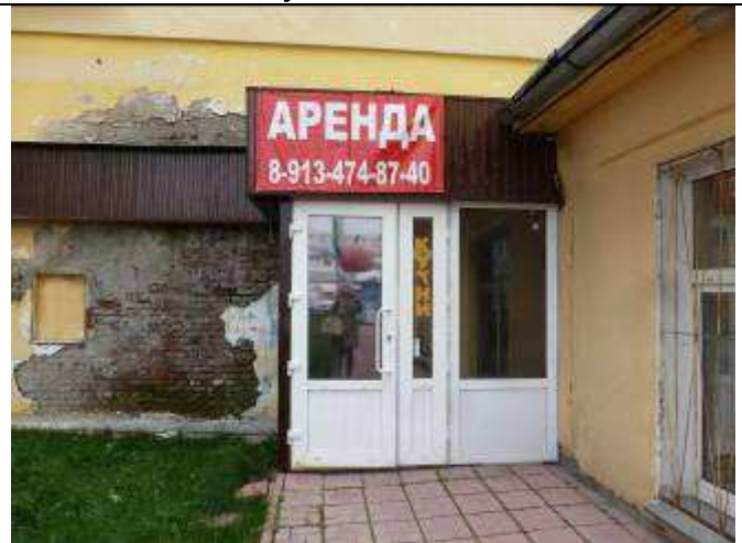
16. Входной узел в восточном объеме
