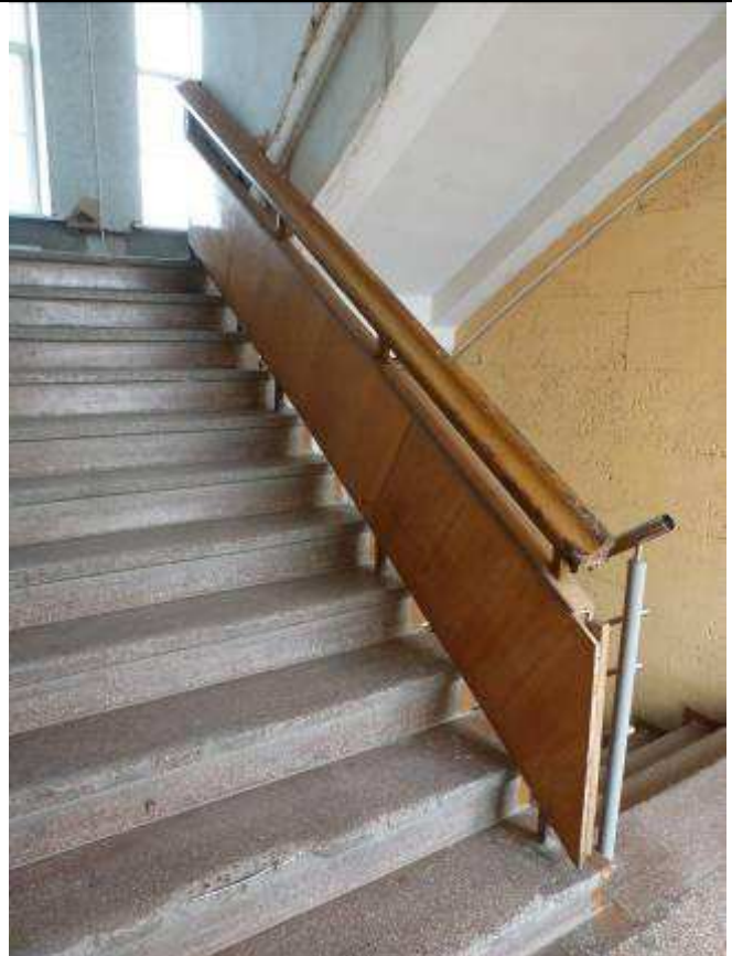
27. Верхний марш главной лестничной клетки
