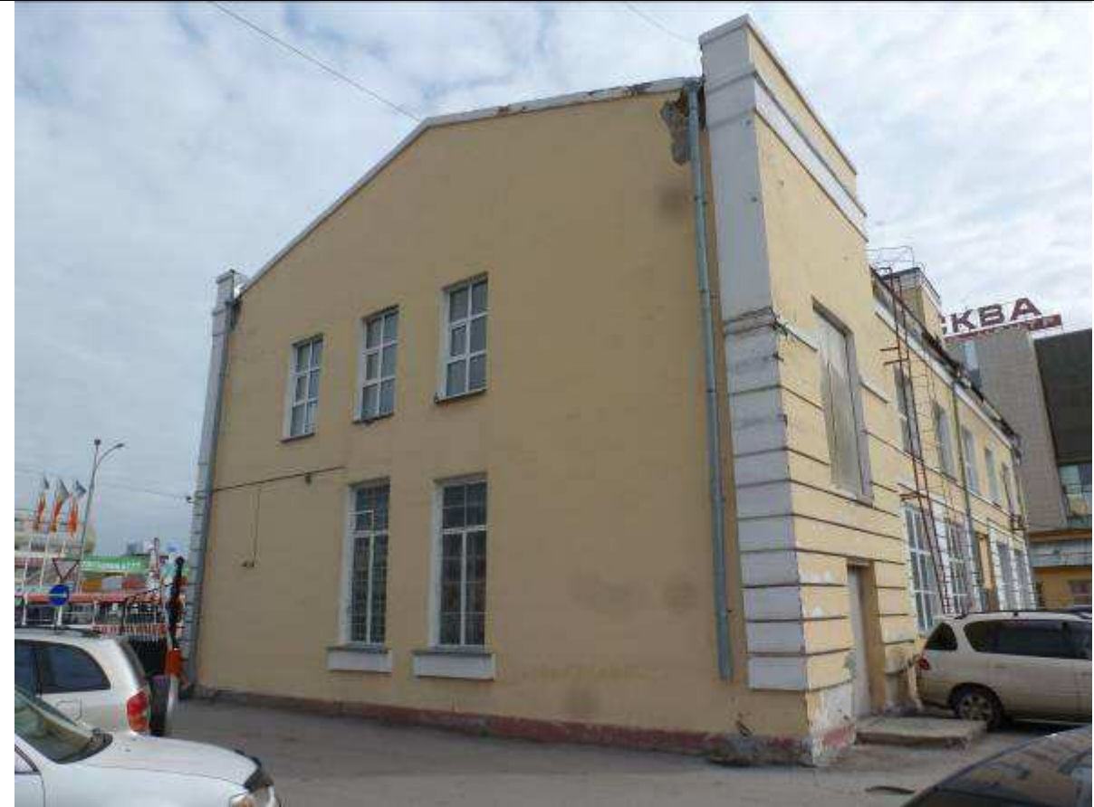
3. Западный (торцевой) фасад
