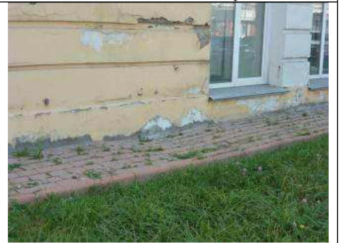
17. Отмостка на главном фасаде
