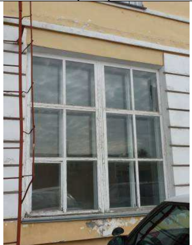
13. Первоначальные оконные переплеты, дворовый фасад
