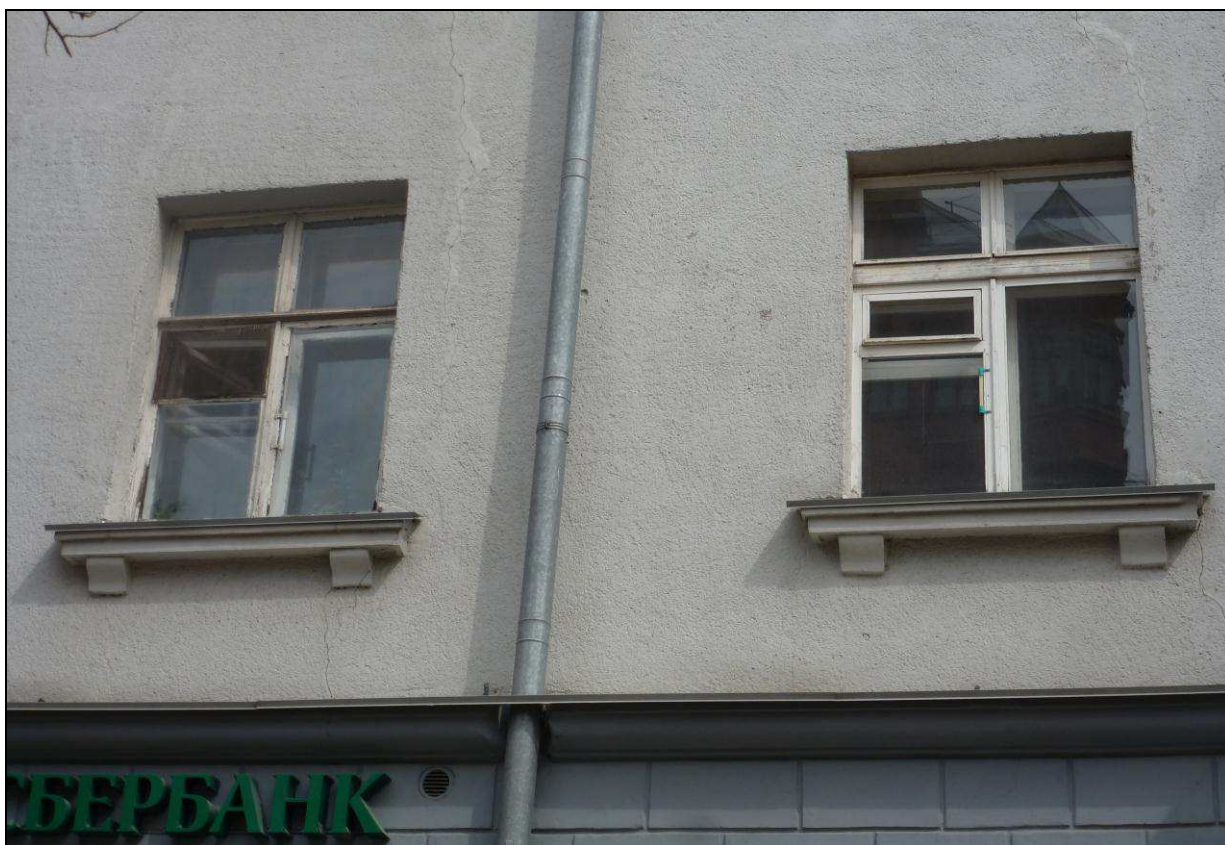
4.14. Фрагмент главного (западного) фасада. Первоначальные окна 2 этажа.
