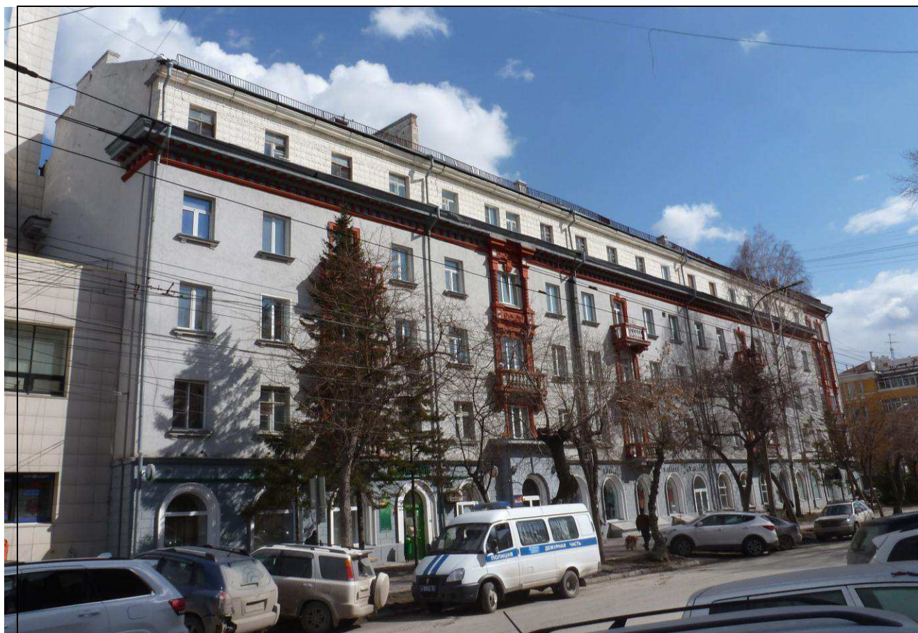
4.1. Общий вид западного (главного) фасада.
