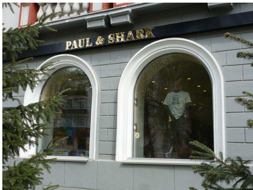
Южный угловой объем: карниз - рекламоноситель на западном фасаде (материалы согласования в архиве НПЦ отсутствуют).
