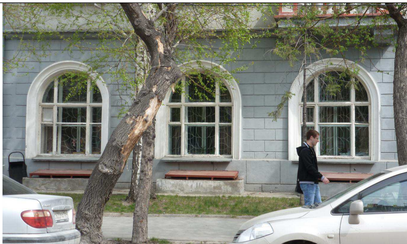
4.15. Фрагмент главного фасада. Деревянные окна на 1-м этаже.
