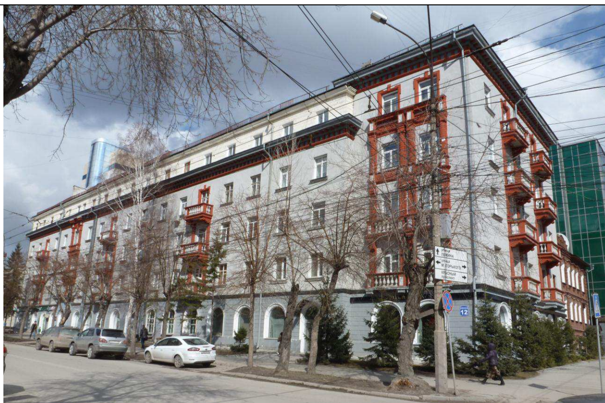
4.2. Общий вид фасадов: западного и южного (со стороны ул. Чаплыгина).
