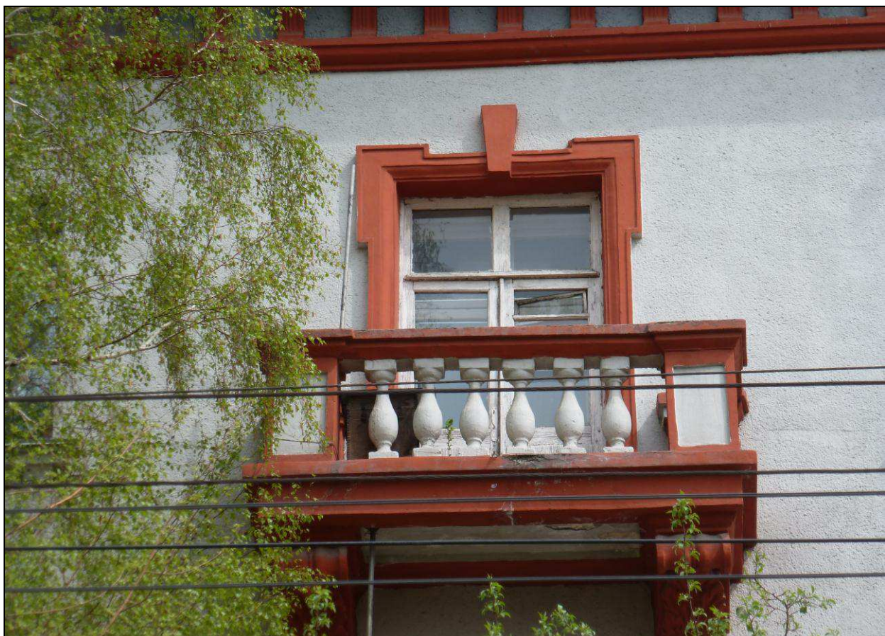
4.13. Фрагмент главного фасада. Первоначальное ограждение и дверь балкона на 4-м этаже.
