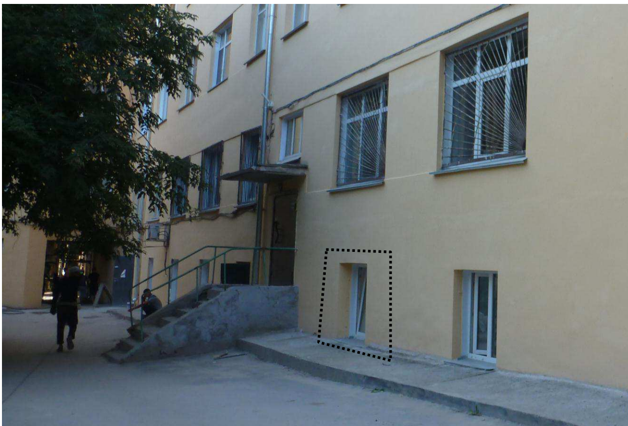
5.17. Фрагмент дворового (восточного) фасада. Окно в бывшем дверном проеме.
