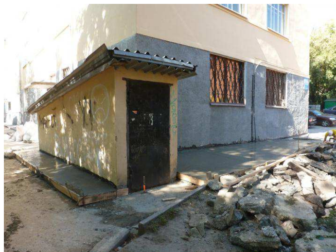
5.14 Фрагмент восточного (бокового фасада).
