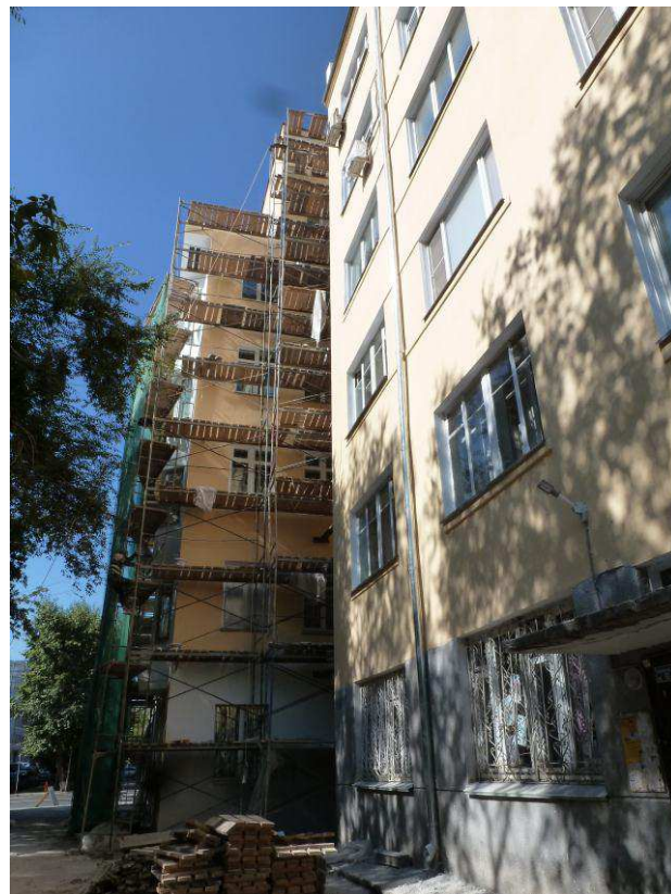
5.4. Фрагмент южного фасада.
