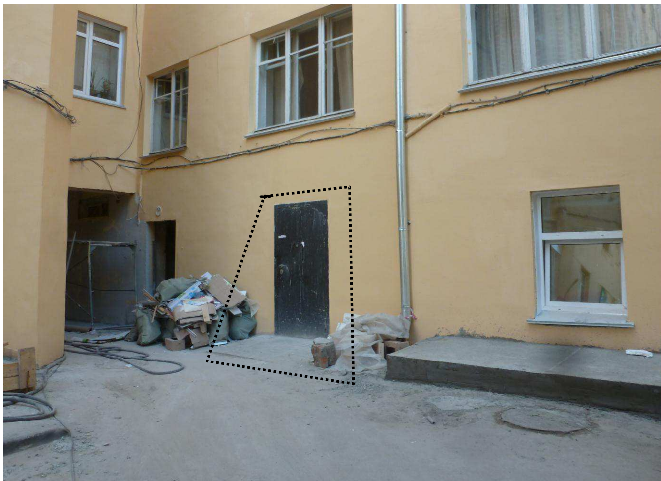
5.15. Фрагмент восточного (дворового) фасада. Оконный проем реконструирован в дверной.
