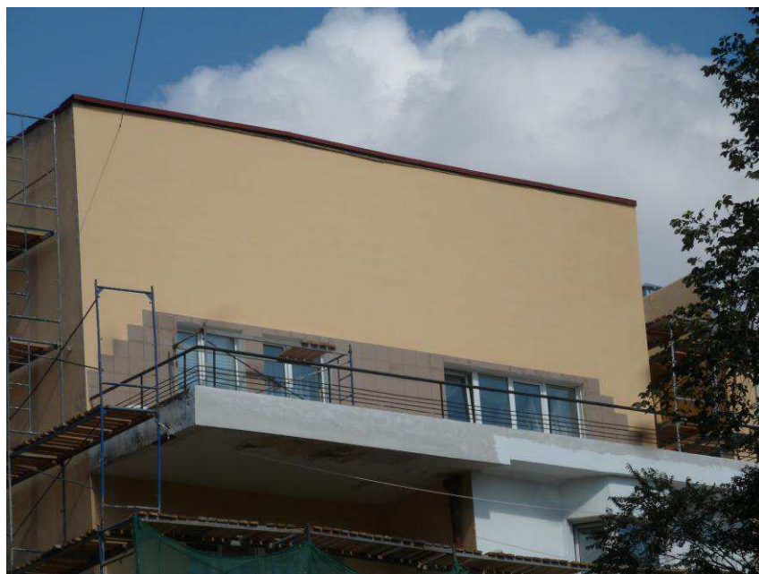
5.10. Фрагмент фасада углового объема. Поздние наслонения в уровне 5-го этажа.
