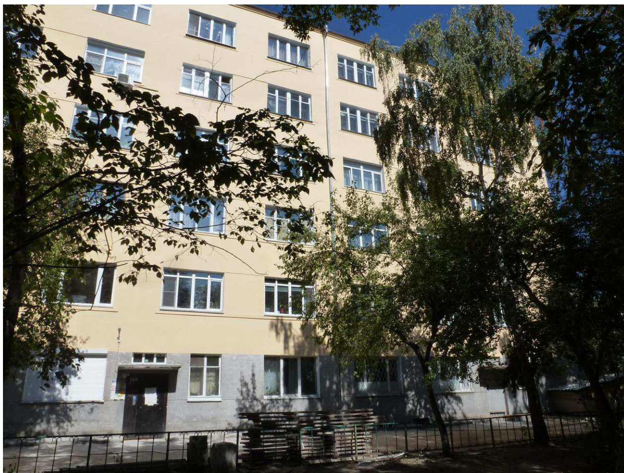
5.5. Фрагмент южного фасада.
