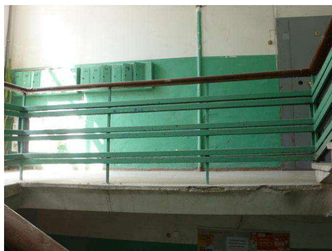
5.23. Предмет охраны – деревянные ограждения лестниц.
