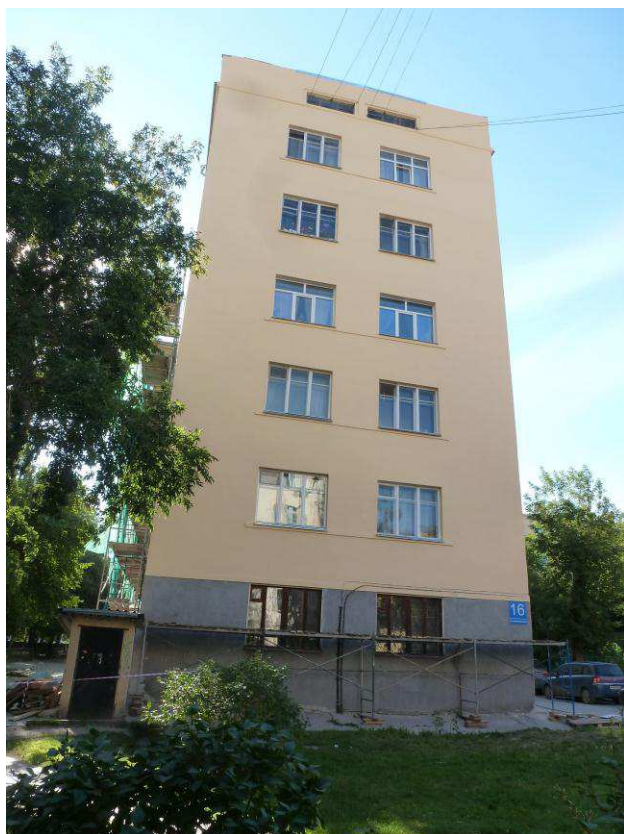
5.6. Вид бокового восточного фасада.
