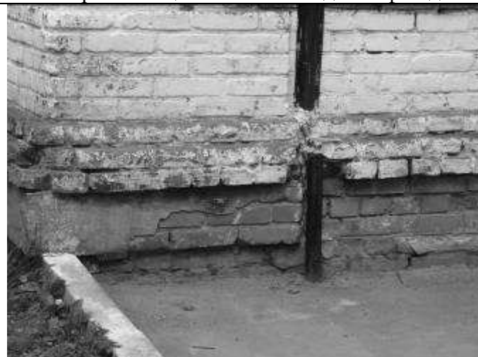
16. Фрагмент цоколя юго-западного фасада
