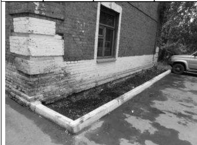
15. Фрагмент северо-восточного фасада
