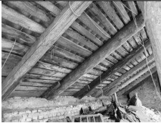
22. Фрагмент помещения чердака
