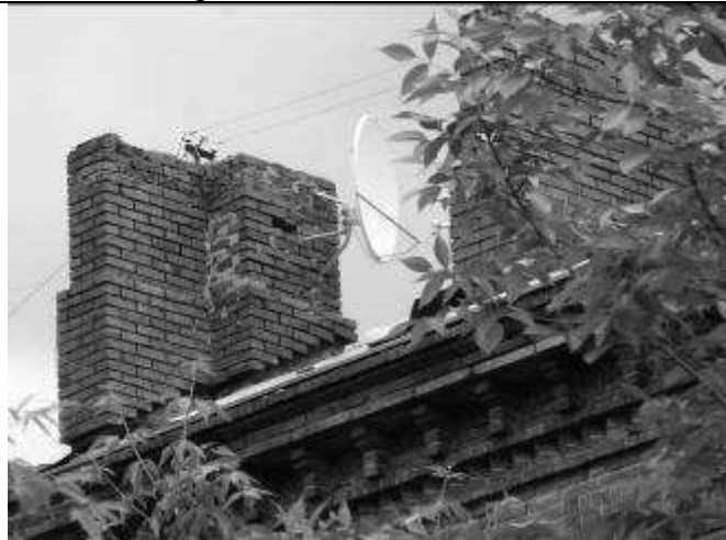
21. Завершения вентиляционных шахт
