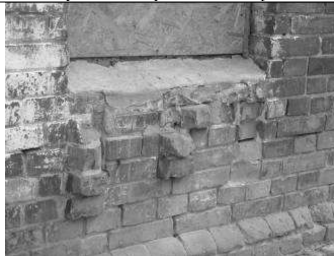
23. Фрагмент северо-восточного фасада
