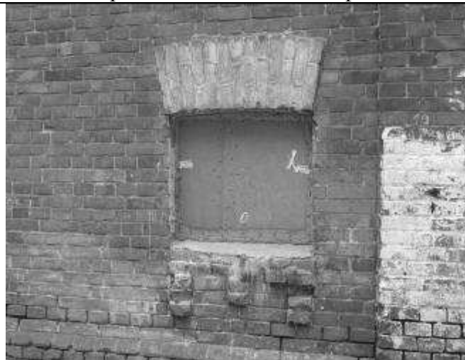
24. Фрагмент юго-западного фасада
