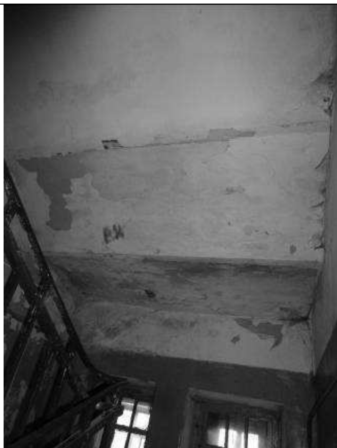
30. Сводчатое перекрытие в лестничной клетке
