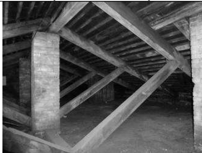
18. Фрагмент помещения чердака
