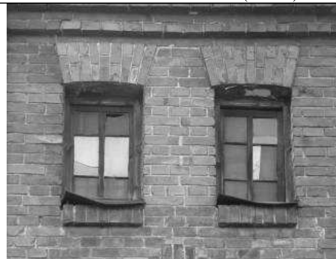
26. Окна лестничной клетки (3 этаж)
