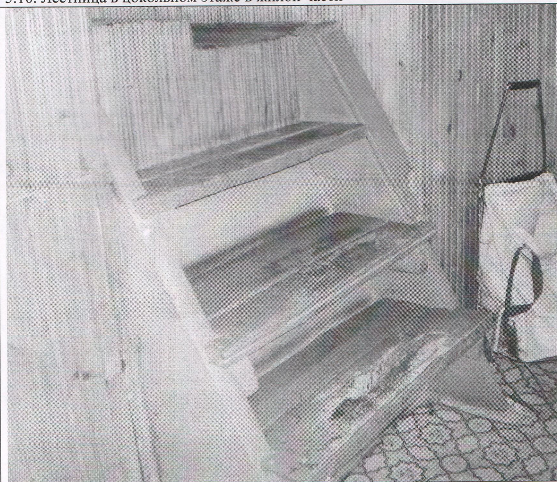
5.10. Лестница в цокольном этаже в жилой части
