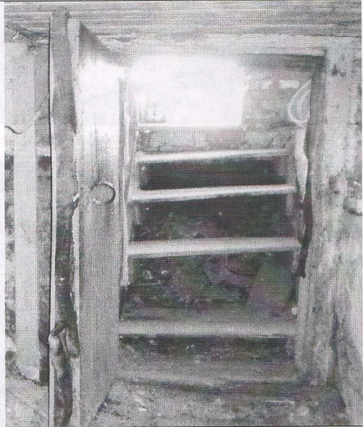
5.14. Лестница в цокольный этаж со стороны северного фасада.
